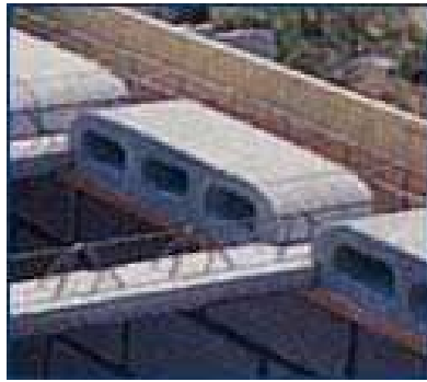
Figura 5.8 Colocación de bovedilla sobre viguetas de alma abierta, para una losa de entrepiso.
