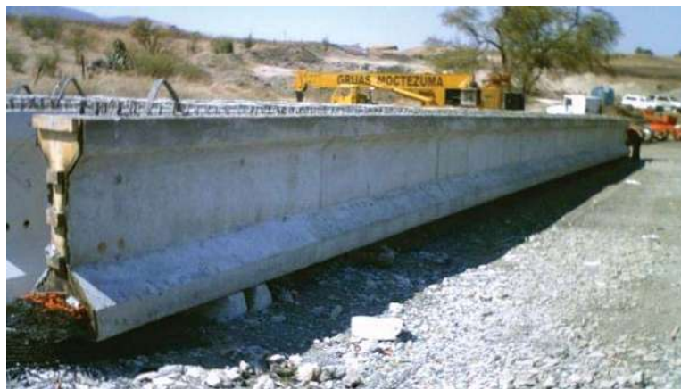
Figura 2.4 Fabricación de un elemento pretensado.
