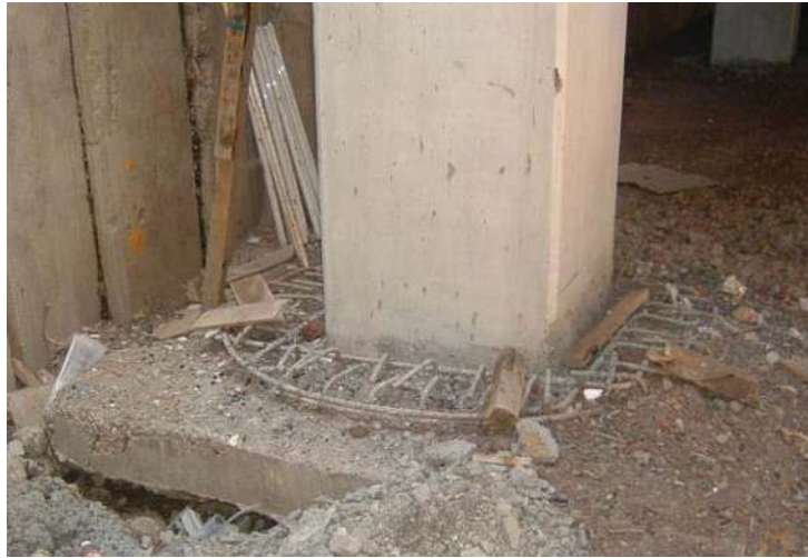
Figura 3.5 Conexión fuerte entre pilote candelero y columna.
