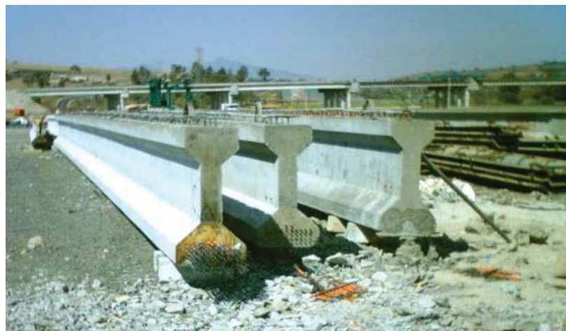
Figura 1.2 Fabricación en serie de vigas pretensadas.
