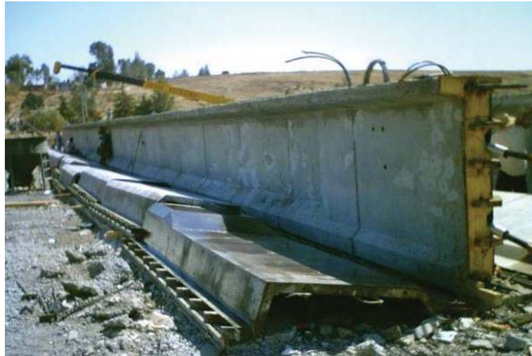
Figura 1.1 Desmolde de una trabe prefabricada, lo que nos hace referencia a la modulación de una serie de elementos precolados.
