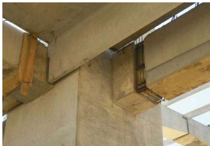
Figura 3.3 Conexión húmeda entre traveses portantes y columna.
