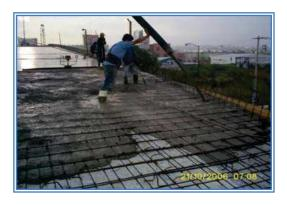
2.- El vibrado del concreto se hizo en un tiempo no mayor de 30 minutos después de su vaciado, el acomodo y compactación de la revoltura se efectuó dé manera que llene totalmente los moldes, sin dejar huecos en su masa.
