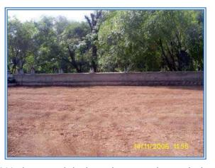
procedente de la banco "cerritos" y un 30% de material triturado procedente de la trituradora "Tarasca", extendida con motoconformadora y vibrocompactador neumático duopactor al 100% de su P.V.S.M.
