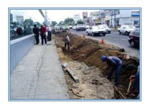
2.- En el área donde se construyeron las ampliaciones y en los empates de las rampas con los pavimentos existentes, se abrió una excavación en caja con una profundidad de hasta 2.50m de material tipo "B" esto se hizo por medios mecánicos.
