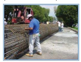
colocación, la superficie de las varillas y de los soportes metálicos de estas, se limpiaron de óxido, polvo, grasa u otras sustancias, manteniéndose en estas condiciones hasta que se ahogo en concreto.
