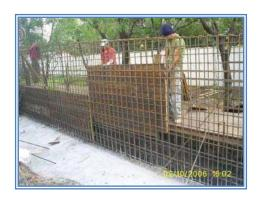
3.- Se procedió con el habilitado del acero del estribo y del muro de contención, con un fy=4200 kg/cm<sup>2</sup>.
