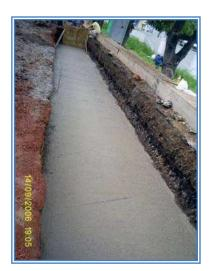
Se utilizó concreto pobre f'c = 100 kg/cm², de 10 cm de espesor, se utilizó duela de madera de pino de tercera de 1" x 4", acero de refuerzo con un fy = 4200 kg/cm², se le suministro concreto premezclado f'c = 250kg/cm², TMA = 1".
