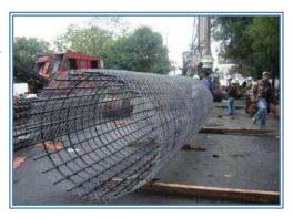
5.- La colocación del acero de refuerzo se hizo con el uso de una grúa con la altura suficiente que permitió una introducción vertical de todo el armado.
