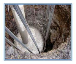
7.- Para la colocación del concreto fue mediante el empleo de un tubo-embudo adicionado con los accesorios necesarios para evitar la segregación del concreto hidráulico y tener una caída mayor de 1.5 metros. Estando siempre el
