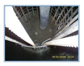
5.- Una vez colocado el acero de refuerzo se continúo con el suministro del concreto premezclado de una resistencia de 250 Kg/cm. La compacidad no fue menor a 0.8, el revenimiento mínimo de 6 a 8 cms. Y el agregado grueso de tamaño máximo 1.91 cms.
