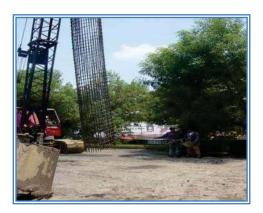
6.- Una vez que fue colocado el acero de refuerzo se continuó con el suministro del concreto premezclado de una resistencia de 250 Kg/cm. La compacidad no fue menor a 0.8, el revenimiento mínimo de 6 a 8 cms. Y el agregado grueso de tamaño máximo 3.8 cms. Tomando los siguientes cuidados:
