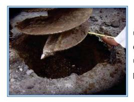
1.- Se procedió a realizar la excavación a una profundidad de hasta 19m y un diámetro de 1.3m, quedando desplantadas a un metro dentro del estrato resistente, las paredes de la excavación fueron
