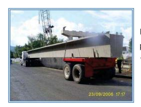
D-TR8002, D-TR8004, D-TR8005, D-R8006, D-TR8007, se colocaron trabes preforzada 01 de 22 m, 02 de 20 m, 03 de 18.50 m, 04 de 16.00 m, 05 de 13.20 m
