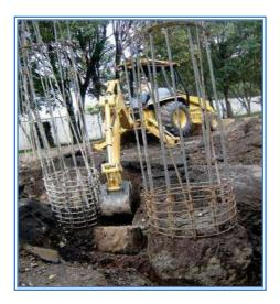
3.- Previamente al cimbrado de la columna se aplico un martelinado a la pila, con la finalidad de dejar una superficie áspera o con los agregados expuestos. 4.- Se procedió con el habilitado del acero se utilizo varilla de 1/2", 1" de grado duro,
