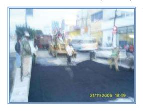
tamaño máximo de 3/4" a finos, previamente a la construcción de la carpeta de concreto asfáltica se procedió a efectuar un barrido enérgico en todo lo ancho de la sección, con el objeto de eliminar el polvo y materias extrañas que puedan afectar la adherencia entre capas, posteriormente se aplico un riego de liga a razón de 0.60
