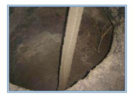
Debido a la mecánica de suelos de la zona, en la pila 6-A se tuvo mucha socavación en la primera perforación, se trato como alternativa de solución hacer un ademe y realizar la excavación. Dicha alternativa no funciono.
