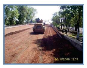
1.- Se construyó una capa de sub-base hidráulica que oscilo entre los 19 y 20cm de espesor compactado al 100% de su P.V.S.M. (1831kg/cm³), Para la construcción de dicha capa se empleo una mezcla 30% de material pétreo triturado procedente de la "Trituradora Tarasca", y un 70% de tezontle inerte
