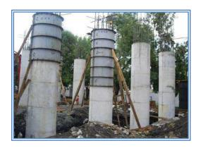
Descimbra 1.20m., en pilas, utilizando triplay de 16 mm de espesor. Incluye lámina galvanizada en interior hasta 8 m de altura.
