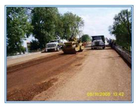
3.- Con el objeto de proteger la capa de base hidráulica se aplico un riego de impregnación con emulsión asfáltica del tipo rompimiento lento elaborada con cemento asfáltico AC-5,
