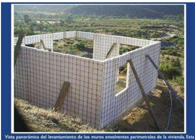
Vista panorámica del levantamiento de los muros envolventes perimetrales de la vivienda. Esta instalación se realizó con mano de obra no especializada en el lapso de tres horas. Vista que permite apreciar la pendiente donde fue emplazada esta construcción
