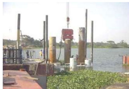
COLOCACIÓN DE CONCRETO, EXTRACCIÓN DE ADEME Y TERMINACIÓN DE PILA.
