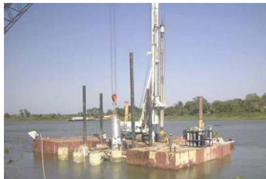
COLOCACIÓN DE TUBO ESPIRODUCTO.
