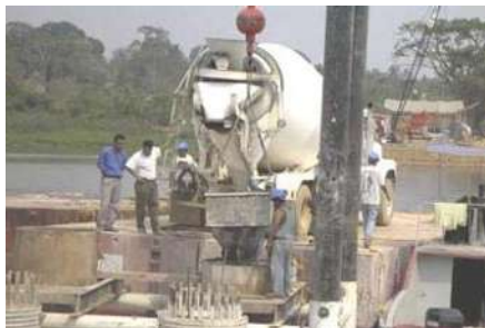
COLOCACIÓN DE CONCRETO, EXTRACCIÓN DE ADEME Y TERMINACIÓN DE PILA.
