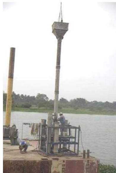
LAVADO DE PERFORACIÓN Y ARMADO DE TUBERÍA TREMIE.
