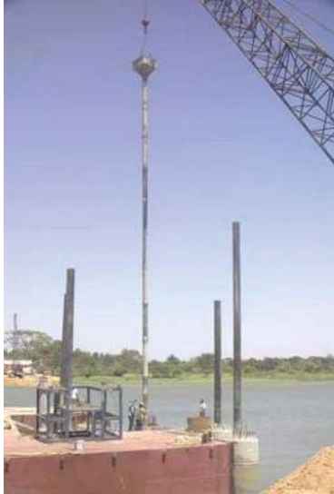
COLOCACIÓN DE TUBERIA TREMIE Y TRASLADO DE CONCRETO.
