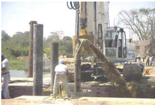
LAVADO DE PERFORACIÓN Y ARMADO DE TUBERÍA TREMIE.
