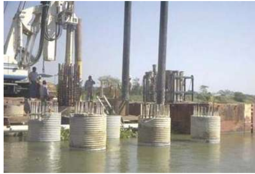
COLOCACIÓN DE ACERO DE REFUERZO.
