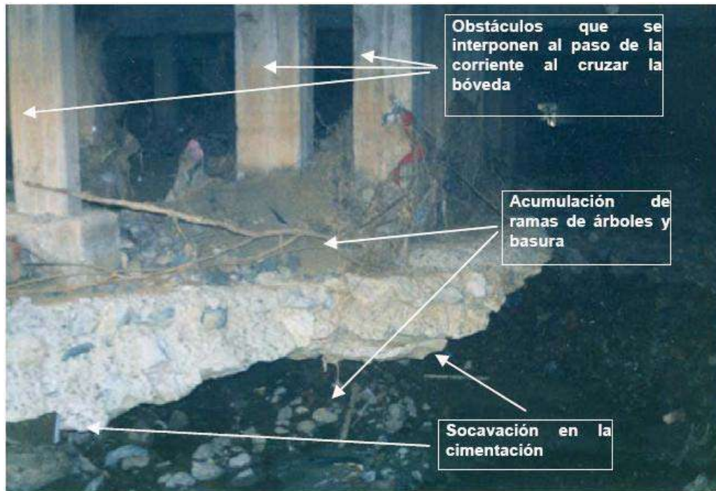
Figura 25. Cimentación de edificaciones ubicados sobre la bóveda del río Chiquito, 2002 (fuente: Presidencia Municipal de Coalcomán)
