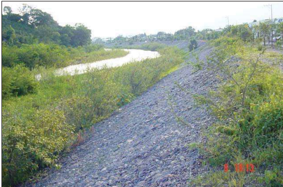
Figura 8. Vista del río Grande a su paso por Coalcomán. Nótese el recubrimiento marginal a base de gaviones
