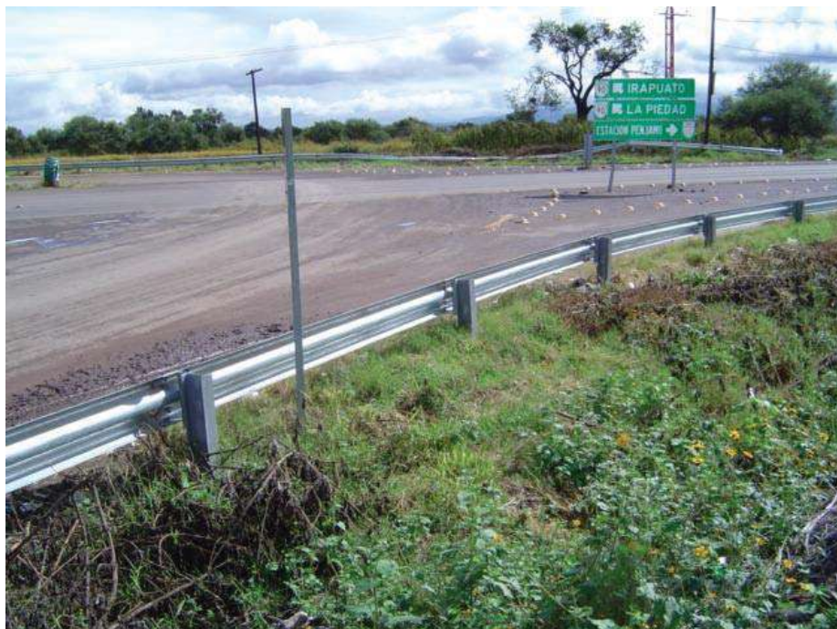
GLORIETA DE RETORNO Y ACCESO A LA CARRETERA FEDERAL # 90
