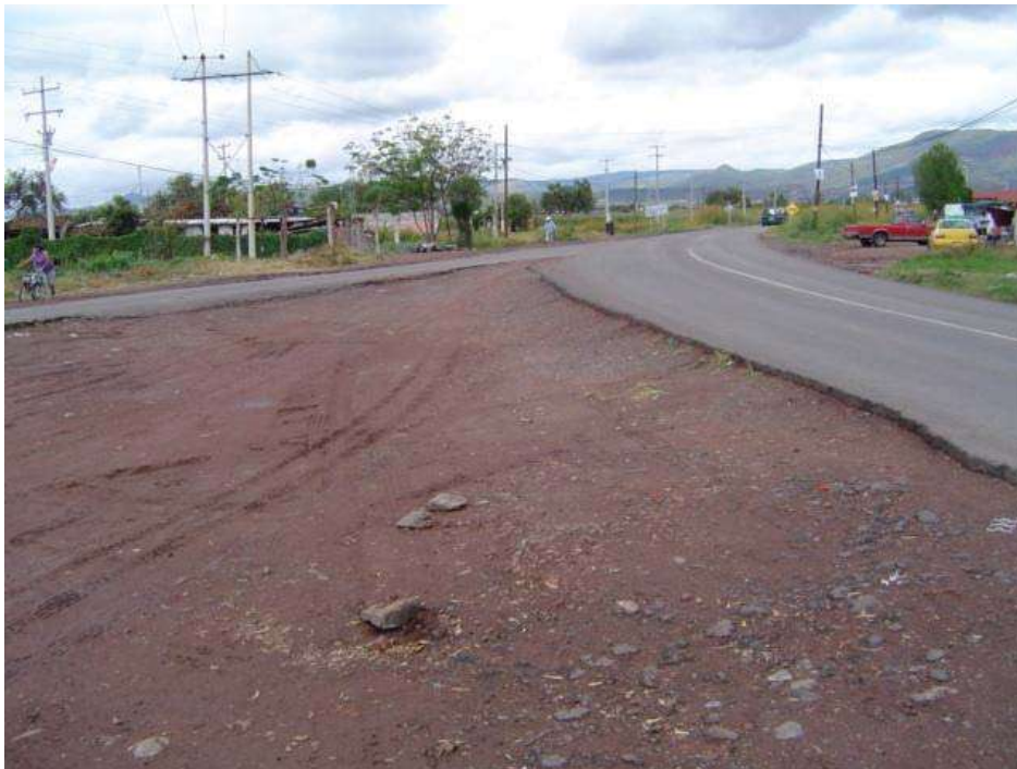
ZONA DONDE QUEDARA UBICA LA GLORIETA EN ESTACIÓN PÉNAJMO
