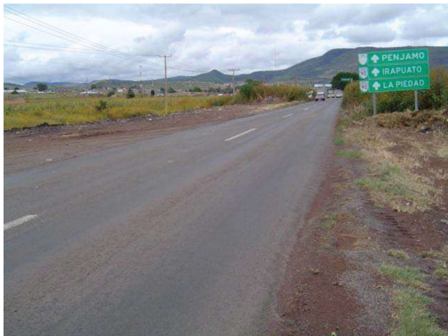
VISTA DEL PUNTO DE INICIO (0+000) DEL BUOLEVARD PÉNJAMO – ESTACIÓN PÉNJAMO (EN AMBOS SENTIDOS)
