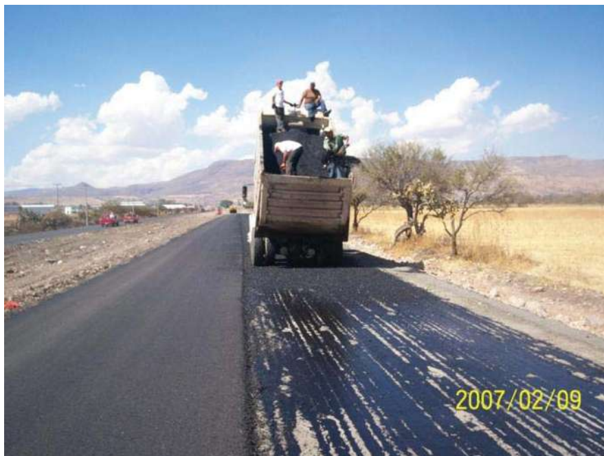
POREO CON CARPETA ASFALTICA
