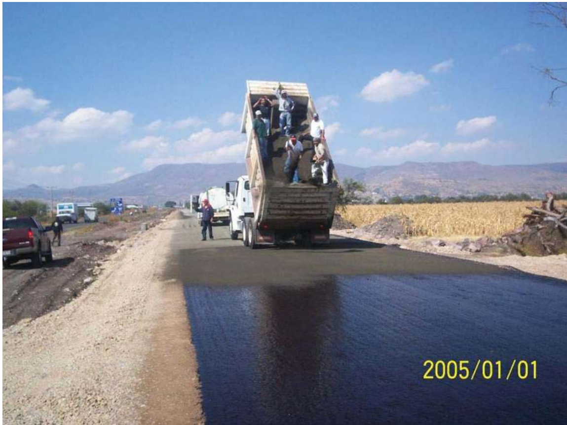
RIEGO DE IMPREGNACION Y POREO CON ARENA
