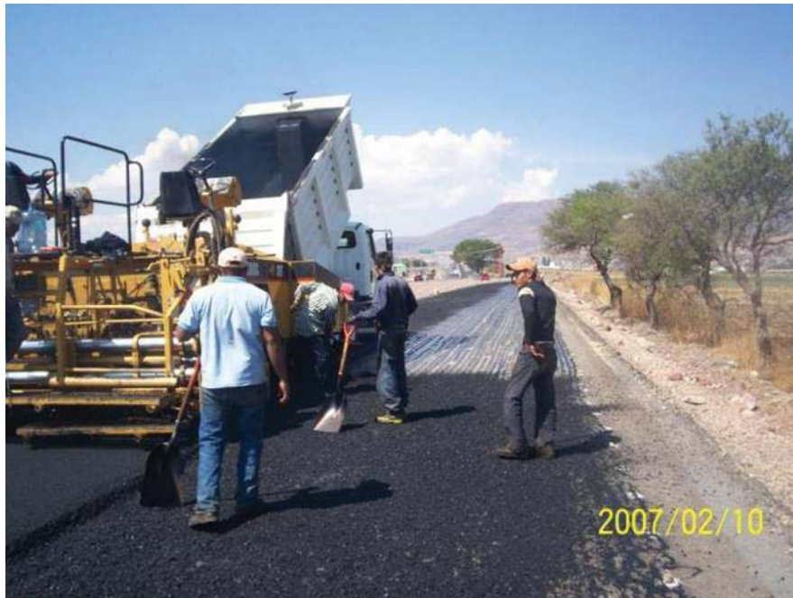
EXTENDIDO DE CARPETA ASFALTICA
