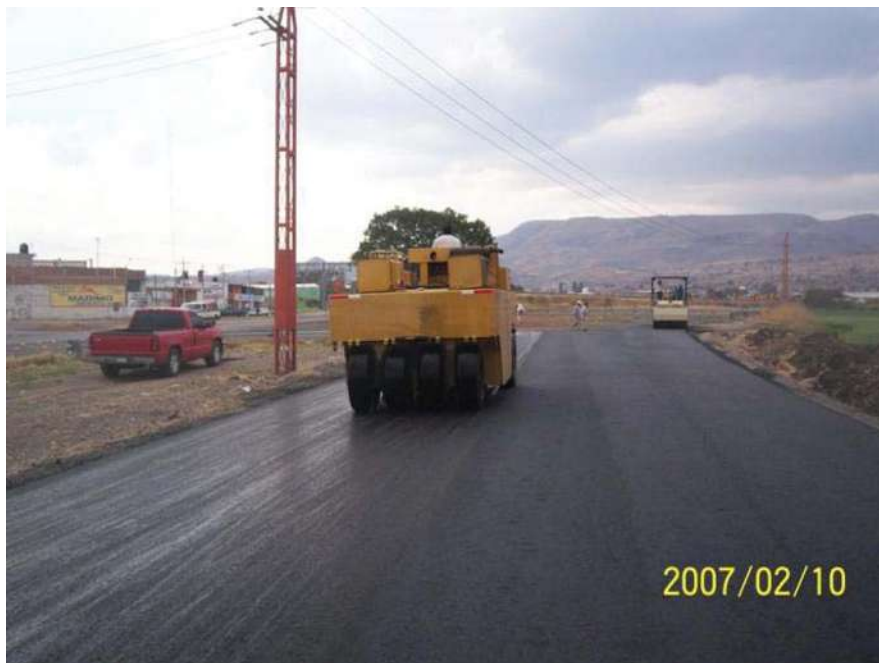
COMPACTACION DE CARPETA ASFALTICA
