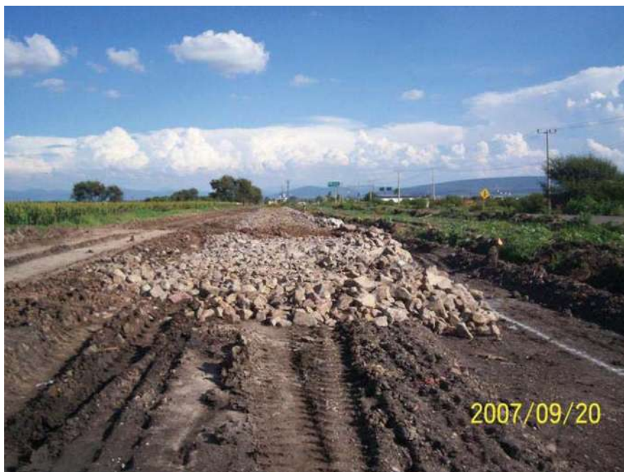
MATERIAL UTILIZADO PARA LA CAPA DE PEDRAPLEN
