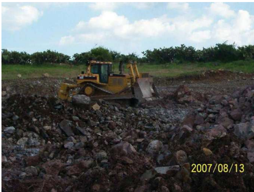
DESPALME EN EL BANCO DE MATERIAL UTILIZADO PARA LA CAPA DE PIEDRAPLEN
