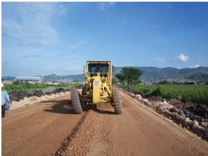
AFINE DE LA CAPA DE SUB-RASANTE
