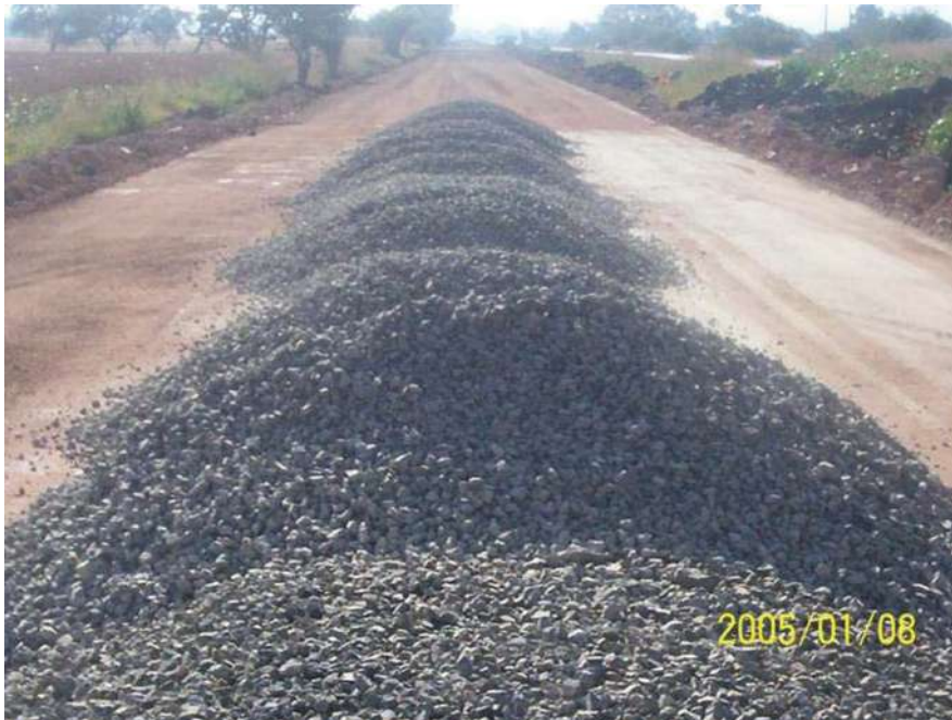
ACAREO DE MATERIAL PARA LA CAPA DE BASE
