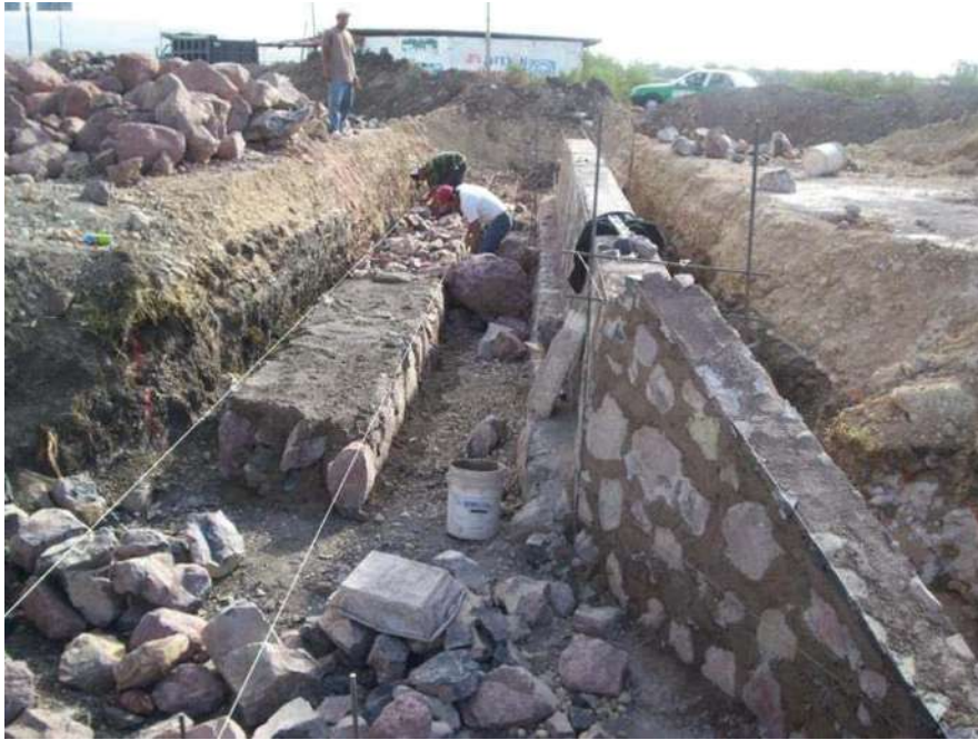
CONSTRUCCION DE OBRA DE DRENAJE 1+780
