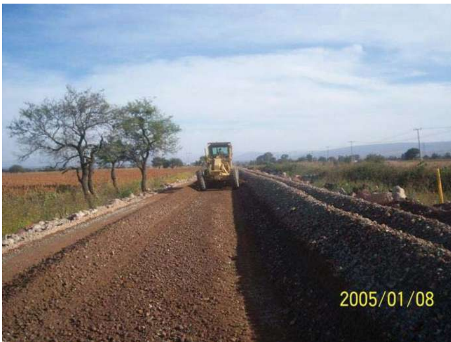
HOMOGENEIZACION DEL MATERIAL PARA LA CAPA DE BASE
