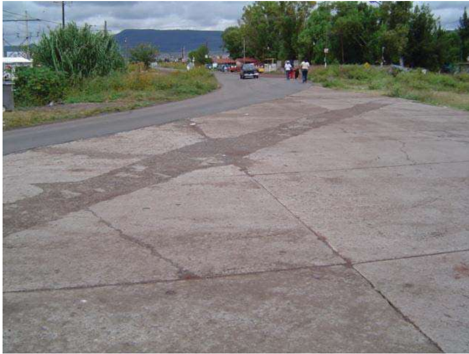
CARRETERA A FRIGORIFICOS DEL BAJIO Y CALLE 16 DE SEPTIEMBRE EN ESTACIÓN PÉNAJMO.
