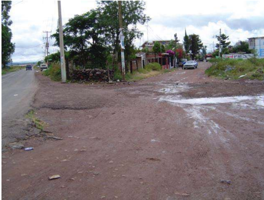
CARRETERA A HUANIMARO Y CALLE MIGUEL HIDALGO EN ESTACIÓN PÉNAJMO.
