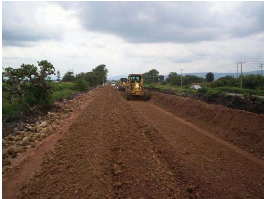
HOMOGENEIZACION DEL MATERIAL PARA LA CAPA DE SUB-RASANTE
