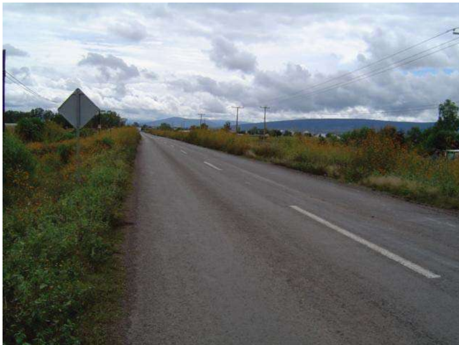
VISTAS GENERALES DE CAMINO REAL Y CARRETERA ACTUAL CUERPOS IZQUIERDO Y DERECHO RESPECTIVAMENTE
