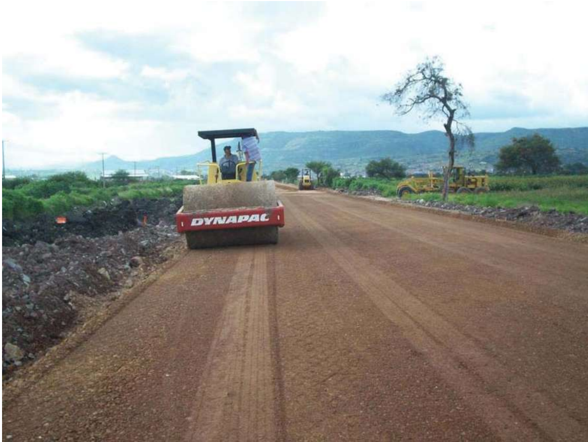
COMPACTACION DE LA CAPA DE SUB-RASANTE
