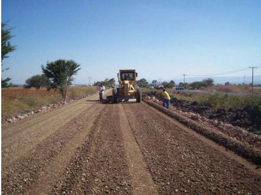
EXTENDIDO Y AFINE DE LA CAPA DE BASE
