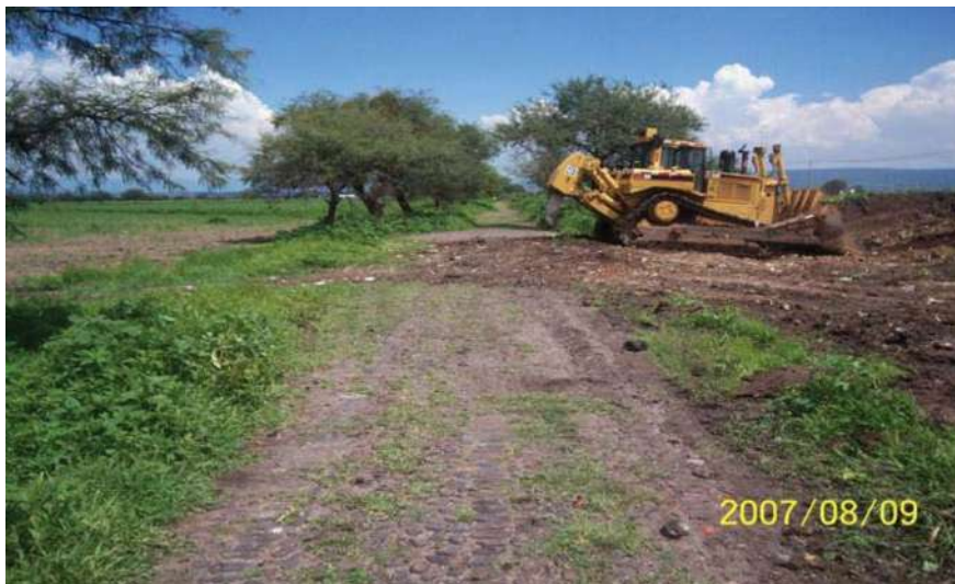
DESPALME DE TERRENO NATURAL
