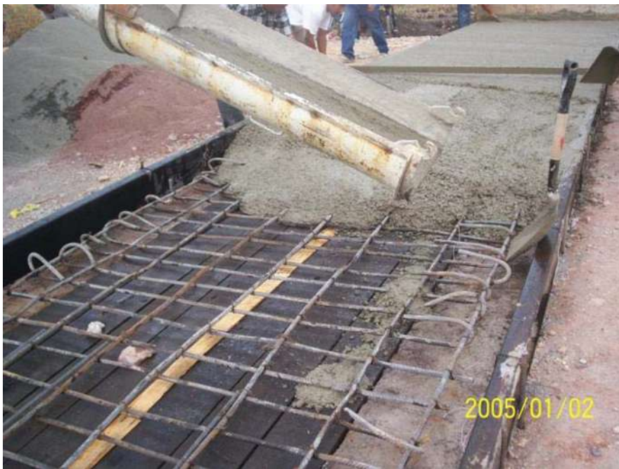
COLADO EN OBRA DE DRENAJE 1+780
