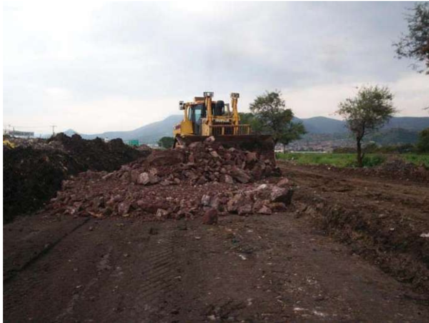
EXTENDIDO Y ACOMODO DEL MATERIAL PARA PEDRAPLEN
