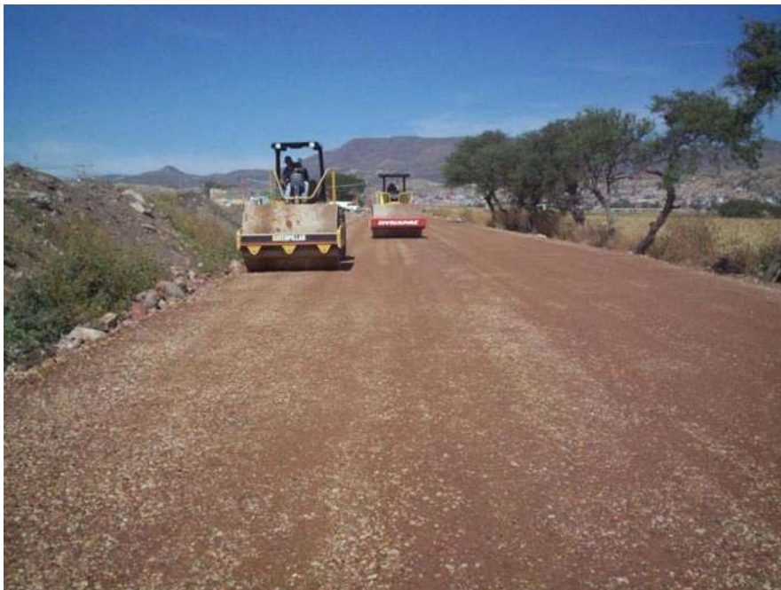
COMPACTACION DE LA CAPA DE BASE
