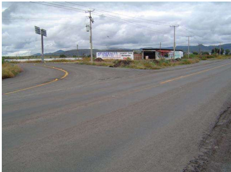
ASPECTO ACTUAL DE ENTRONQUE CON CARRETERA "LA HERRADURA"
