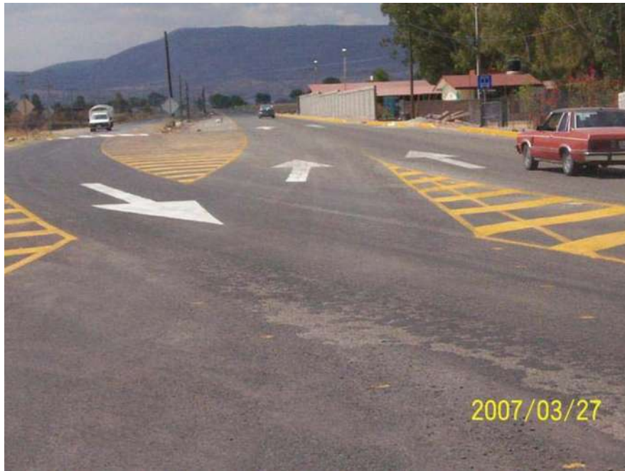
MARCAS DE PINTURA EN LA LLEGADA A ESTACION PÉNJAMO
