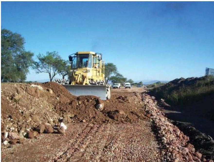
AGREGADO DE HUMEDAD PARA LA CAPA DE TERRACERIA
