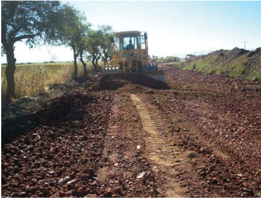
CONFORMACION Y COMPACTACION DE CUERPO DE TERRAPLEN
