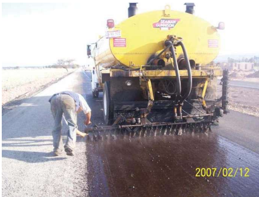
RIEGO DE LIGA PARA LA COLOCACION DEL SELLO
