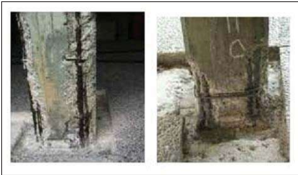
Figura 46 Fotografías en las cuales se muestra la remoción de concreto, hasta descubrir las armaduras oxidadas
