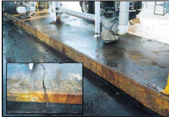
Figura 13 Estructura erosionada por el contacto con elementos químicos Obtenida en www.ies.wisc.edu/research
