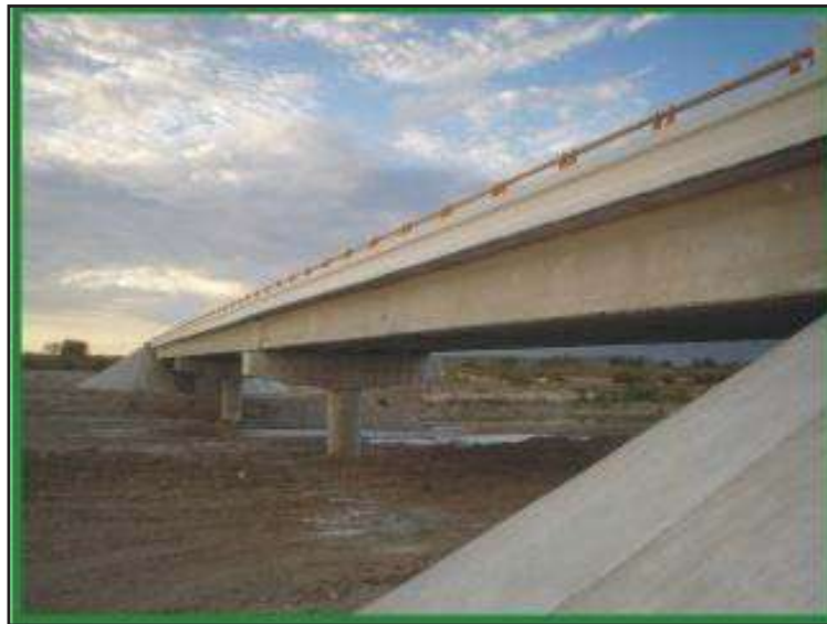
Figura 10 Estructura de concreto sometida a esfuerzos de compresion, punte formado por tres claros de 30.0 mts., para un ancho de 8.80 mts ( puente ubicado en Chihuahua) Obtenido en www.chihuahua.gob.mx/scop/Contenido/plantilla...
