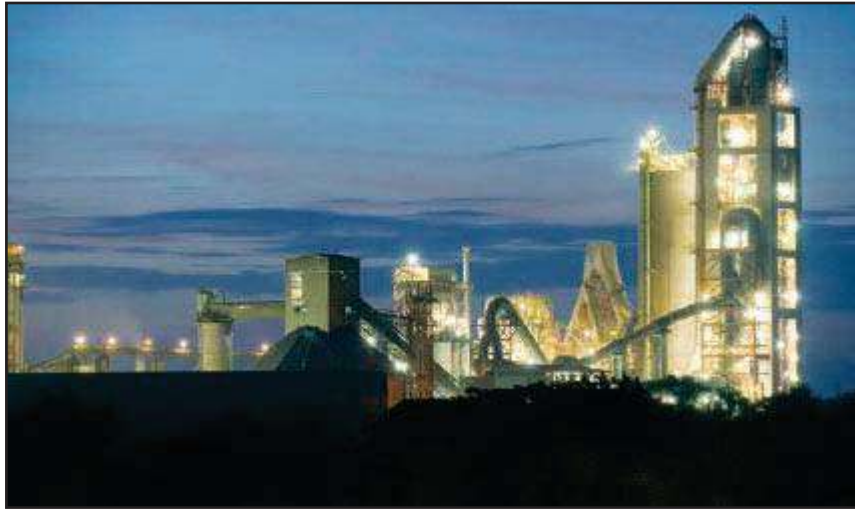
Figura 2. Planta Productora de cemento
