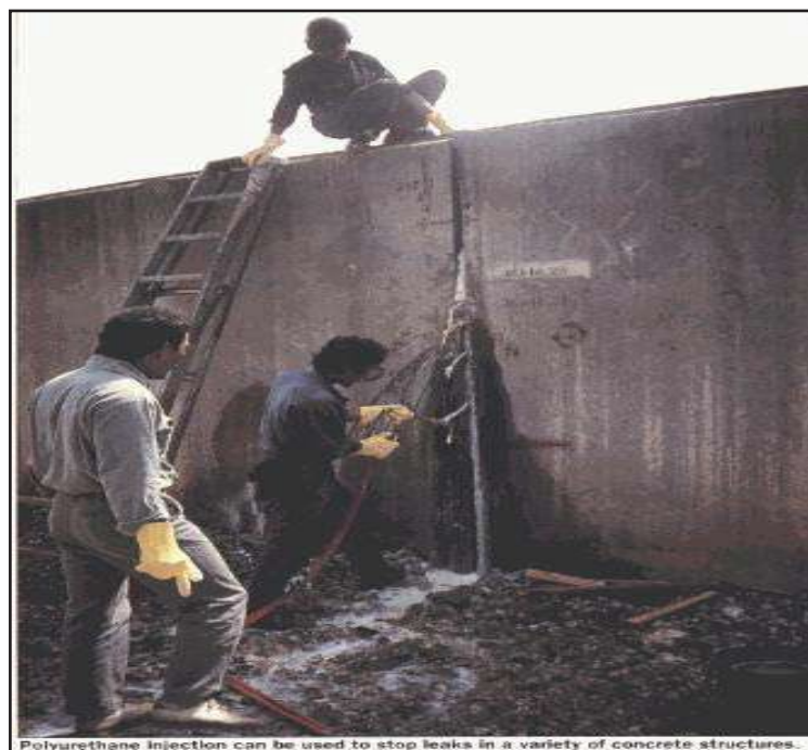
Figura 44 Reparación de grieta por medio de inyección de poliuretano
