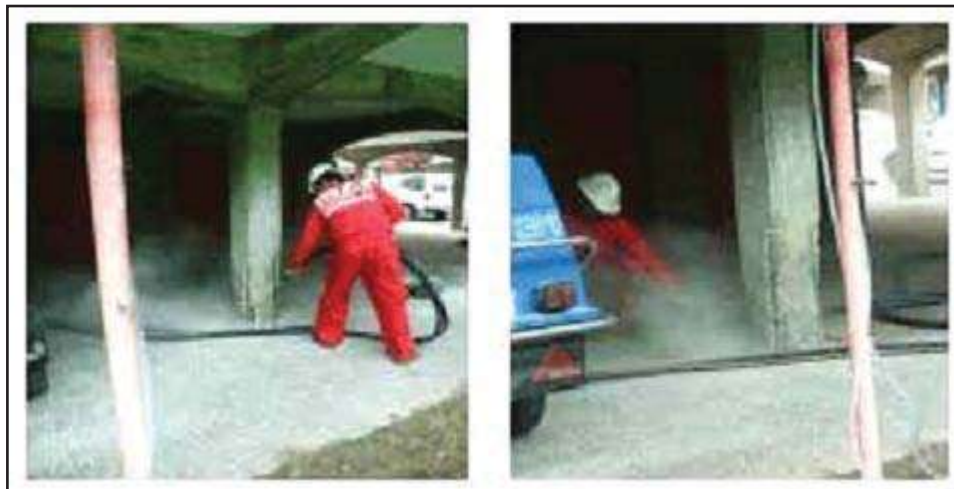
Figura 47 Limpieza de la estructura, para eliminar polvo y oxido, quedando al descubierto las armaduras para aplicar capa de imprimación
