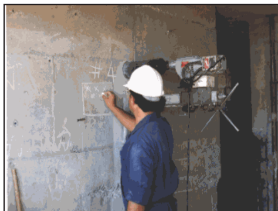
Figura 45 Escaneo de Armaduras
