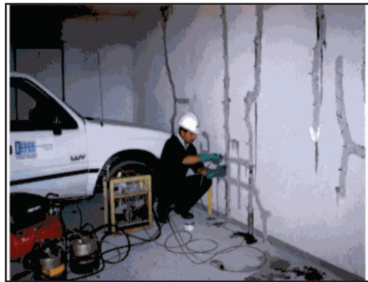
Figura 43 Fotografía en la cual se muestra la aplicación de Inyecciones Epoxicas
