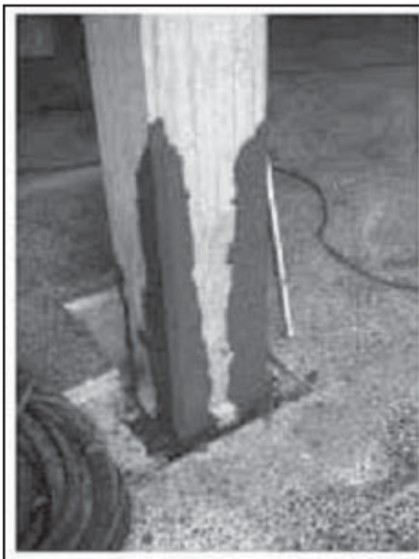
Figura 49. Finalmente se realiza la reconstrucción de las partes reparadas Obtenido en www.es.wikibooks.org/wiki/Patologia de la edificación
