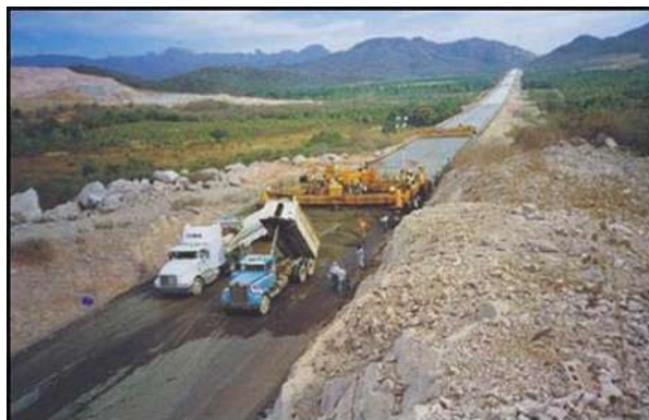
FIGURA 1. Pavimentadora de cimbra deslizante.
