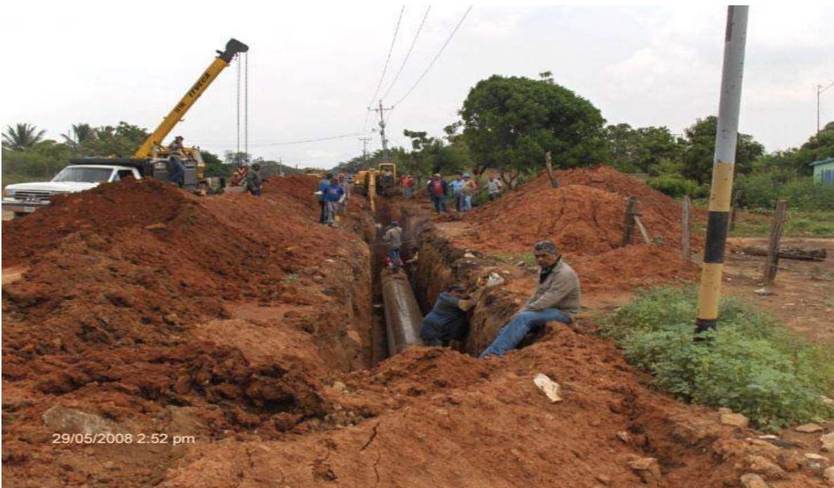
La profundidad de la zanja será en función de las cargas estáticas y dinámicas, del diámetro y de las condiciones particulares de la obra.
