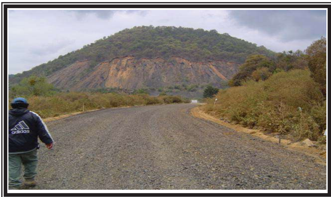
FOTO No.12 CONSTRUCCION DE LA CAPA SUBRASANTE.
