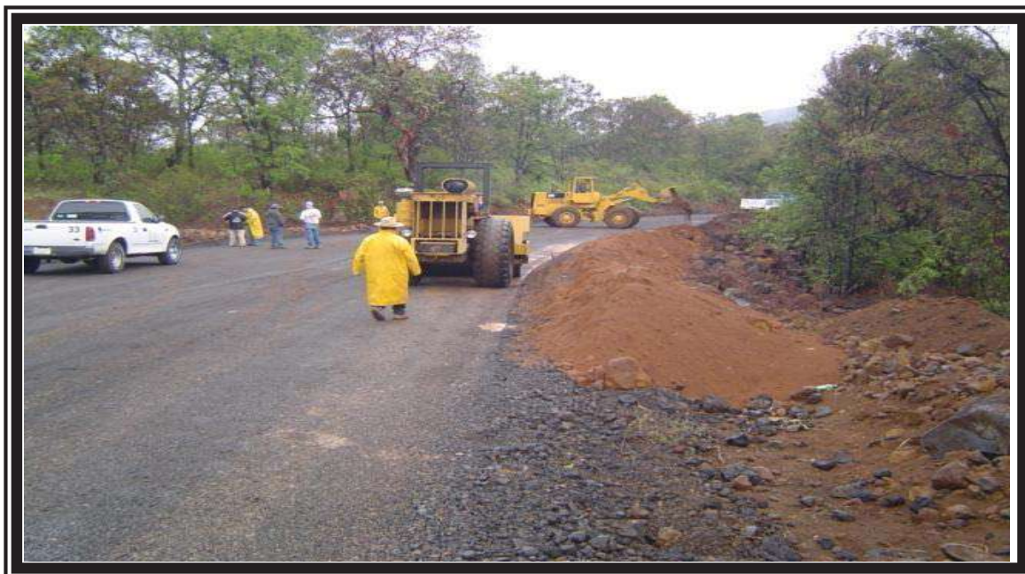
FOTO No.17 ARROPE DE TALUD.
