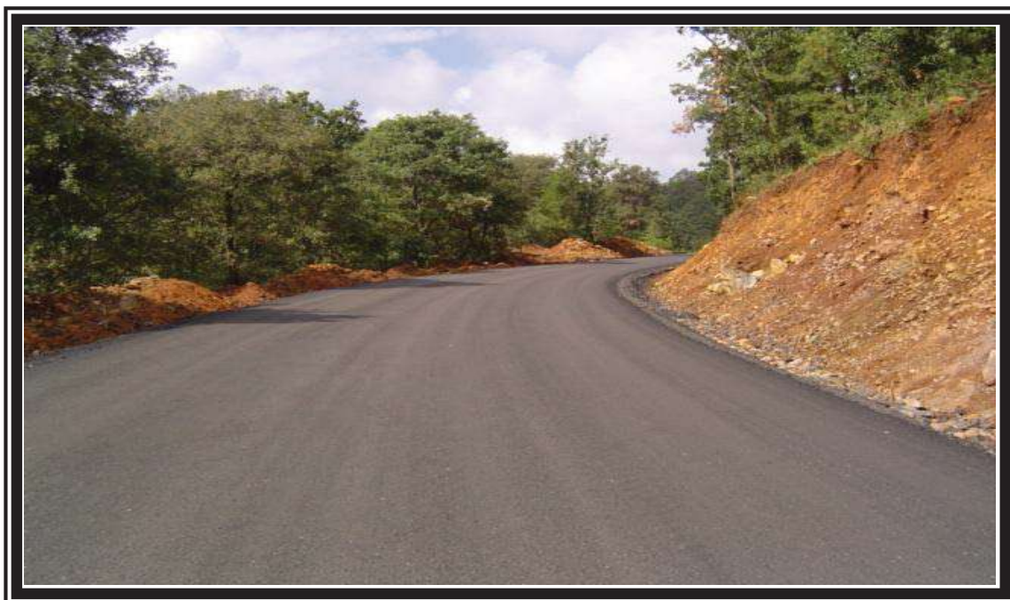
FOTO No.22 CARPETA ASFALTICA TERMINADA.
