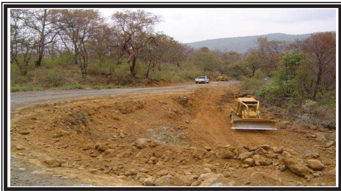
FOTO No.5 CONSTRUCCION DE TERRACERIAS.
