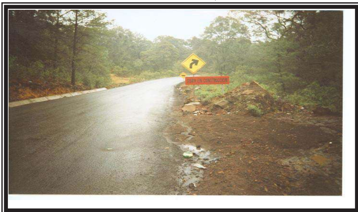
FOTO No.28 CAMINO TERMINADO CON RIEGO DE SELLO, CUNETAS Y SEÑALAMIENTO.
