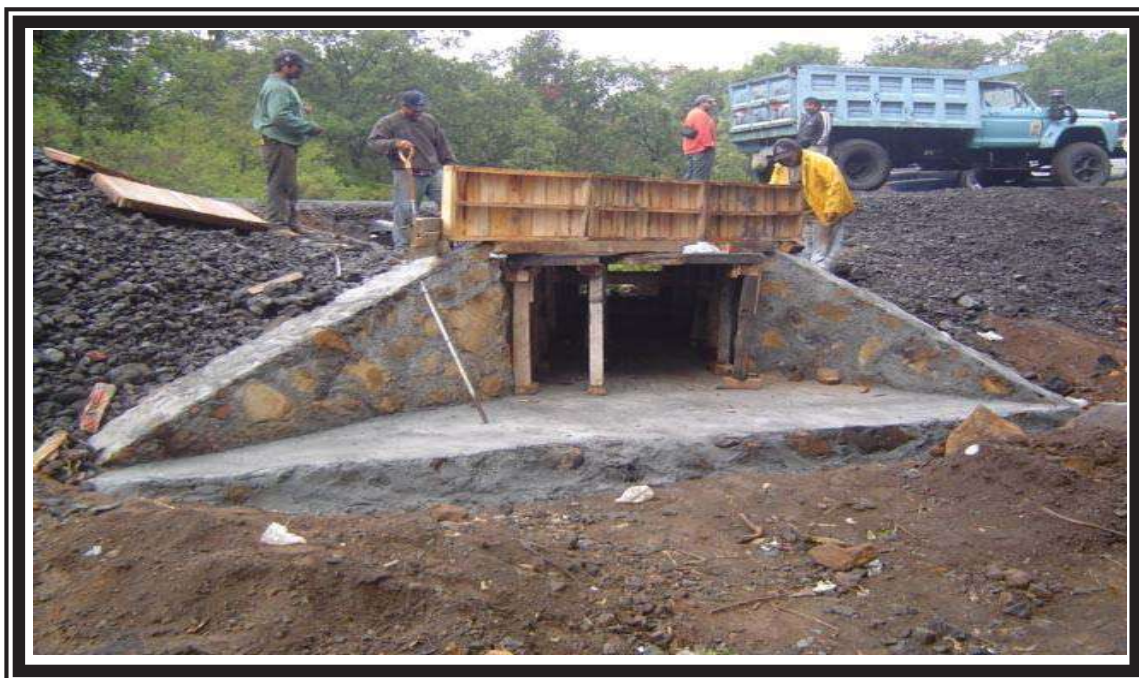
FOTO No.10 AMPLIACION DE OBRAS DE DRENAJE. DE LOSA DE CONCRETO.
