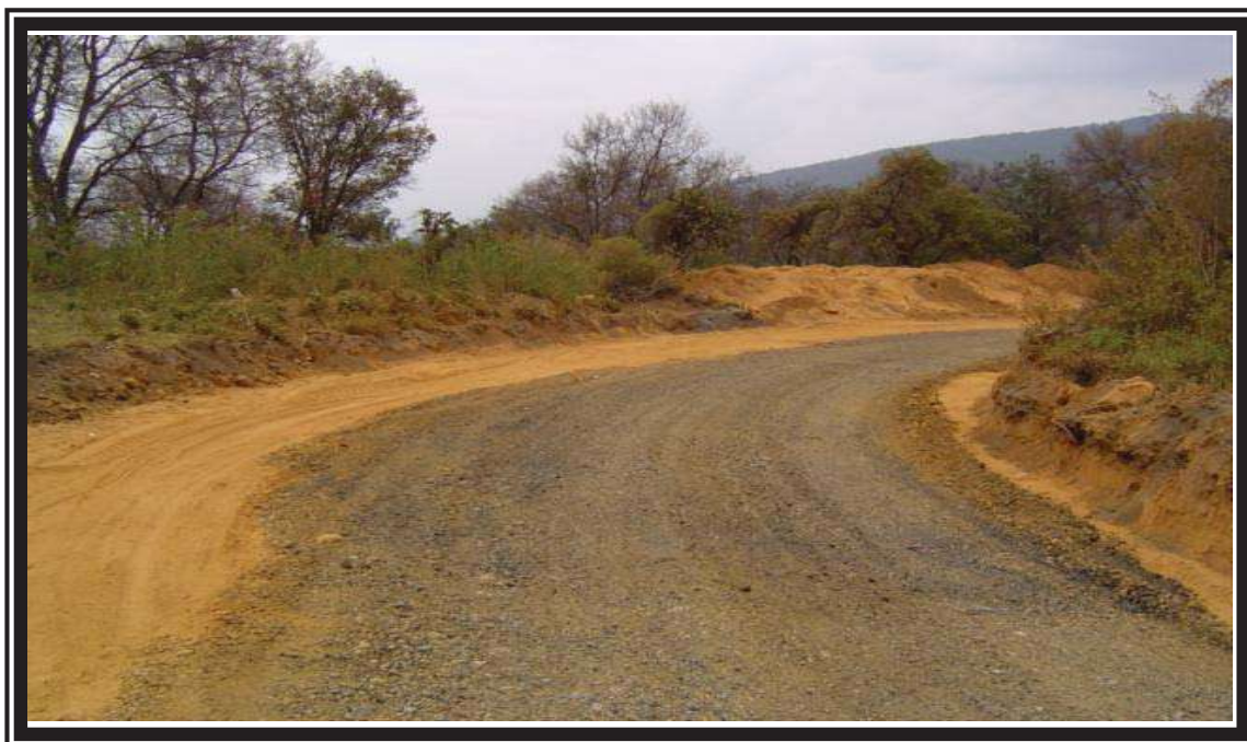
FOTO No.6 CONSTRUCCION DE TERRACERIAS.
