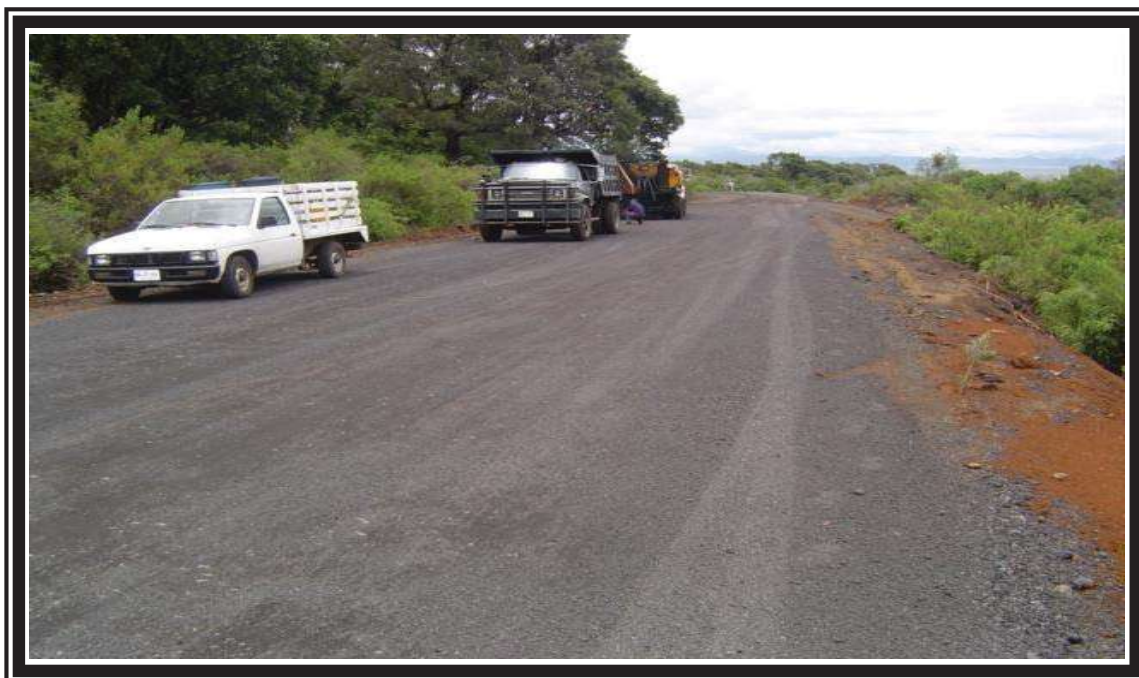
FOTO No.14 CONSTRUCCION DE LA BASE HIDRAULICA.
