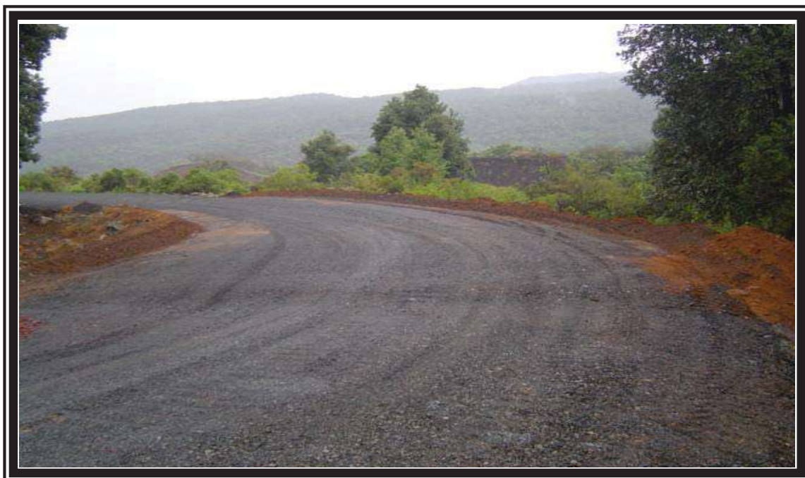
FOTO No.18 ARROPE DE TALUD PARA ENCAJONAR BASE Y CARPETA.
