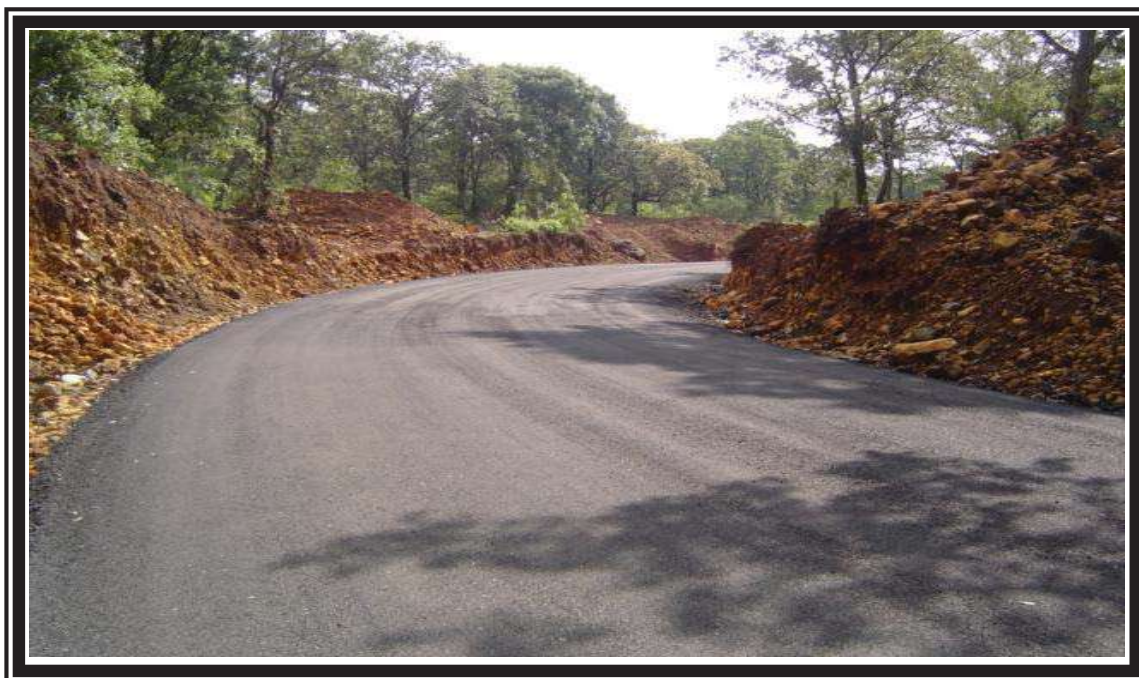
FOTO No.20 CARPETA ASFALTICA.
