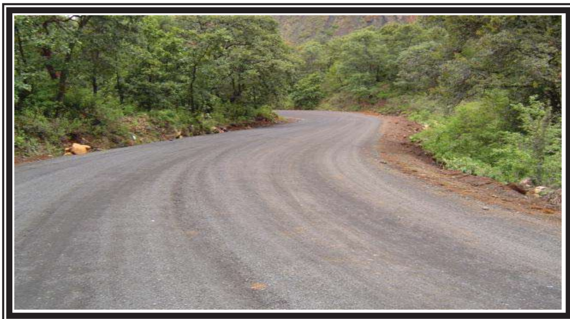
FOTO No.13 CONSTRUCCION DE LA BASE HIDRAULICA.
