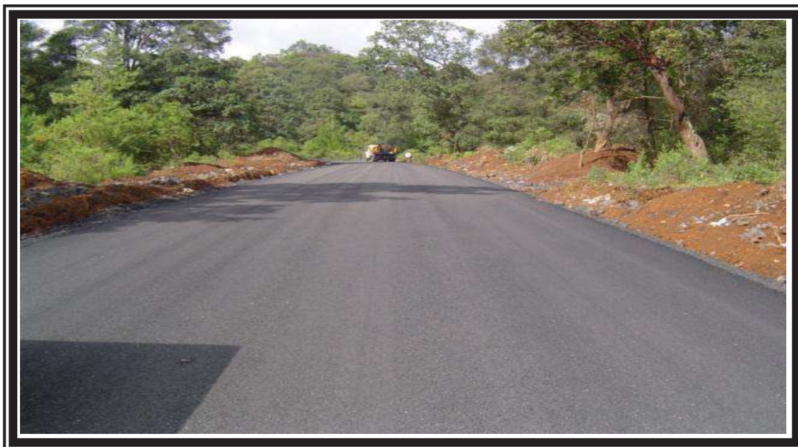
FOTO No.19 CONSTRUCCION DE CARPETA ASFALTICA.
