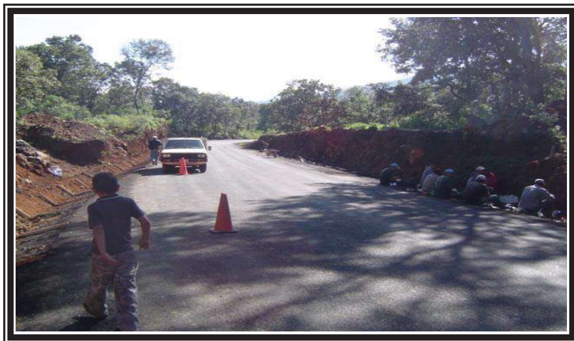
FOTO No.24 CONSTRUCCION DE CUNETAS.
