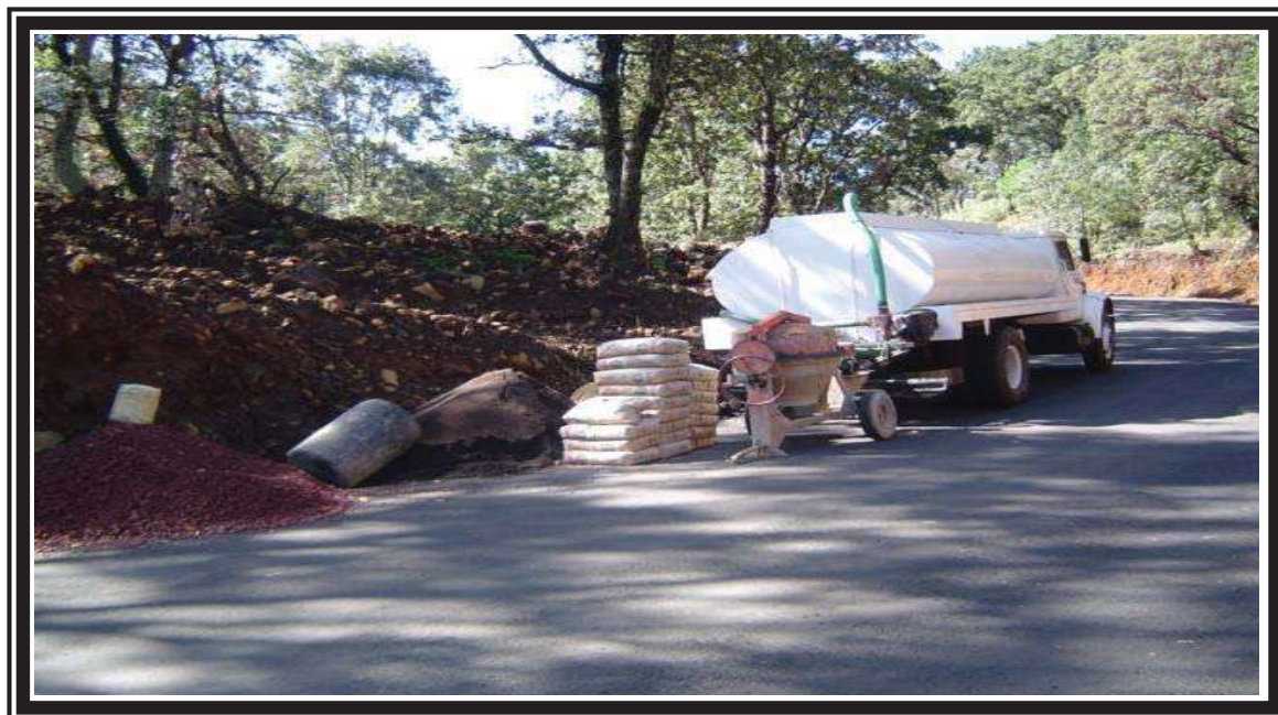
FOTO No.23 CONSTRUCCION DE CUNETAS.
