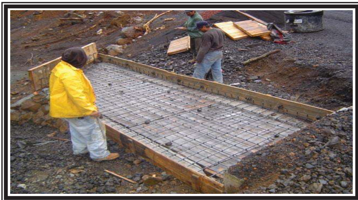
FOTO No.9 AMPLIACION DE OBRAS DE DRENAJE. DE LOSA DE CONCRETO.
