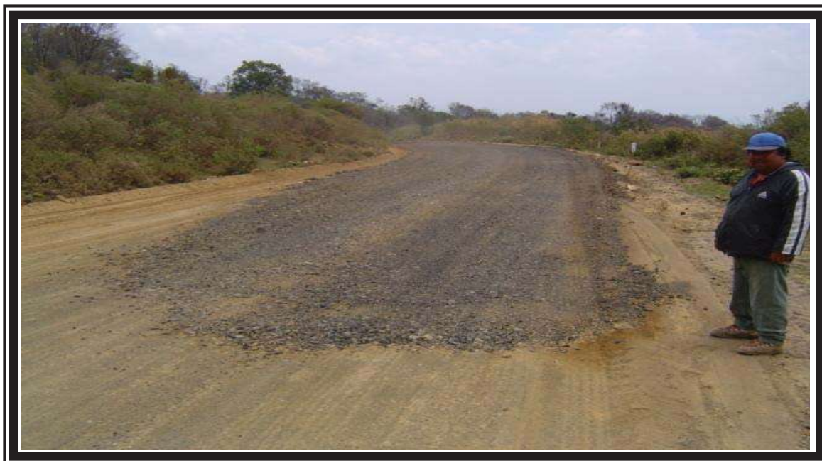
FOTO No.11 CONSTRUCCION DE LA CAPA SUBRASANTE.
