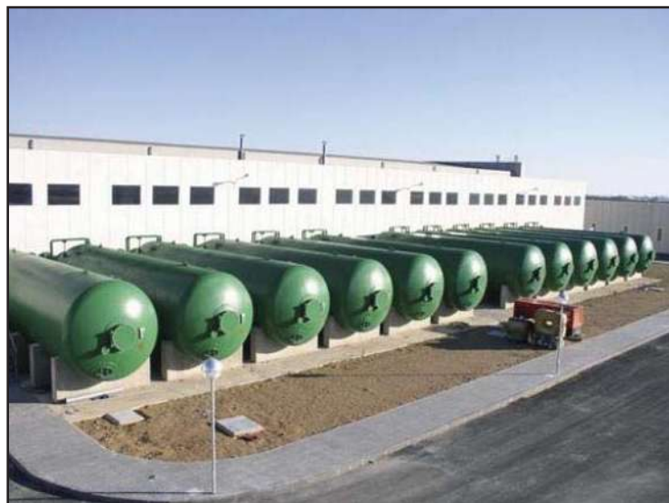
Fotografía No 3.3. Impacto acústico, originado por bombas y turbinas. Desaladora de Cartagena, España.
