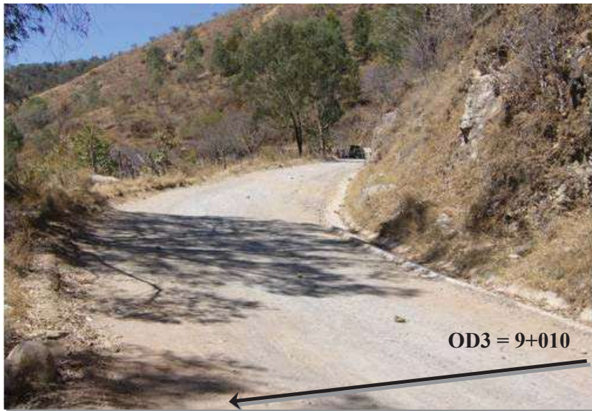
Fig. V.8.- Localización de la tercera alcantarilla en el cadenamiento 9+010. (Alcantarilla nueva.)
