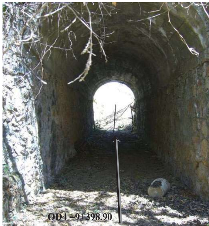
Fig. V.9.- Localización de la cuarta alcantarilla en el cadenamiento 9+398.90. (Alcantarilla de bóveda de 2.60 x 2.60 mts.)
