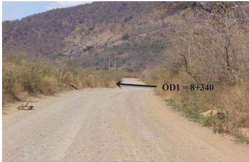
Fig. V.6.- Localización de la primera alcantarilla en el cadenamiento 8+340. (Alcantarilla nueva.)
