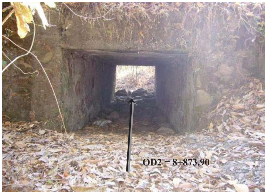
Fig. V.7.- Localización de la segunda alcantarilla en el cadenamiento 8+873.90. (Alcantarilla de losa de 1.00 x 1.00 mts.)
