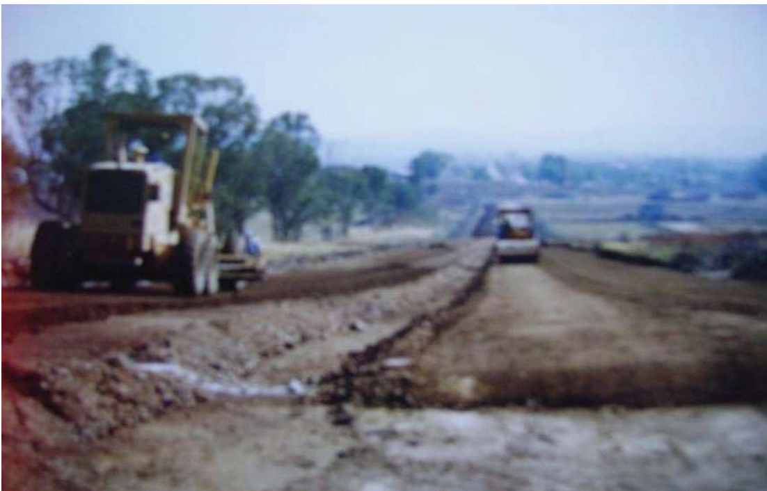
Foto, maquinas trabajando en capa de base.
