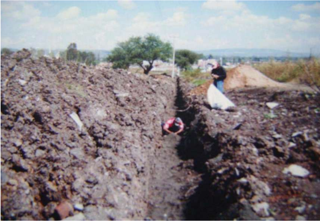
Foto; colocación de piezas especiales
