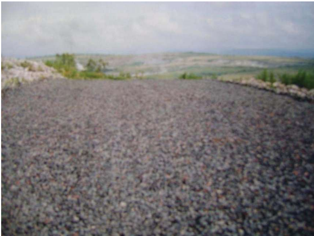
Foto; Capa de filtro terminada en calle, fraccionamiento el trébol III
