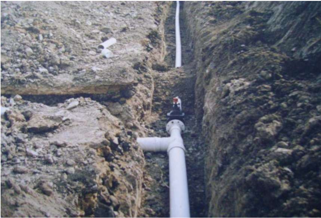
Foto; colocación de tubería para red de agua potable y válvula de seccionamiento
