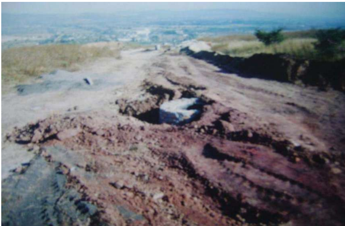
Foto; Zanja y pozo de vista cubiertos con material.
