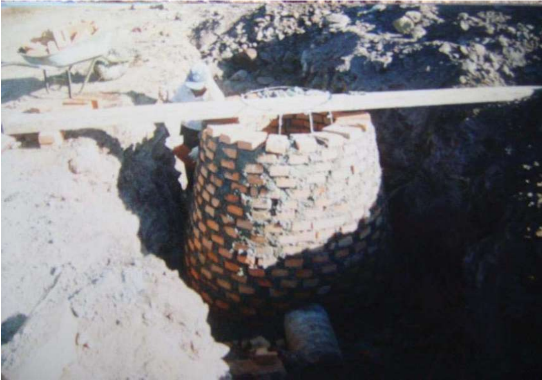
Foto; Construcción de pozo de visita
