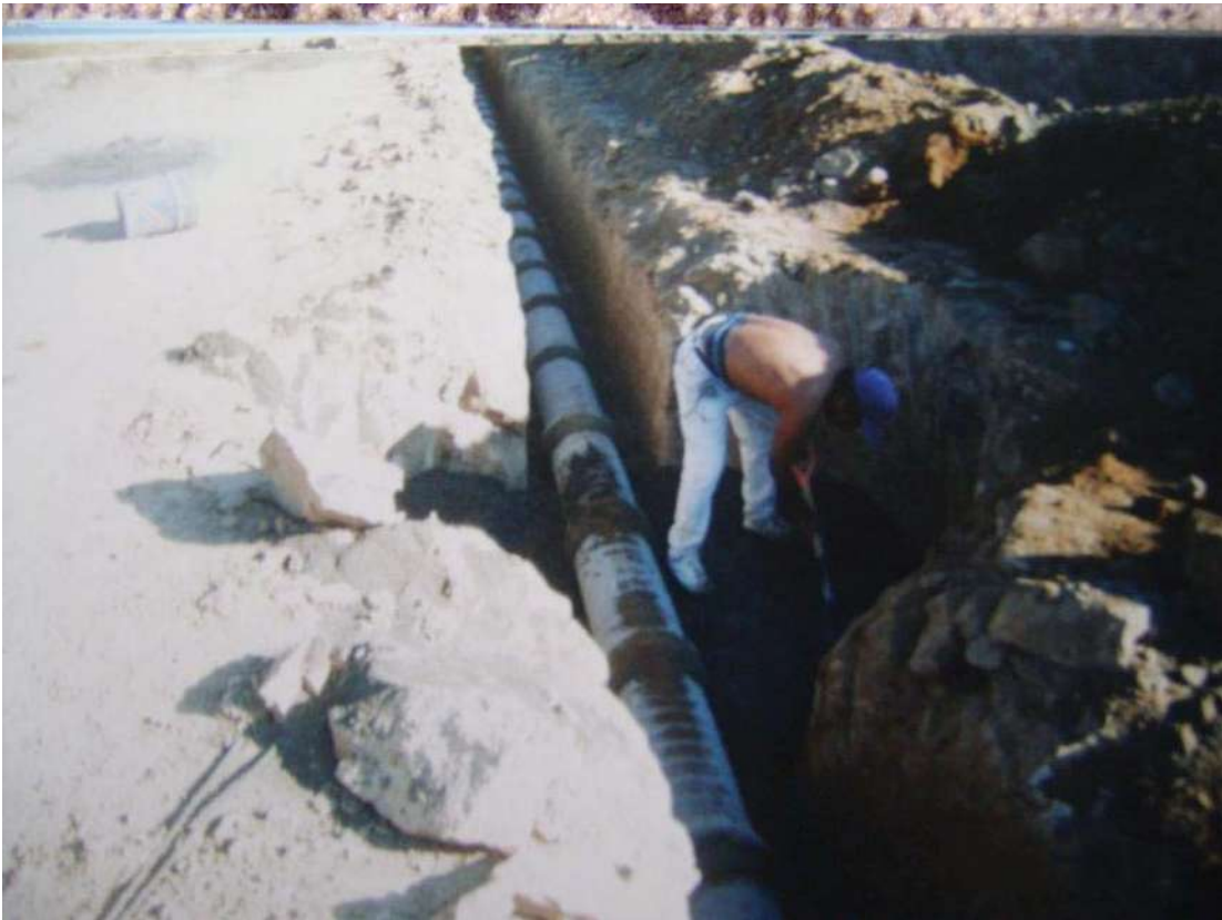
Foto; Colocación de tubo de concreto para drenaje y plantilla de arena para pozo de visita
