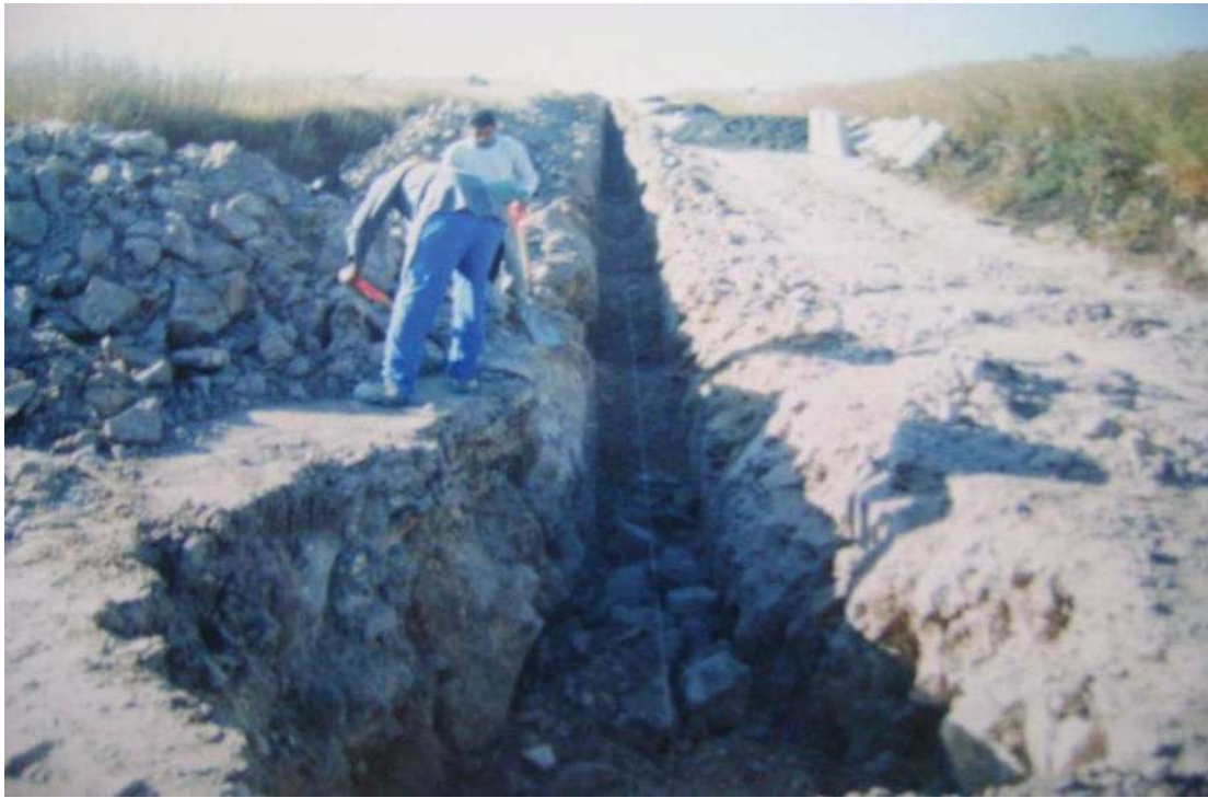
Foto, alineación y nivelación para colocado de tubería para drenaje
