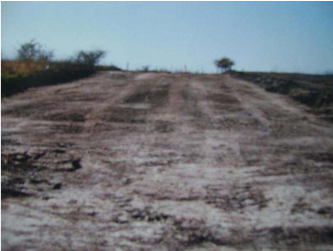
Foto, despalme de 40 CMS. Para apoyo de capas de pavimento
