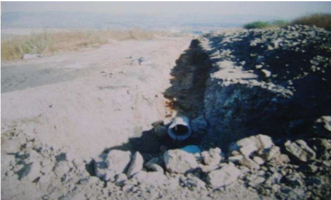
Foto; Relleno de zanja con material de banco (tepetate)
