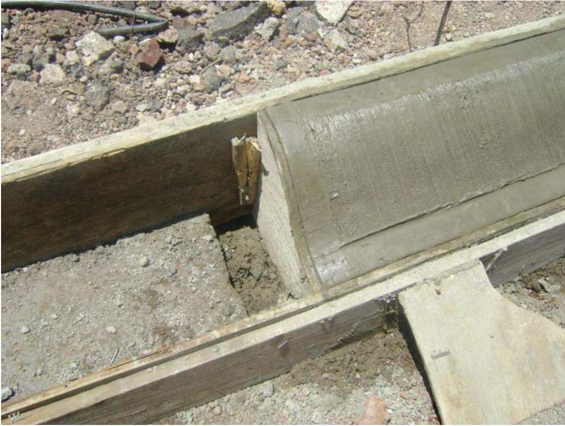
Foto; construcción de guarniciones (pecho de paloma)
