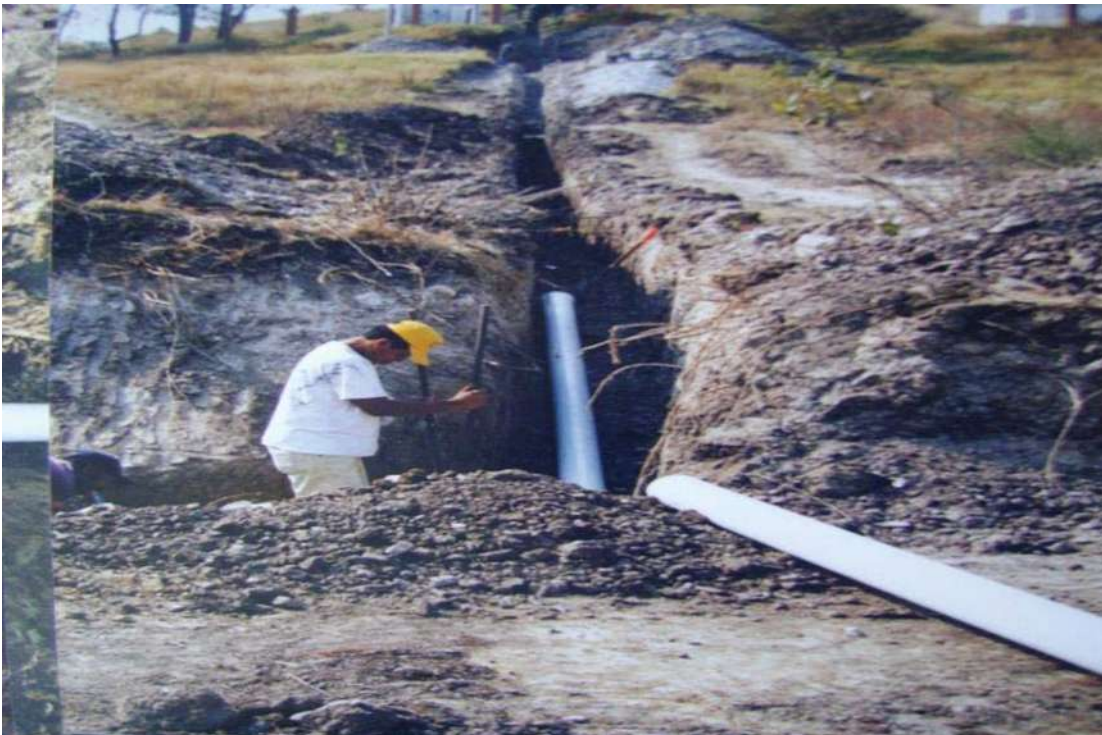
Foto; Tendido de tubería para la línea de conducción
