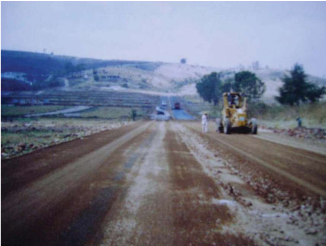
Foto; trabajo de terminación de la capa de base
