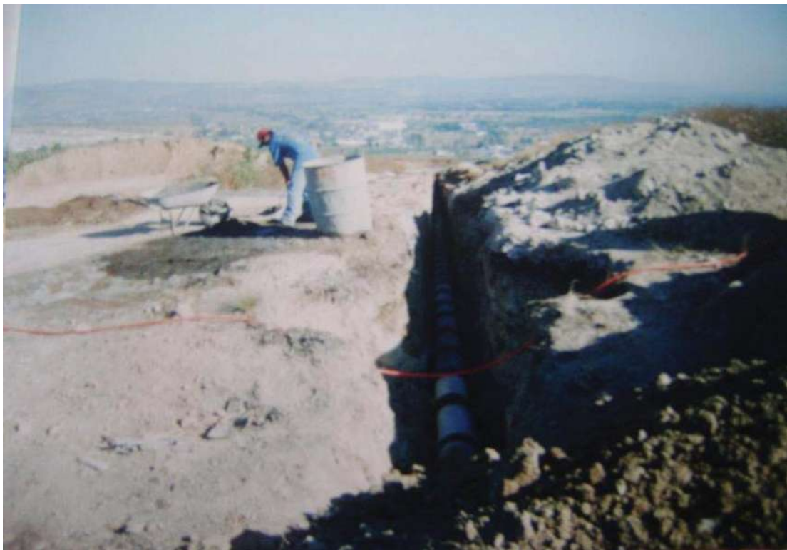
Foto; Instalación de tubería de drenaje de 25 CMS de diámetro.
