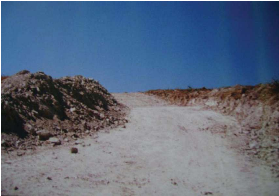
Foto; Corte en material tipo B para acceso a la zona alta del fraccionamiento
