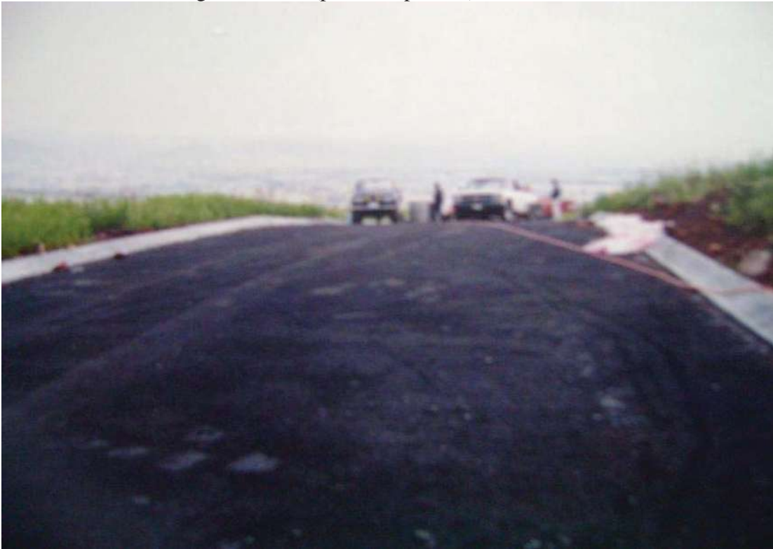
Foto; guarniciones de f'c = 250 \text{ kg/cm}^2
