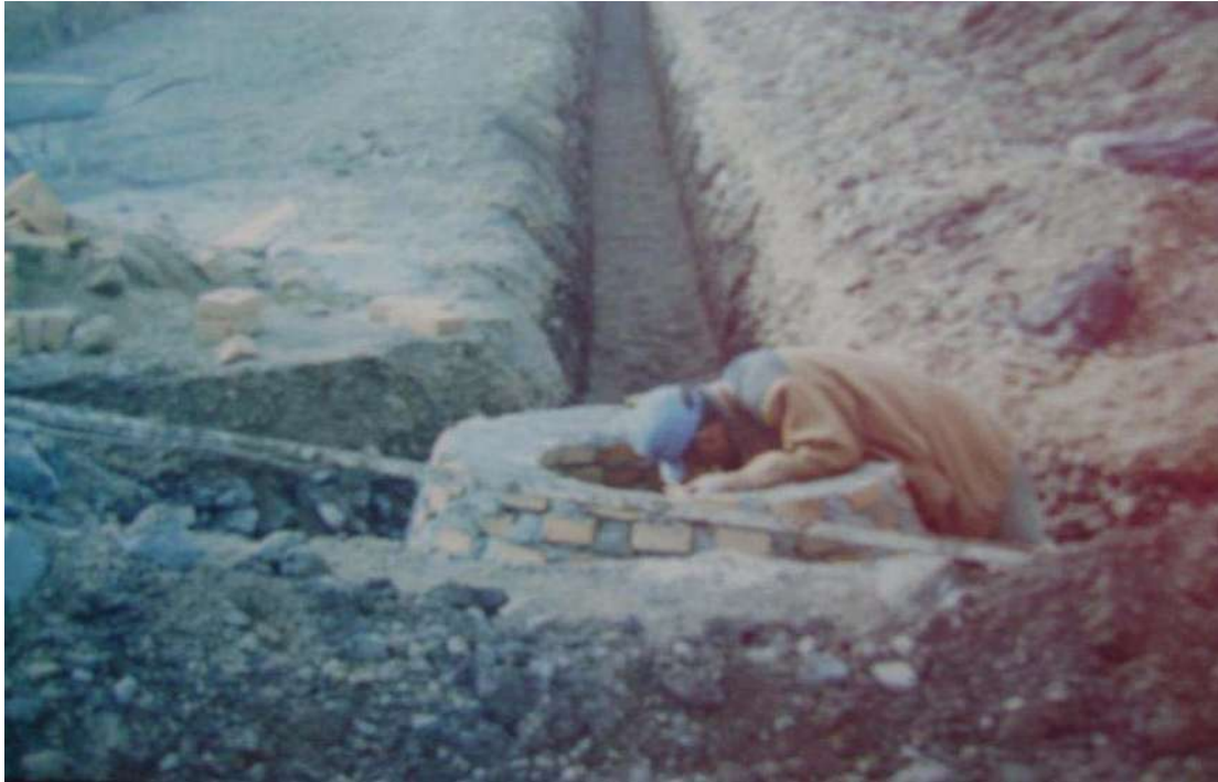
Foto; Acabado de pozo de visita.
