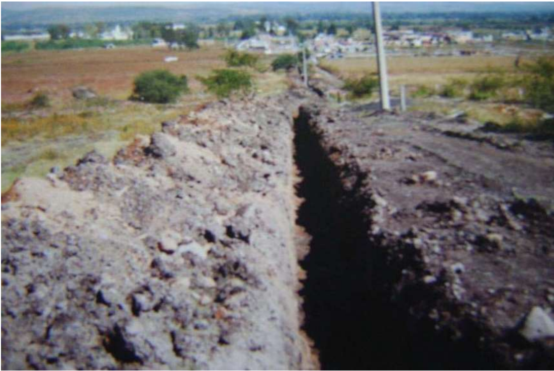
Foto; zanja para la colocación de tubería para línea de conducción
