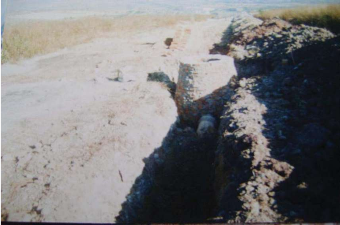
Foto; Pozo de visita común
