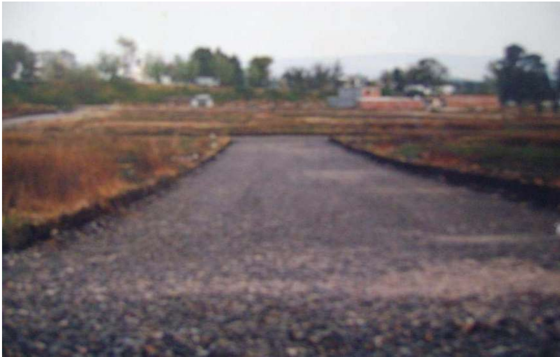
Foto; Capa de filtro de 30 CMS. De espesor según diseño
