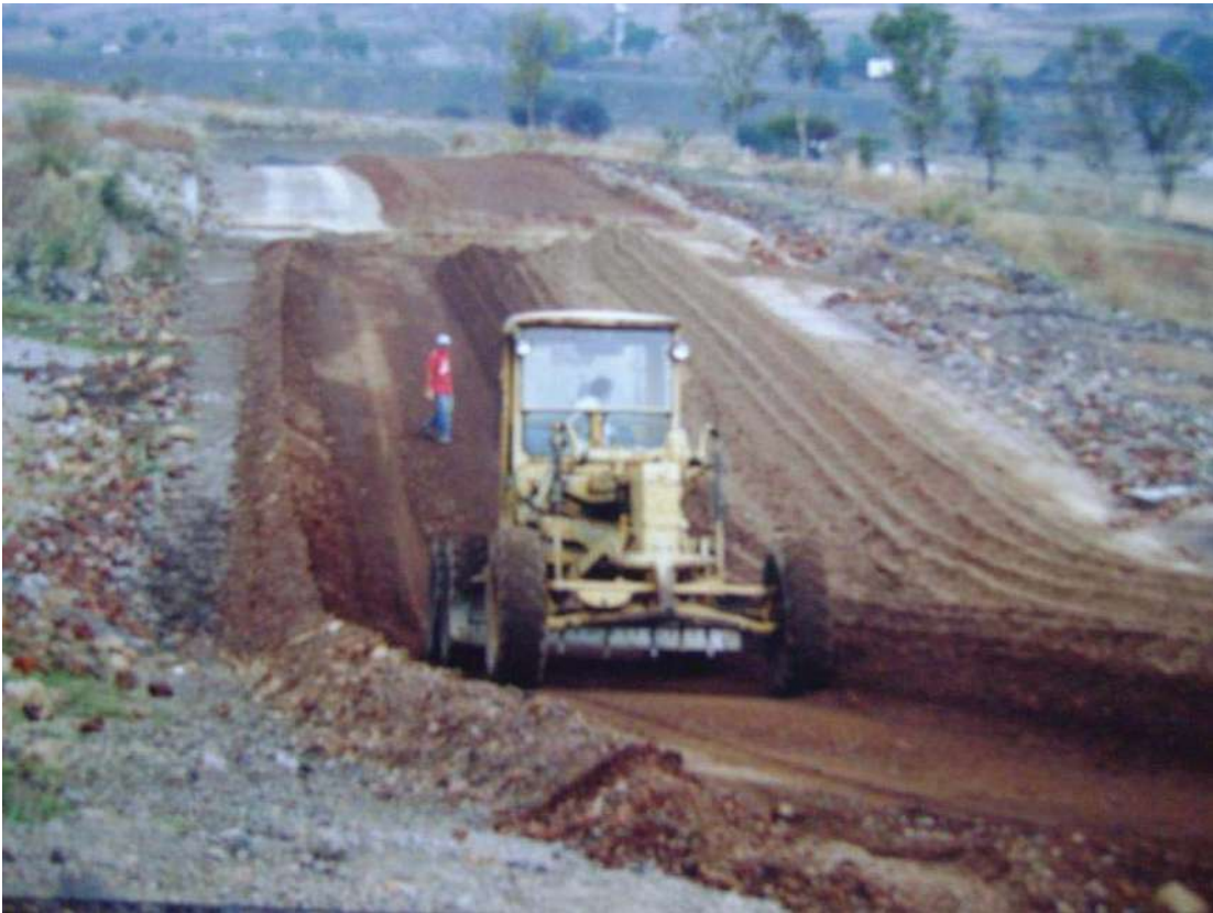
Foto; conformación de material de sub- base.
