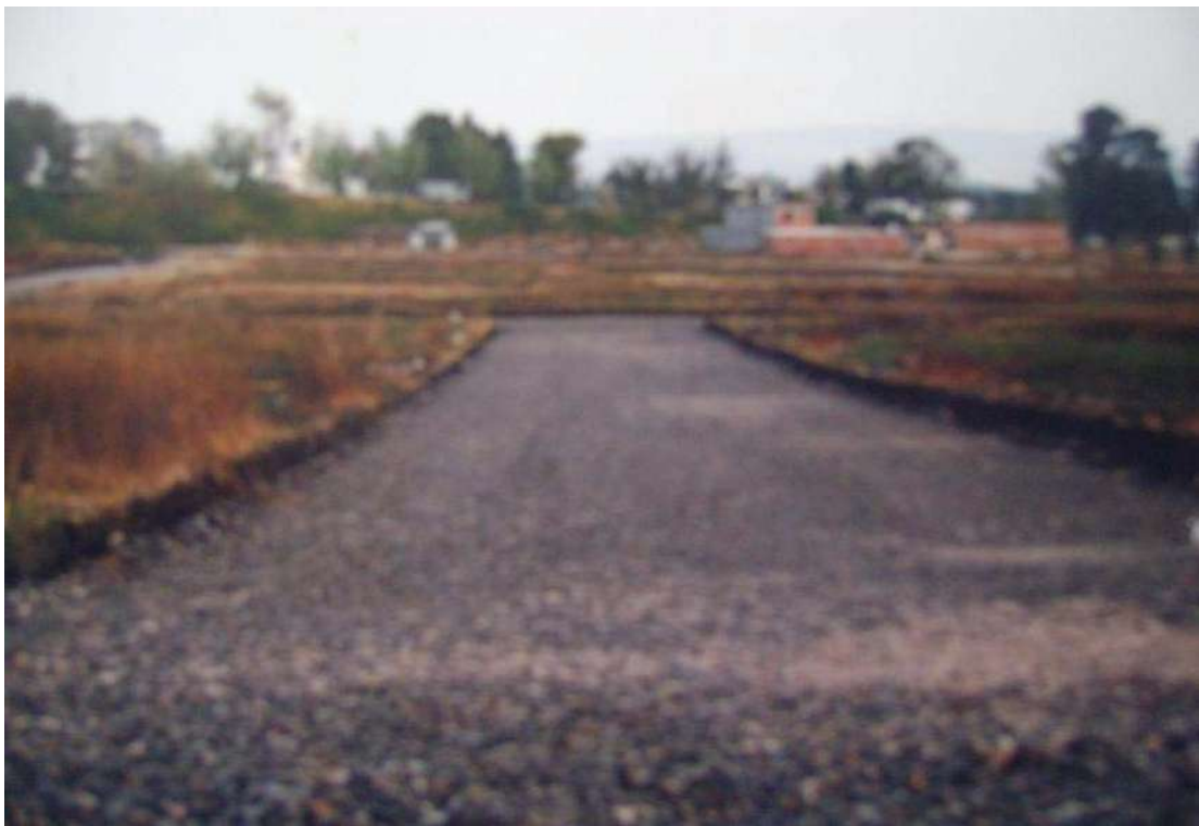
Foto; Capa de filtro de 30 CMS. De espesor según diseño
