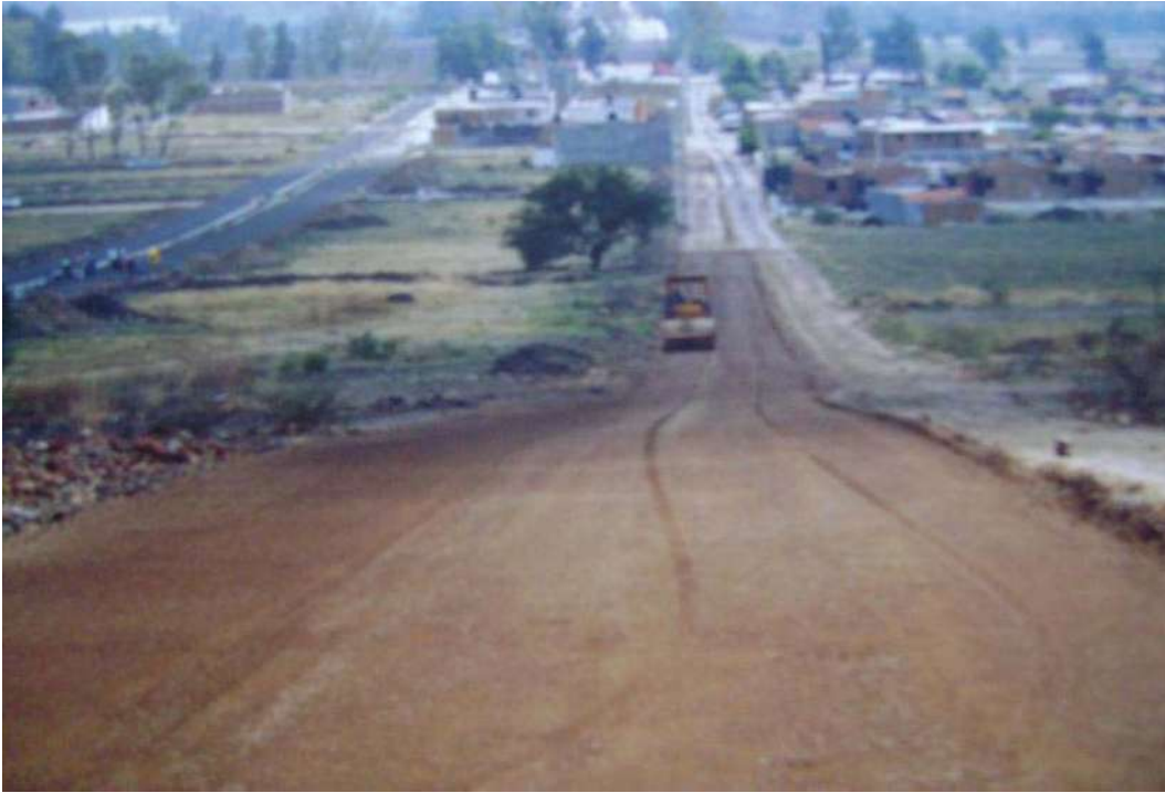
Foto; compactación con rodillo de la capa de base
