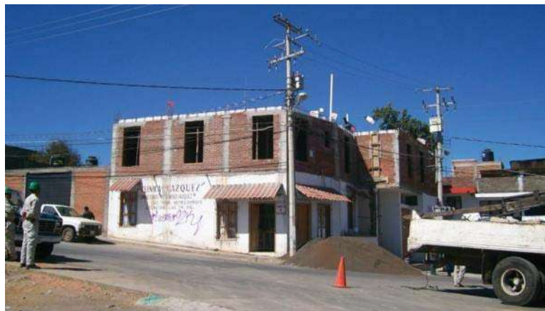
Figura 2.05. Fotografía panorámica de la fachada Este de la "Clínica Vázquez", en el momento de los trabajos de CFE para la reubicación del transformador y las líneas de media tensión.
