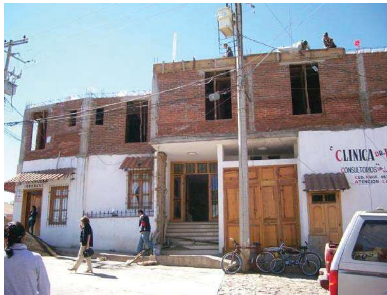
Figura 2.03. Fotografía de la fachada Este de la “Clínica Vázquez”, tomada el 20 de enero de 2008. Nótese las tareas preliminares para la edificación de la segunda losa de entrepiso.
