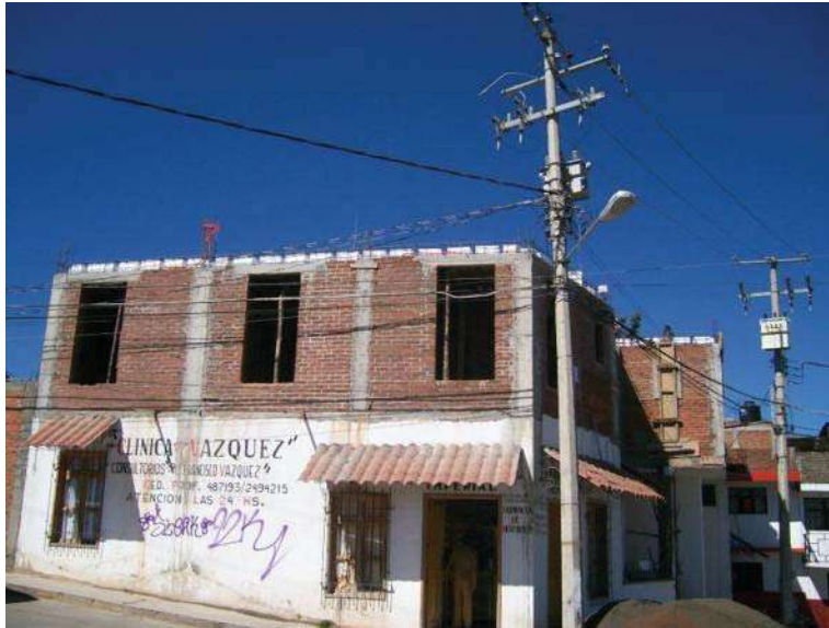
Figura 2.02. Fachada Este de la “Clínica Vázquez”, tomada el 20 de enero del 2008. Nótese las tareas preliminares para la edificación de la segunda losa de entripiso.
