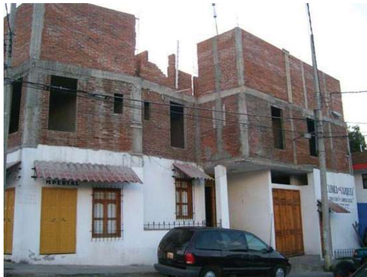
Prueba 08.- Fachada Norte de la "Clínica Vázquez"
