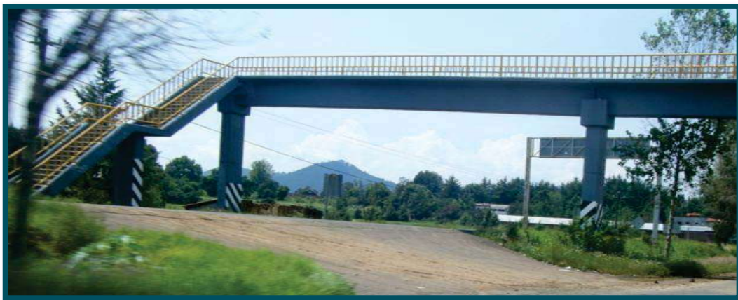
Fig. 4.9 Puente peatonal característico del estado, sometido a carga viva peatonal. Carretera Morelia – Patzcuaro
