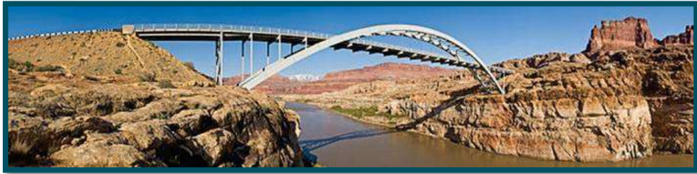
Fig. 4.5 Puente sobre el rio Colorado en EUA (WEL, 2009)
