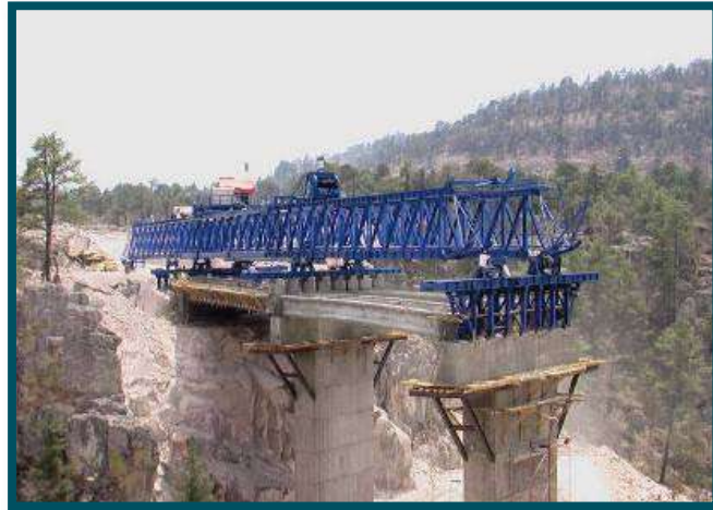
Fig. 4.7 Tablero lanzado. Puente "Canoas" en Durango (SIP, 2009)
