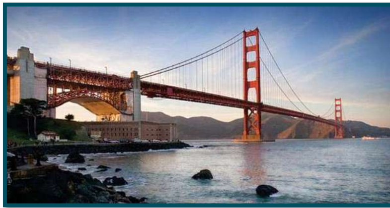
Fig. 4.6 Puente colgante "Golden Gate" (EUA). Su estructura trabaja a tensión en la mayor parte de su estructura (WEL, 2009)
