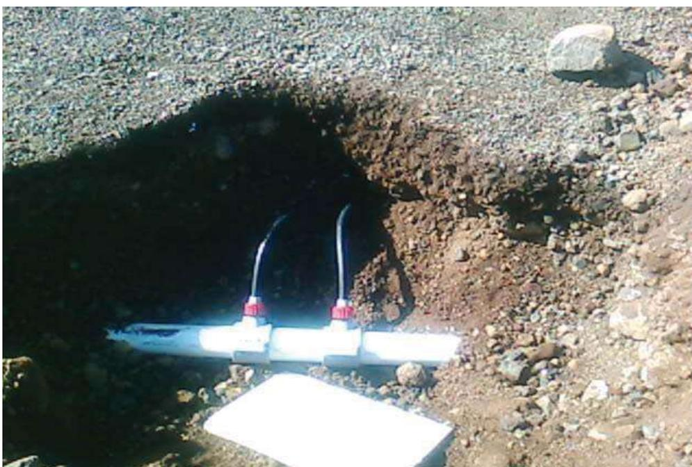
**Imagen No. 27 (Tomas domiciliarias en línea de agua potable con tubería de PVC)**
