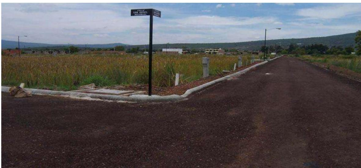
Imagen No.33 ( Guarniciones del tipo pecho paloma del fraccionamiento )
