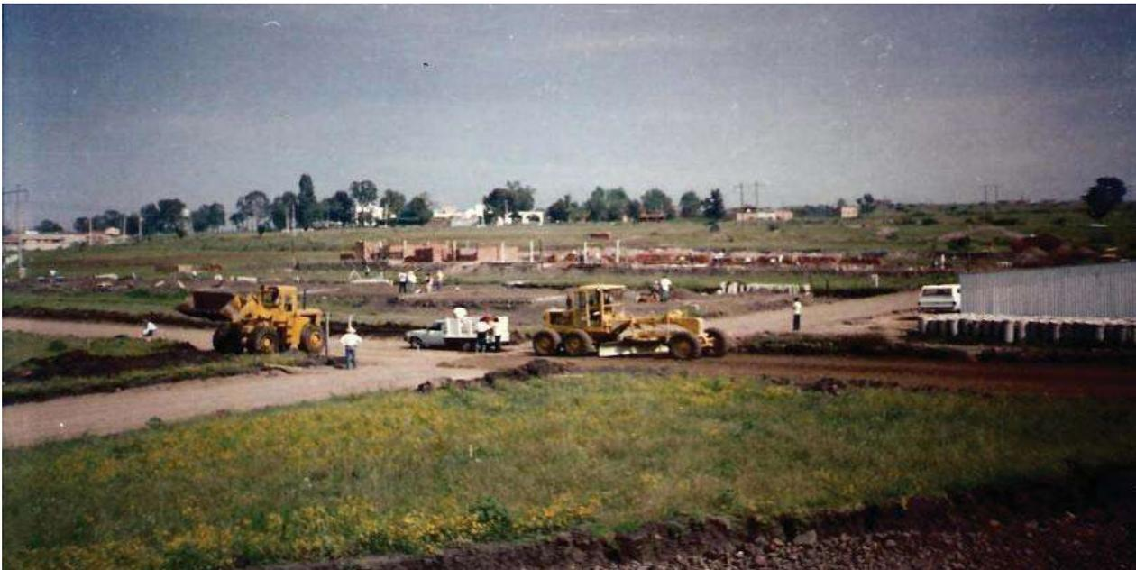
**Imagen No. 23 Tendido y compactado de la capa de Sub-Base**
