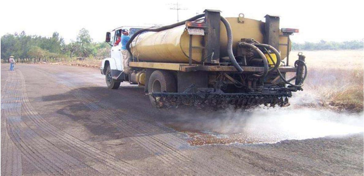
**Imagen No. 34 (Riego de liga con emulsión asfáltica y camión petrolizadora)**
