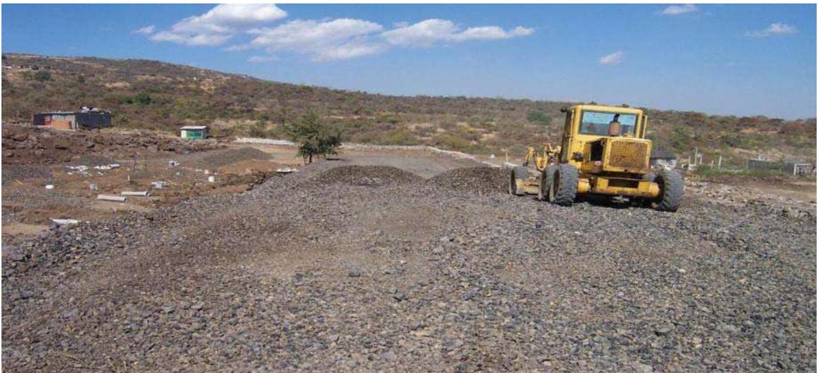
**Imagen No. 20 (Tendido de la capa de filtro con motoconformadora Caterpillar 12-F)**
