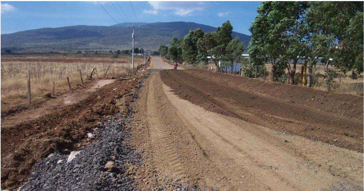
**Imagen No.30 (Tendido, mezclado e incorporación de agua a la capa de base hidráulica)**
