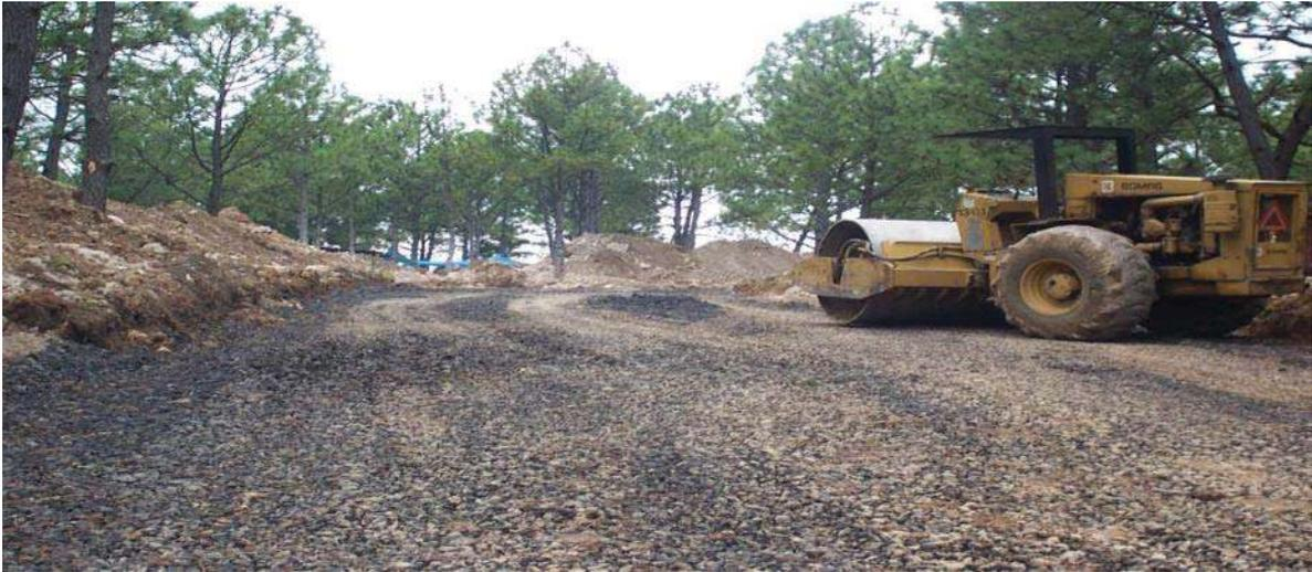
**Imagen No. 21 (Acomodo de material con rodillo vibratorio Bomag 210B)**
