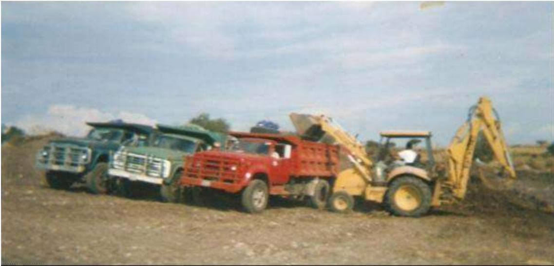
**Imagen No.6.- Carga mecánica y acarreo en camión**
