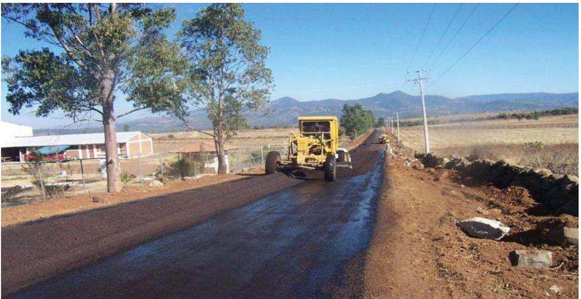
**Imagen No. 36 (Tendido de carpeta asfáltica con motoconformadora )**
