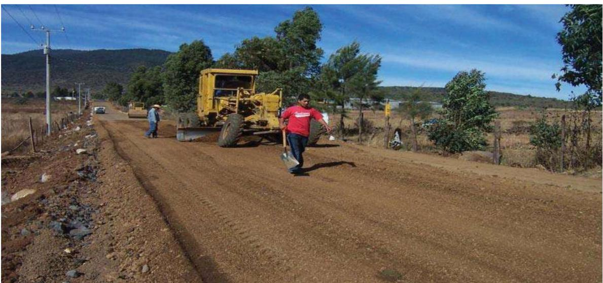
**Imagen No.31 (Tendido y nivelación de la capa de base hidráulica)**
