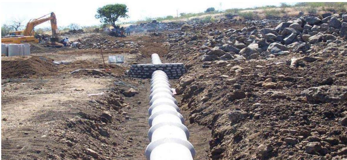
**Imagen No. 25 (Tendido de la tubería de concreto en línea de drenaje.)**
