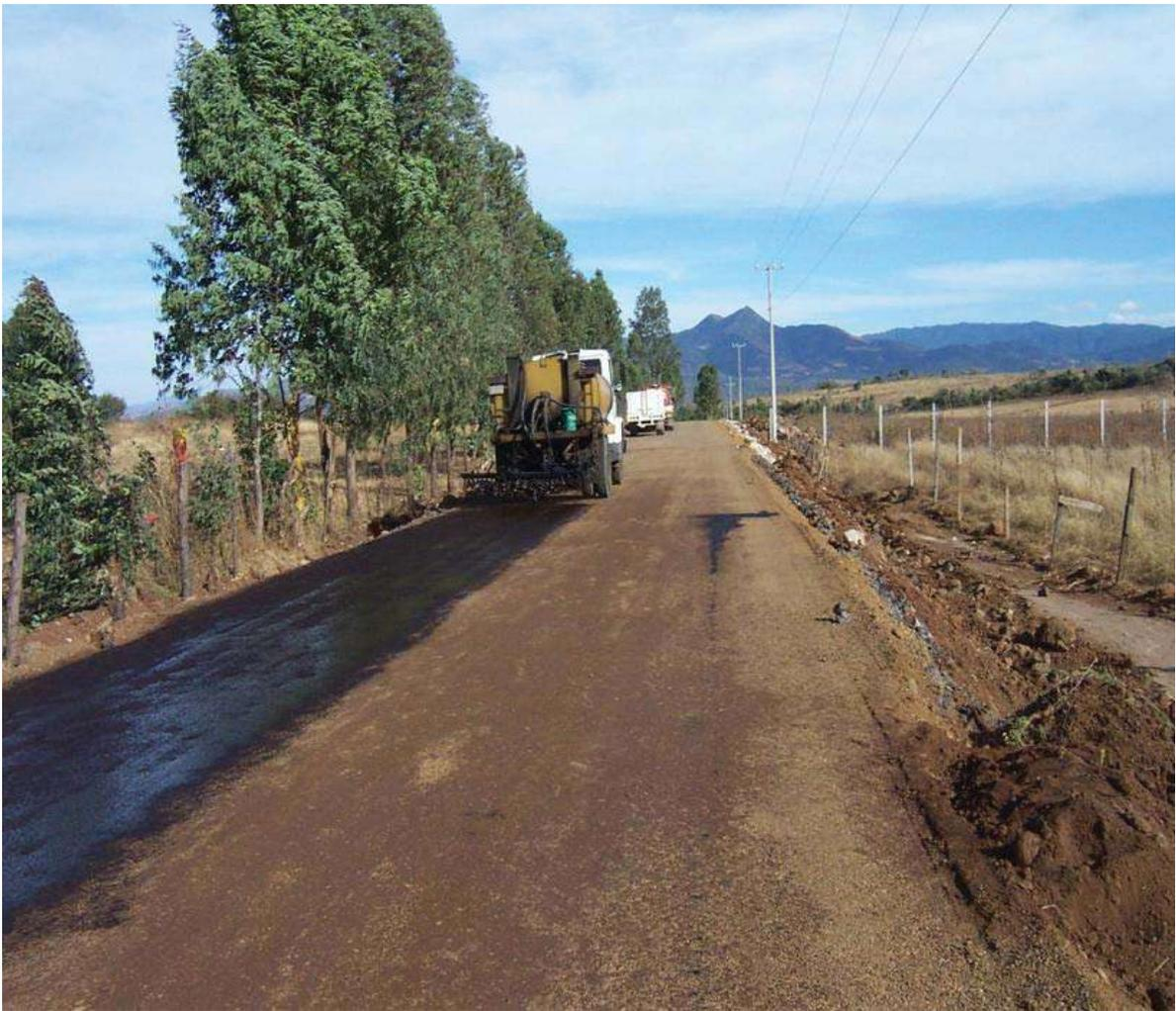
**Imagen No. 32 (Riego con emulsión asfáltica y camión petrolizadora para proteger la capa de base hidráulica para evitar la pérdida de humedad.)**
