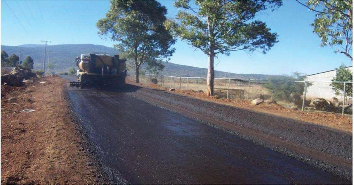
**Imagen No. 35 (Incorporación de emulsión asfáltica al material pétreo para mezcla de carpeta)**
