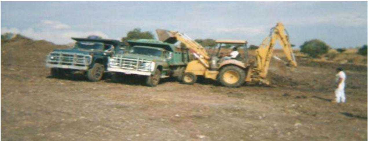
**Imagen No.5.- Carga mecánica y acarreo en camión**
