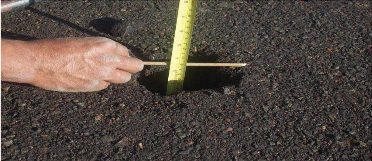
**Imagen No. 37 (Revisando espesores de carpeta asfáltica y compactación de la misma.)**
