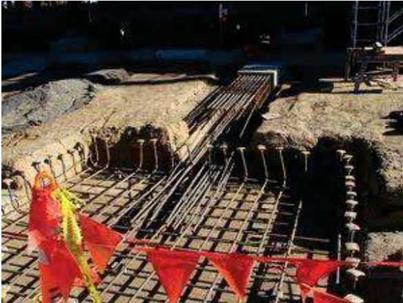
Zapata en proceso de Concreto
