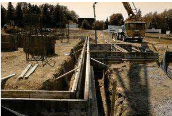
Construcción de Zapata
