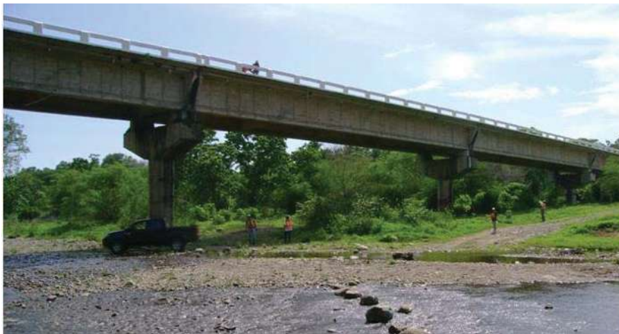
Figura 20. Vista panorámica del puente
