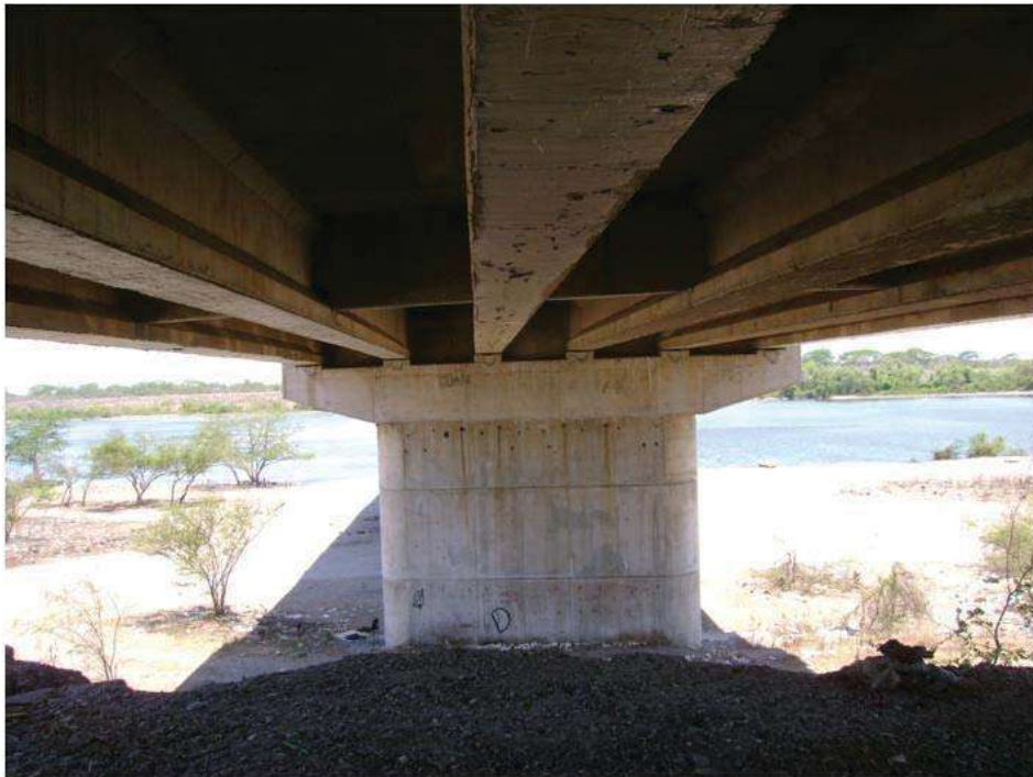
Figura 12. Vista frontal de pilas
