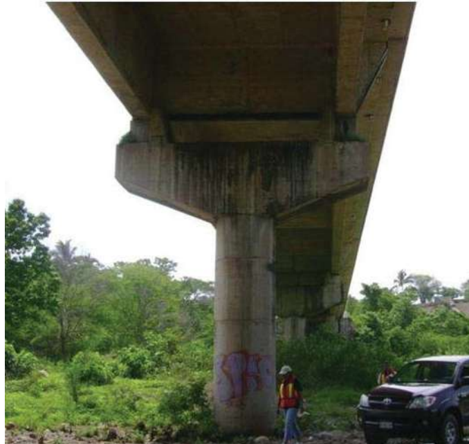
Figura 22. Vista frontal de la pila y el cabezal
