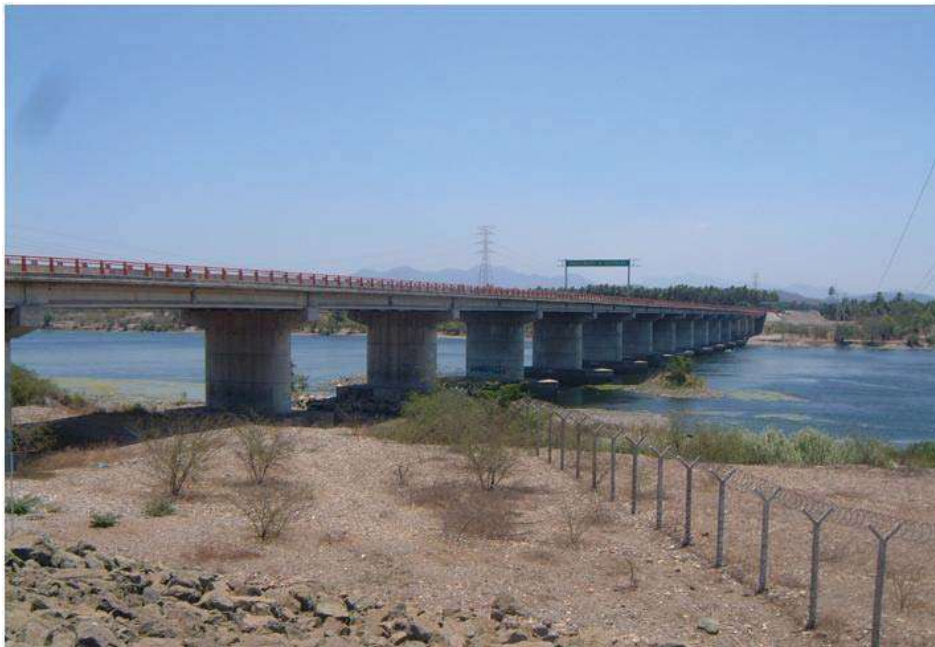
Figura 7. Vista panorámica del puente
