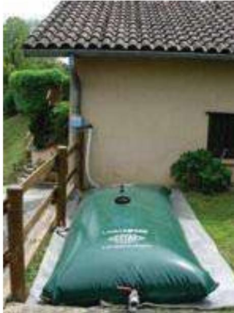
Fotografía No. 37 Depósito tipo bolsa.
