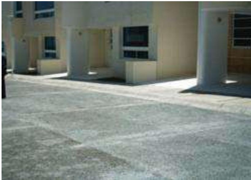
*Fotografía No. 4 Ecocreto utilizado como pavimento en fraccionamientos.*
