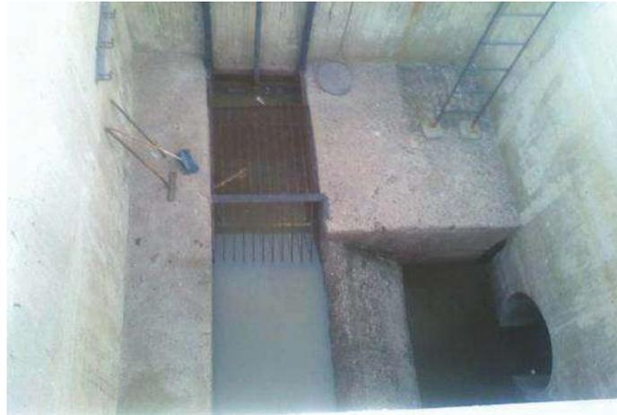
Figura II.9. Sistema de rejillas de la PTAR de La Piedad de Cadas
