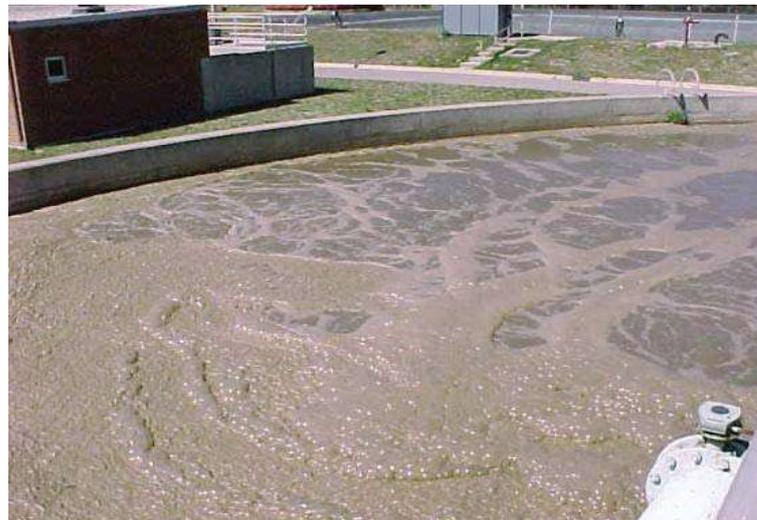
**Figura II.10. Proceso Aerobio (Canal de oxidación)**
