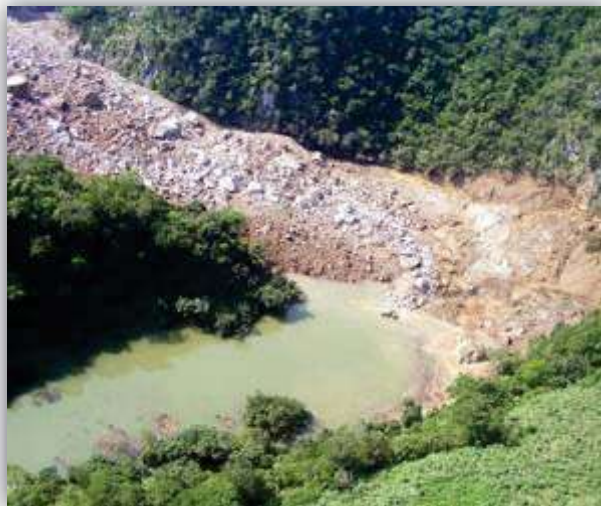
Figura 35. Dique de deslizamiento formado por el derrumbe del cerro La Hujera. Fuente: http://www.oem.com.mx/elsoldemexico/notas/n878386.htm
