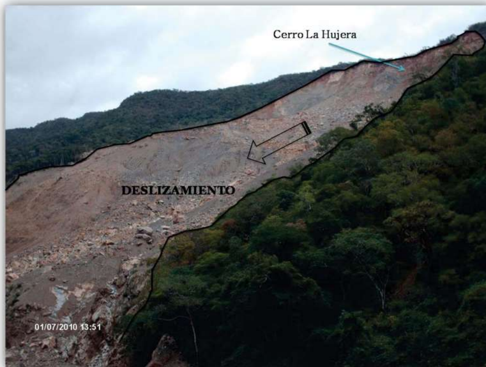
Figura 48. Deslizamiento traslacional del Cerro La Hujera, conocido como deslizamiento La Huahua. Se puede observar la parte deslizada del cerro.
