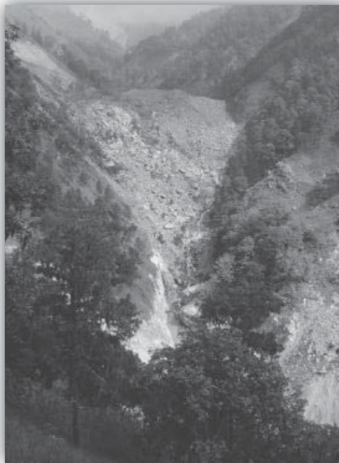
Figura 33. Dique de deslizamiento de tierra en el río La Lima, viendo río arriba (norte) desde un punto a 4 km al norte de Jones; fotografía tomada el 25 de enero del 2000. Fuente: Schuster, Bucknam, Mota, 2001.
