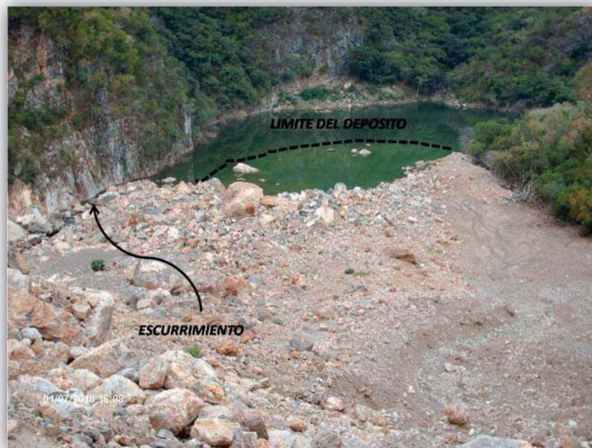
Figura 55. En esta fotografía: con la línea punteada se indica el límite del depósito y la salida que ha encontrado el agua, para seguir su curso.
