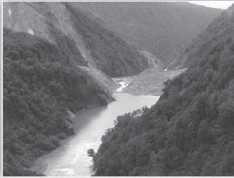
Figura 26. Vista del lago formado en el río Poerua, después de la ruptura del dique. Fuente: West Coast Regional Council, 2002.
