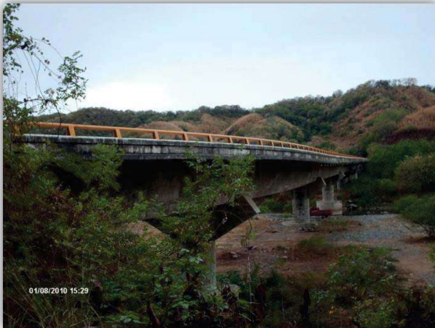
Figura 64. Vista lateral del puente Huahua, Aquila Mich.
