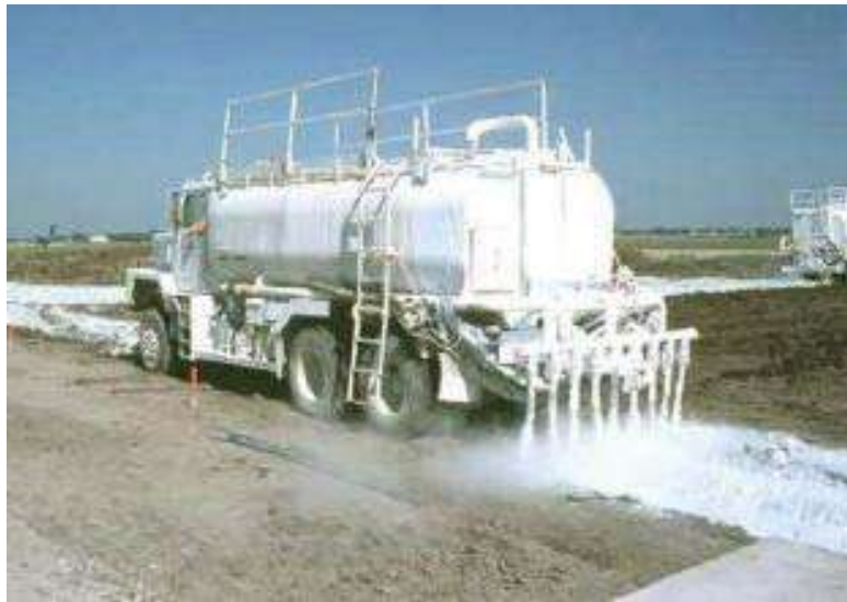
Figura 2.- Proceso constructivo de una estabilización química en un camino
