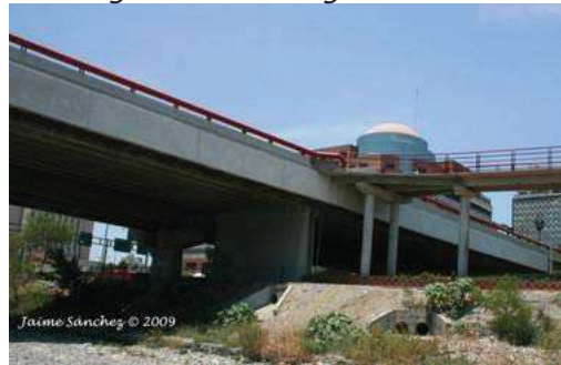
Puente Zaragoza, Monterrey.
