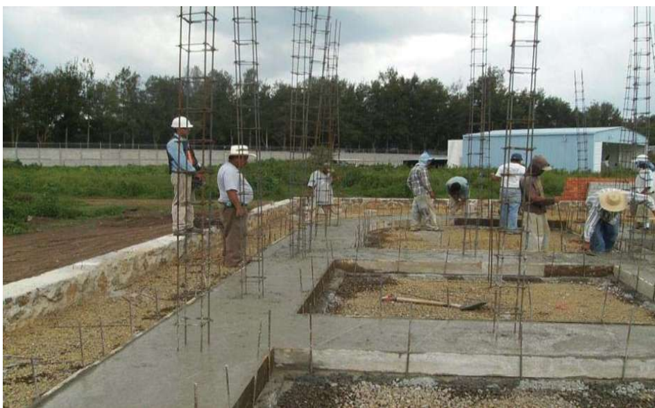
DESPLANTE DE CIMENTACION SOBRE EL TERRENO MEJORADO.
