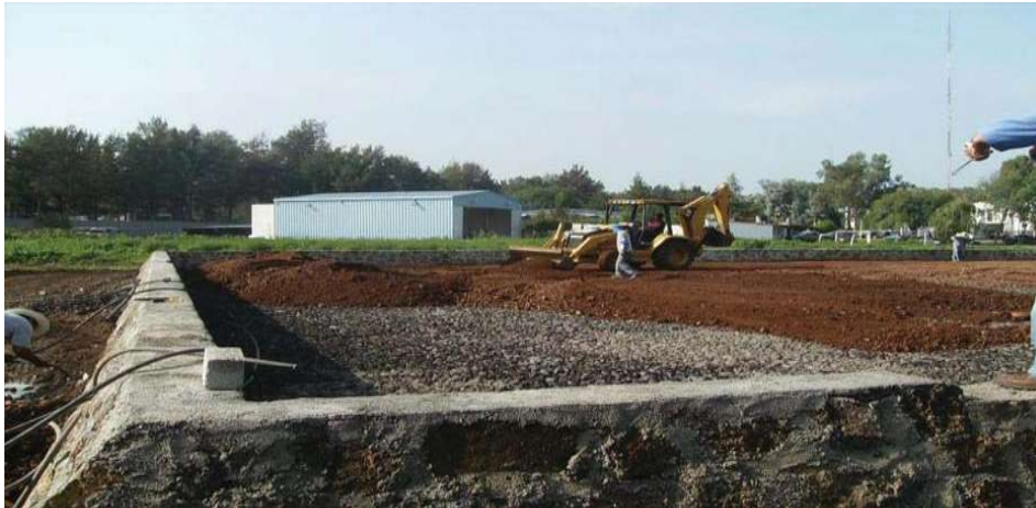
DESPLANTE DE CIMENTACION SOBRE EL TERRENO MEJORADO.
