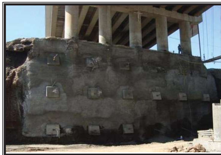
Talud una vez estabilizado.
