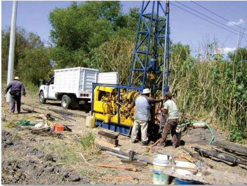
Figura 40.- Colocación del equipo de Penetración Estándar
