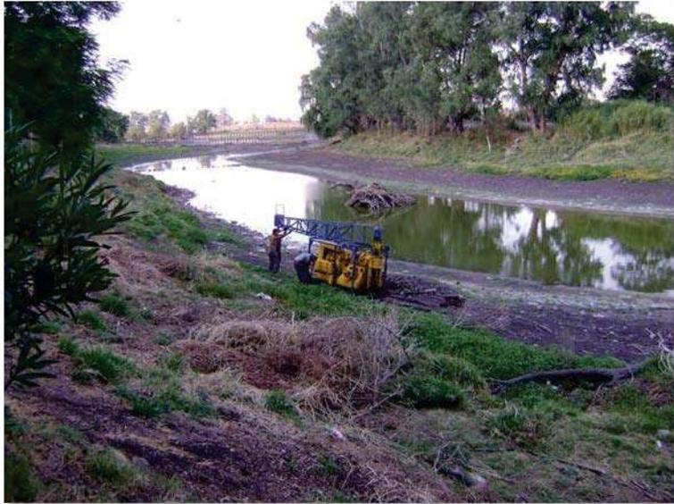
Figura 42.- Colocación de equipo de penetración estándar, Puente 1, Sondeo 01
