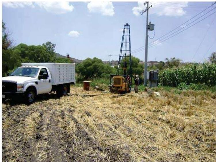
Figura 43.- Colocación del equipo de penetración estándar, Puente 2, Sondeo 04
