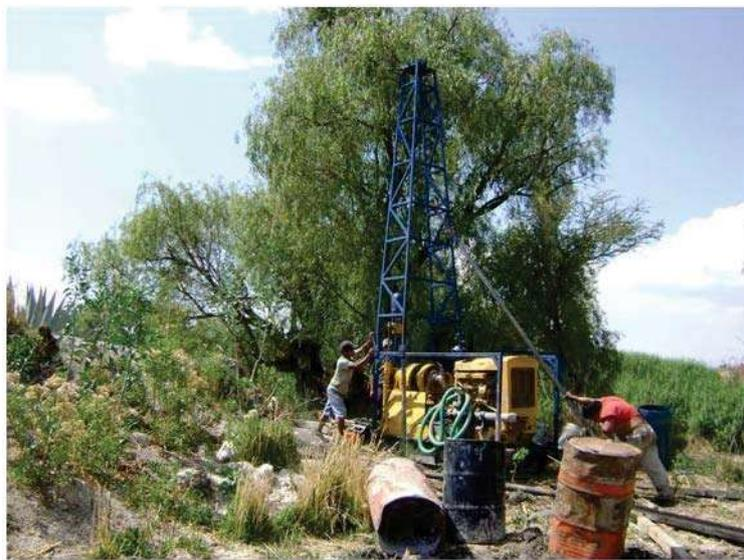
Figura 135.- Colocación de equipo de penetración estándar, Cárcamo de Bombeo
