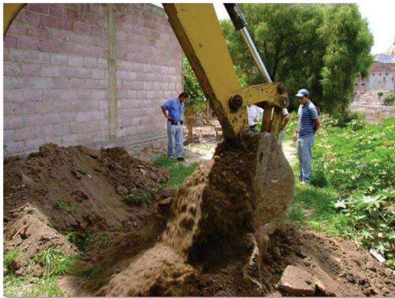
Figura 44.- Excavación de PCA 5 para Puente Peatonal
