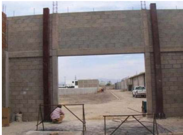
FOTOGRAFÍA No. 87. Columnas de acero.
