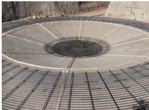
FOTOGRAFÍA No. 67. Colocación de bandas de P.V.C.
