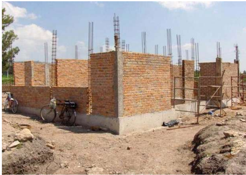
FOFOTOGRAFÍA No. 73. Colocación de tabiques en muros.
