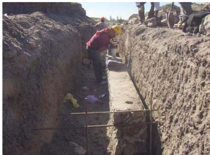
FOTOGRAFÍA No. 35. Cimentación de piedra braza.
