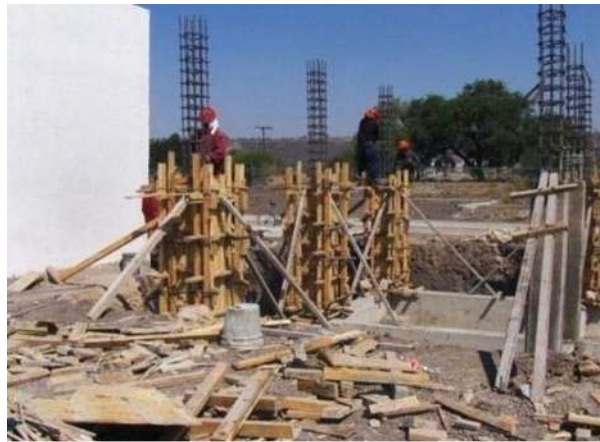
FOTOGRAFÍA No. 82. Colocación de cimbra.
