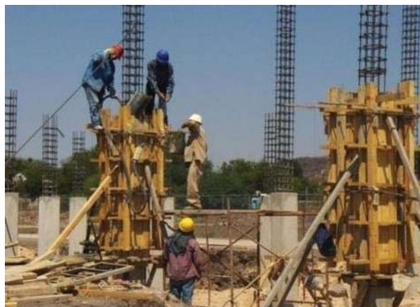
FOTOGRAFÍA No. 83. Colocación y vibrado de concreto.
