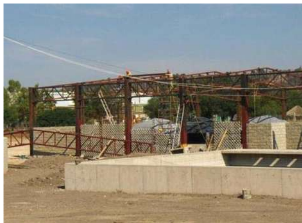
FOTOGRAFÍA No. 91. Colocación de armaduras.
