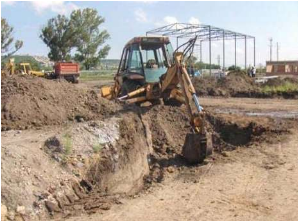
FOTOGRAFÍA No. 40. Excavación del terreno natural.
