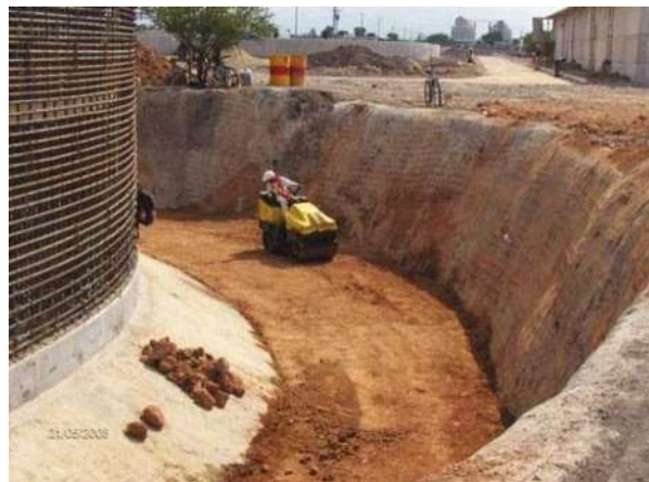
FOTOGRAFÍA No. 72. Sección de concreto descimbrada y compactación del relleno de la sobre excavación
