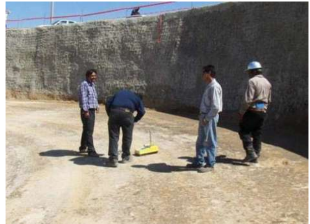
FOTOGRAFÍA No. 64. Verificación de las compactaciones mediante un densímetro nuclear.
