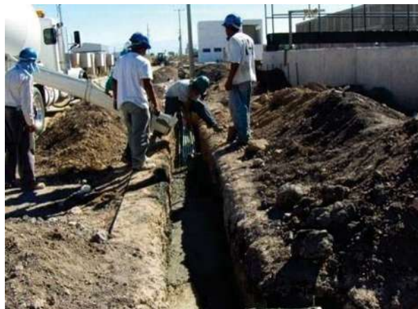
FOTOGRAFÍA No. 96. Colocación de encofrado.
