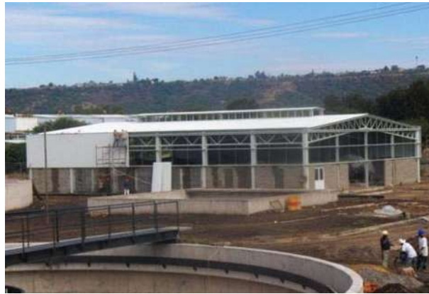
FOTOGRAFÍA No. 94. Colocación de faldón.
