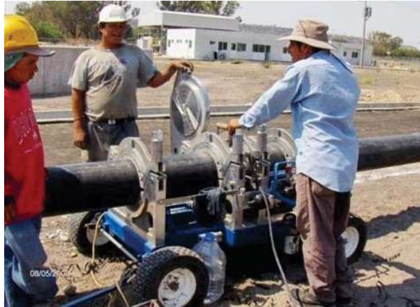
FOTOGRAFÍA No. 98. Tubería unida por termo-fusión.
