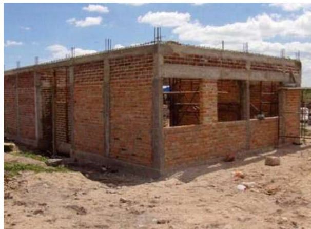
FOTOGRAFÍA No. 74. Muros terminados.
