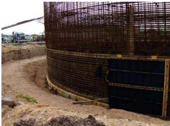
FOTOGRAFÍA No. 75. Acero de fuerzo en muros.
