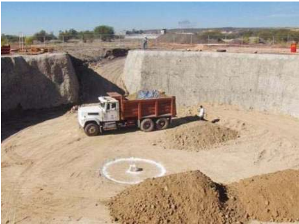
FOTOGRAFÍA No. 63. Trabajos de relleno con material de banco.
