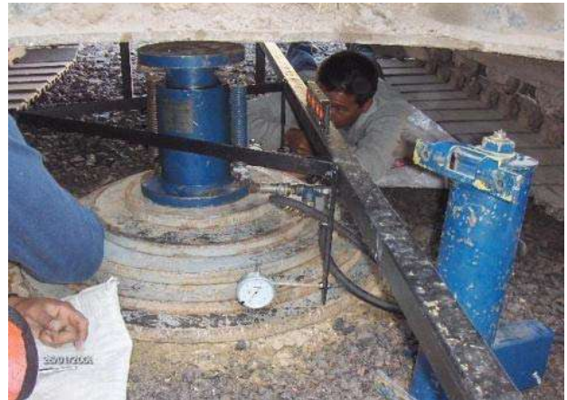
FOTOGRAFÍA No. 62. Realización de la prueba de placa.
