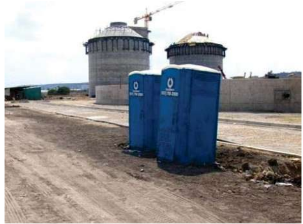
FOTOGRAFÍA No. 33. Letrinas portátiles: se dispondrán en lugares de fácil acceso y se colocaran agua potable para el aseo.
