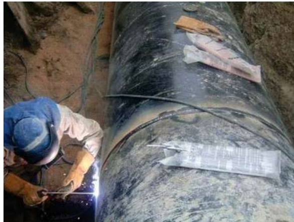
FOTOGRAFÍA No. 103. Aplicación de soldadura.
