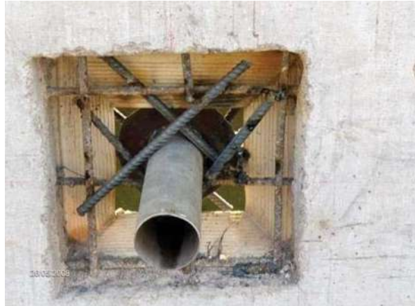
FOTOGRAFÍA No. 99. Preparación de paso de tubería.
