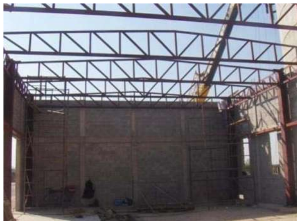
FOTOGRAFÍA No. 88. Armaduras.
