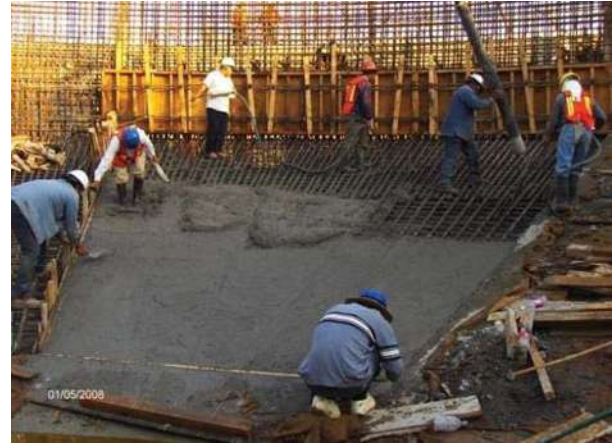
FOTOGRAFÍA No. 70. Proceso de colocación del concreto.
