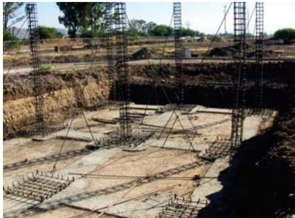
FOTOGRAFÍA No. 81. Armado de columnas.
