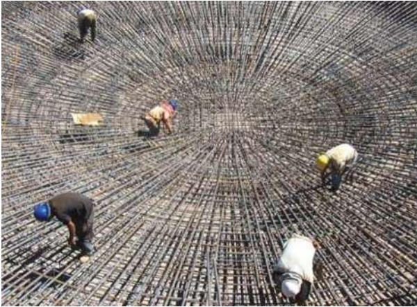
FOTOGRAFÍA No. 66. Colocación, limpieza y revisión del acero estructural en la losa de cimentación.
