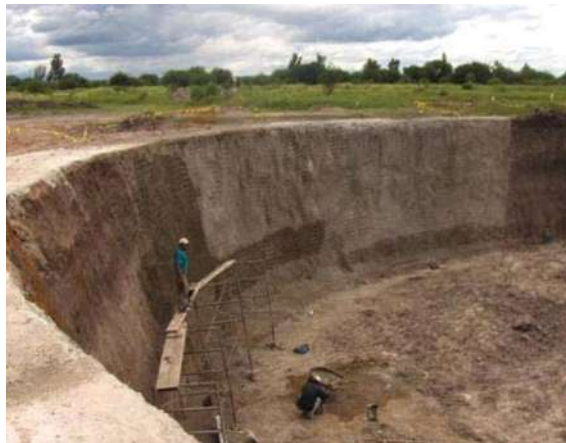
FOTOGRAFÍA No 60. Colocación de malla electro soldada y mortero en taludes.
