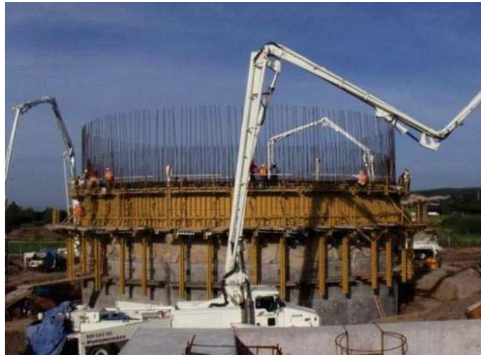
FOTOGRAFÍA No.79. Colocación de concreto.
