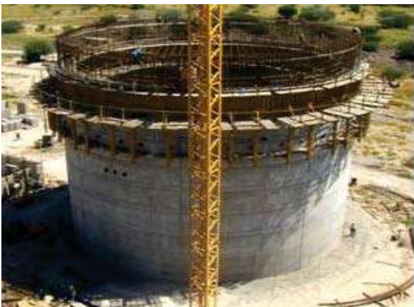
FOTOGRAFÍA No. 29. Andamio exterior con barandales
