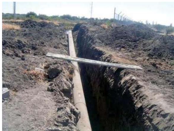
FOTOGRAFÍA No. 97. Tubería colocada en excavación.
