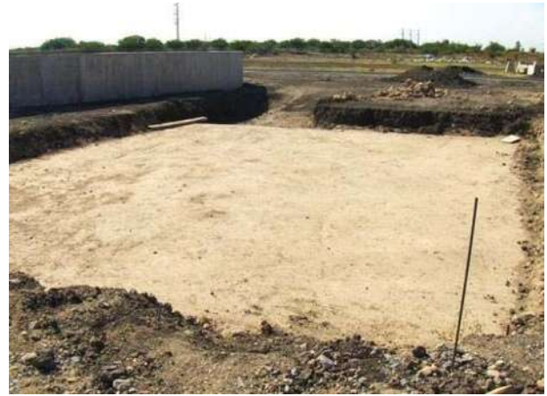
FOTOGRAFÍA No. 41. Mejoramiento del terreno natural.
