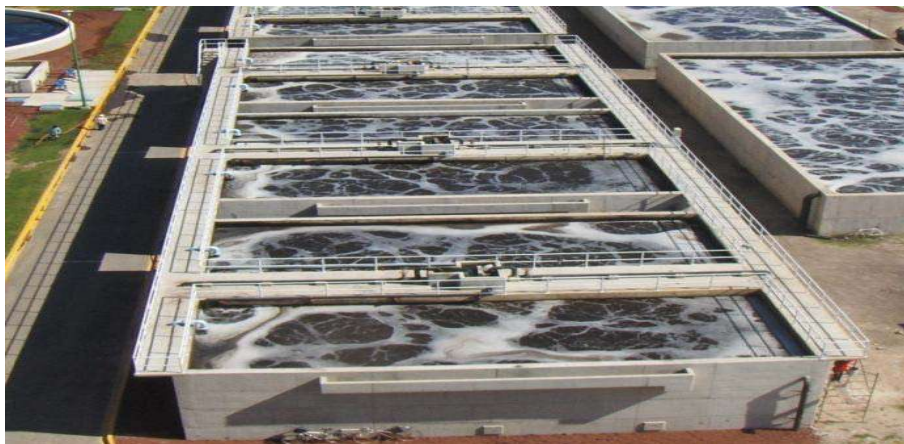
FOTOGRAFÍA No. 14. Reactor aerobio primera fase.
