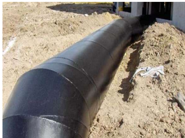
FOTOGRAFÍA No. 105. Tubería instalada
