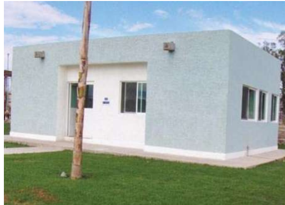
FOTOGRAFÍA No. 34. Oficina de administración de la planta del modulo de 150 lps.
