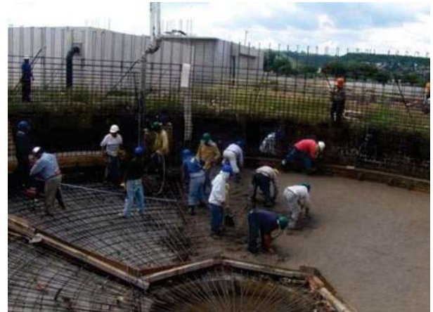
FOTOGRAFÍA No. 55. Colocación y acomodo del concreto en losas de cimentación.
