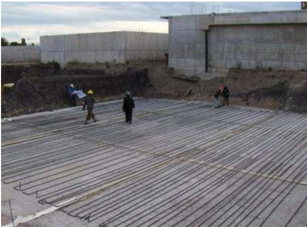
FOTOGRAFÍA No. 53. Colocación de acero de refuerzo en losas de cimentación.
