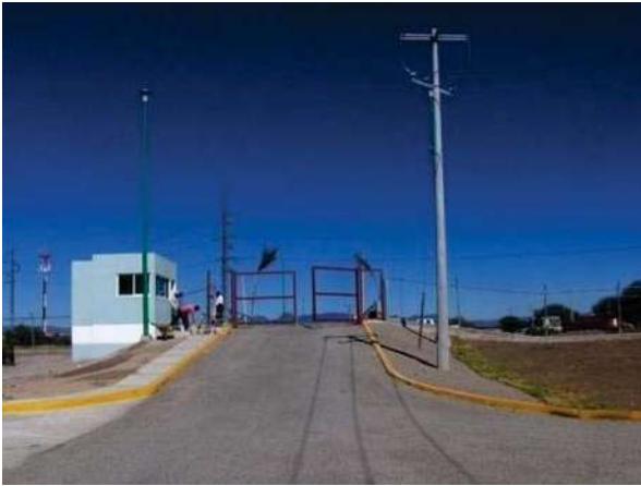
FOTOGRAFÍA No. 23. Caseta de vigilancia para el control de acceso.
