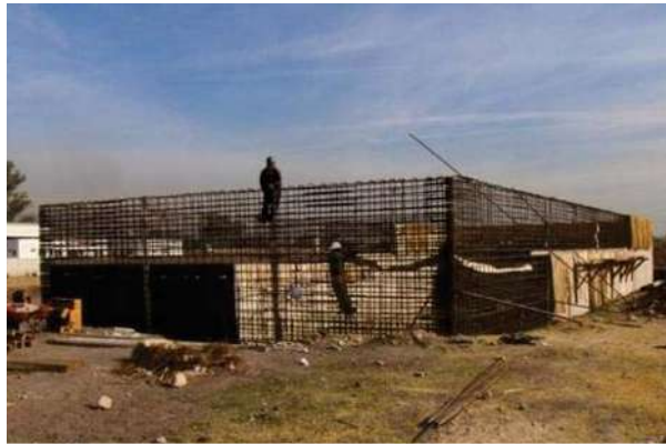
FOTOGRAFÍA No. 76. Colocación de banda de P.V.C.
