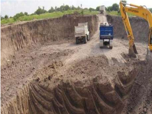
FOTOGRAFÍA No.58. Proceso de excavación y retiro de material.
