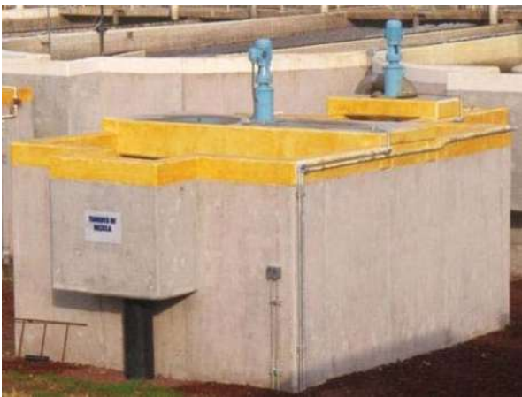
FOTOGRAFÍA No. 10. Tanque mezclador.
