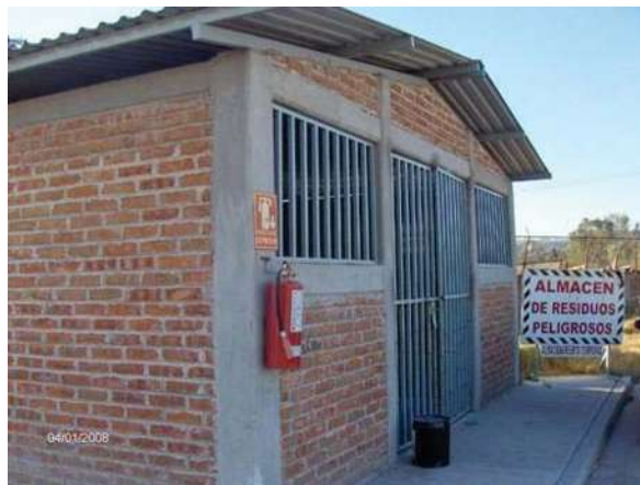
FOTOGRAFÍA No. 32. Almacén de residuos peligrosos. Deberá estar rotulado, contará con extinguidor y estará bien ventilado para evitar la acumulación de gases peligrosos.
