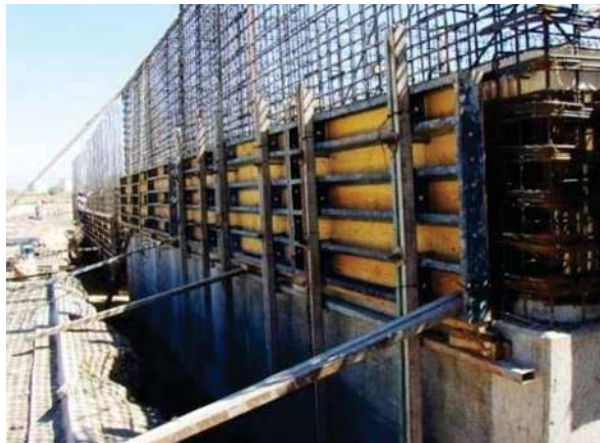
FOTOGRAFÍA No. 77. Cimbra en muros
