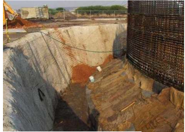
FOTOGRAFÍA No. 71. Colocación de costales de yute para el curado del concreto.
