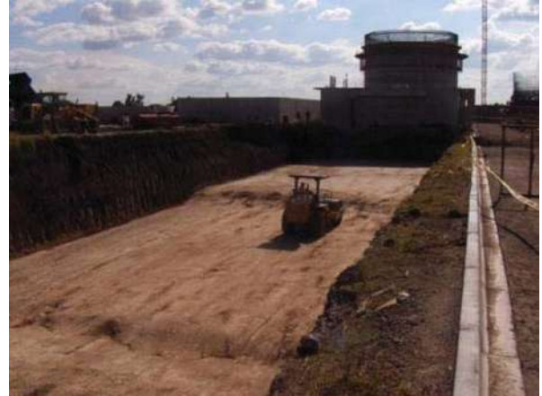
FOTOGRAFÍA No. 52. Trabajos de compactación.
