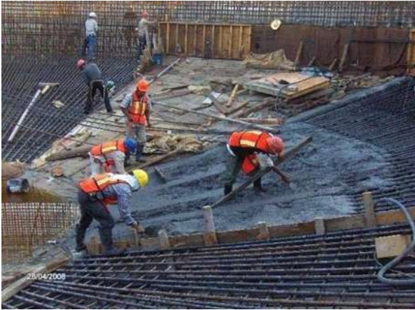
FOTOGRAFÍA No. 70. Proceso de colocación del concreto.
