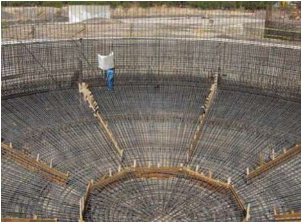
FOTOGRAFÍA No. 68. Colocación de cimbra en losa de cimentación.
