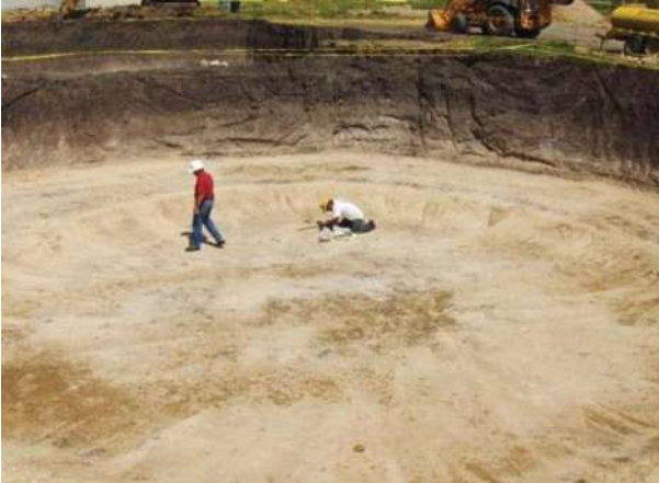
FOTOGRAFÍA No. 51. Revisión de la compactación.
