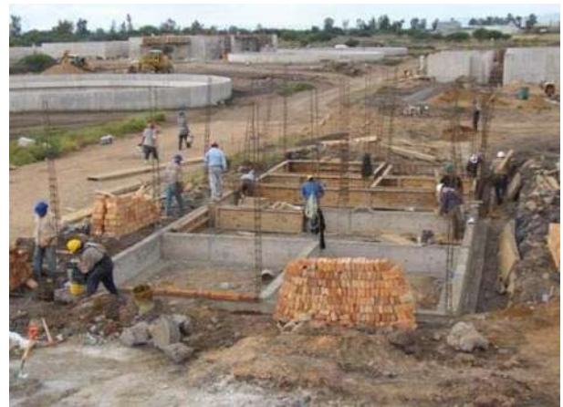
FOTOGRAFÍA No. 45. Cimentación terminada.
