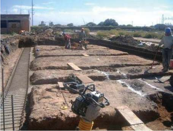
FOTOGRAFÍA No. 42. Colocación del acero en rodapié.
