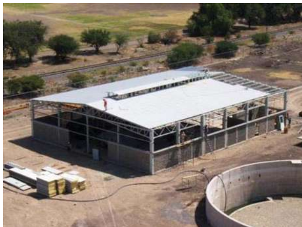
FOTOGRAFÍA No. 93. Colocación de láminas.
