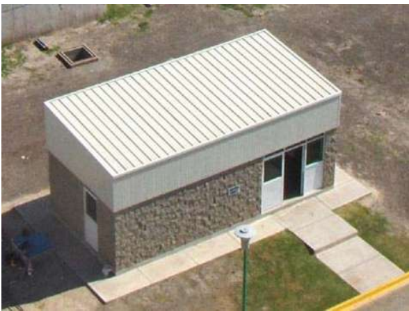
FOTOGRAFÍA No. 38. Centro de control de motores.
