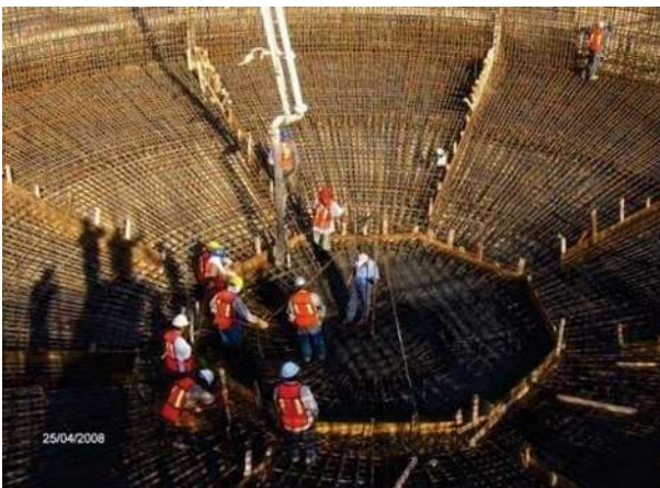
FOTOGRAFÍA No. 27. Personal laborando con equipo de seguridad
