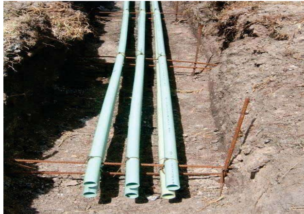
FOTOGRAFÍA No.96. Colocación de tubería en dos camas en soportes de varilla.
