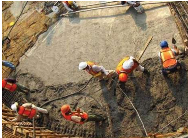
FOTOGRAFÍA No. 70. Proceso de colocación del concreto.
