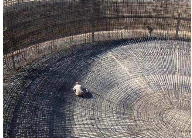
FOTOGRAFÍA No. 66. Colocación, limpieza y revisión del acero estructural en la losa de cimentación.
