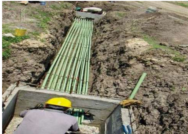
FOTOGRAFÍA No. 95. Colocación de tubería.
