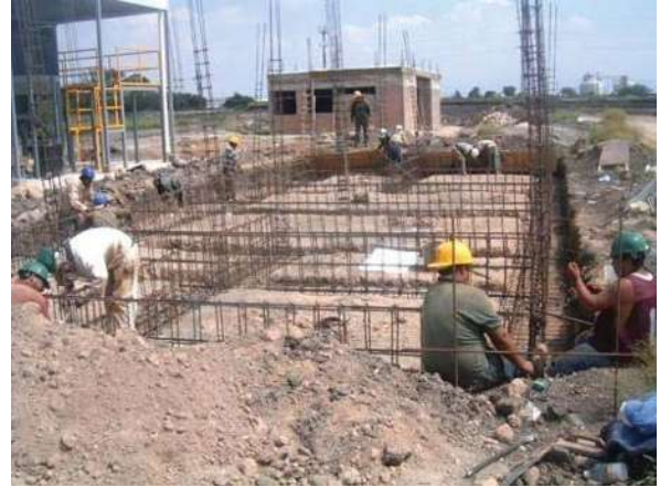
FOTOGRAFÍA No. 43. Colocación de traveses de liga.
