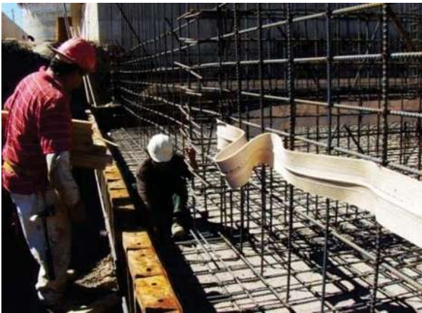
FOTOGRAFÍA No. 54. Colocación y revisión de la cimbra antes de la colocación de concreto.
