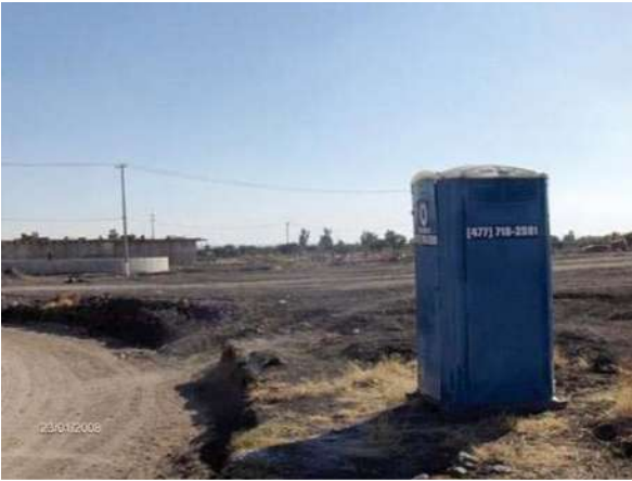
FOTOGRAFÍA No. 33. Letrinas portátiles: se dispondrán en lugares de fácil acceso y se colocaran agua potable para el aseo.
