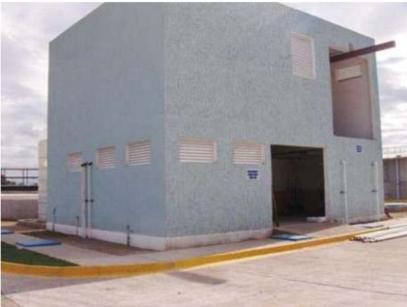
FOTOGRAFÍA No. 36. Caseta de químicos.
