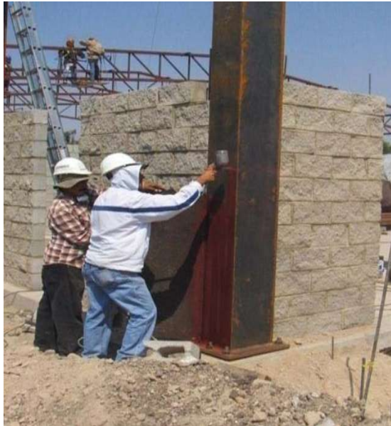
FOTOGRAFÍA No. 90. Aplicación de pintura
