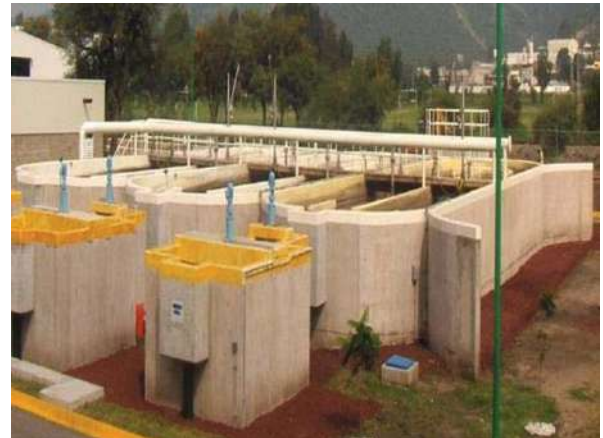
FOTOGRAFÍA No. 9. Tanque de homogenización, panorámica.
