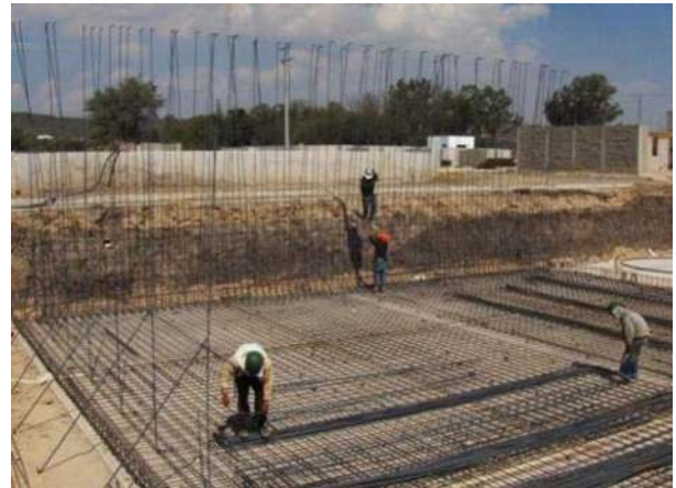
FOTOGRAFÍA No. 53. Colocación de acero de refuerzo en losas de cimentación.
