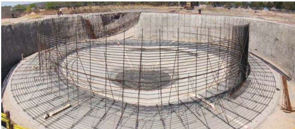
FOTOGRAFÍA No. 65. Colocación del acero estructural en la losa de cimentación.
