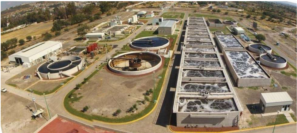
FOTOGRAFÍA No. 1. Vista panorámica de la Planta de tratamiento de aguas residuales modulo de desbaste 150 lps.
