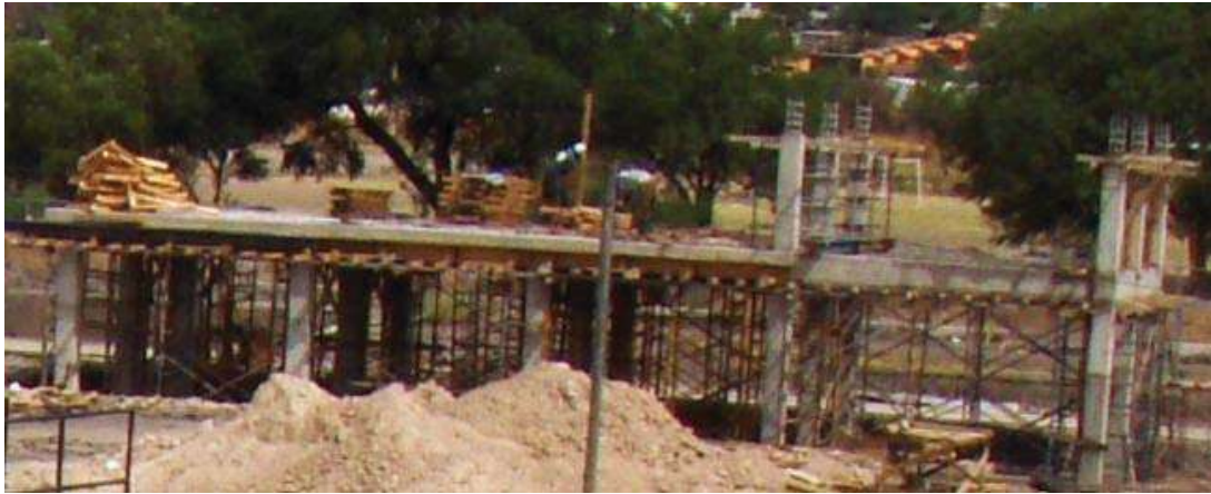
FOTOGRAFÍA No. 84. Columnas terminadas.
