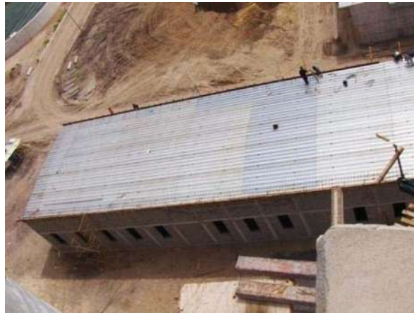
FOTOGRAFÍA No. 89. Lámina montada sobre armaduras.
