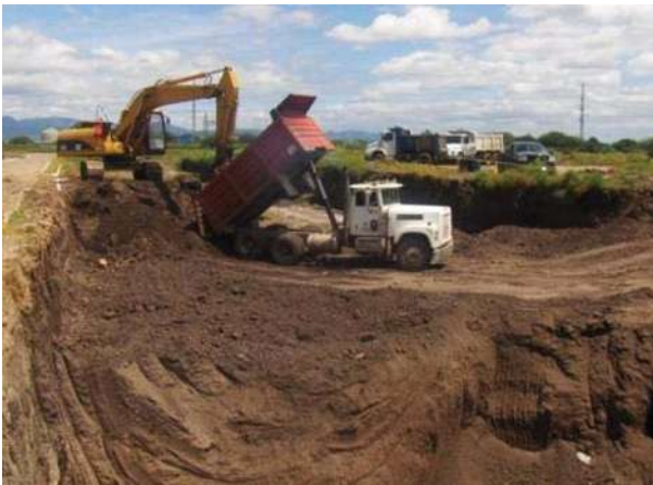
FOTOGRAFÍA No. 50. Excavación y acarreo de material, hacia los lugares designados para su depósito.
