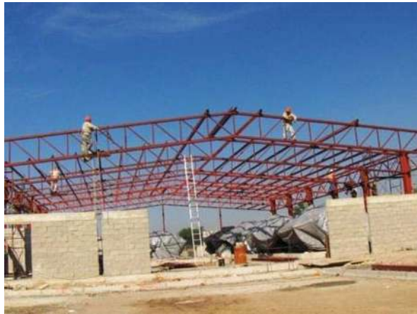
FOTOGRAFÍA No. 92. Colocación de los perfiles.
