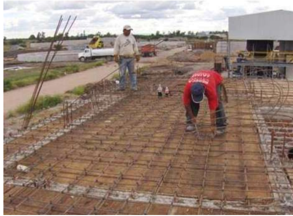
FOTOGRAFÍA No. 85. Colocación de acero de refuerzo.
