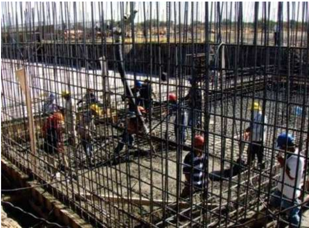
FOTOGRAFÍA No. 55. Colocación y acomodo del concreto en losas de cimentación.
