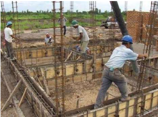
FOTOGRAFÍA No. 44. Colocación de concreto.
