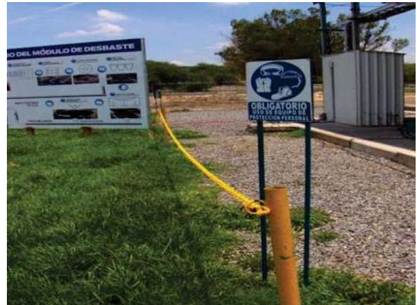
FOTOGRAFÍA No. 26. Señales indicativas establecidas en lugares de riesgo.
