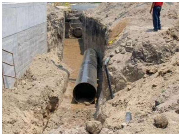
FOTOGRAFÍA No. 100. Tubería colocada sobre cama de arena.
