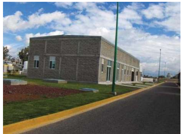
FOTOGRAFÍA No. 39. Caseta intercambiador de calor.
