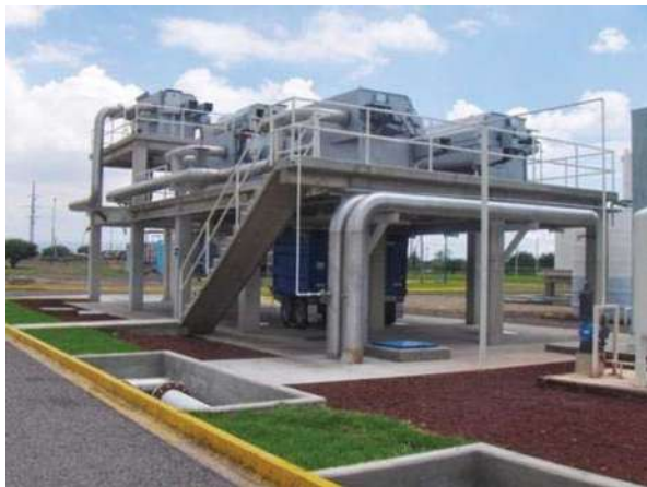
FOTOGRAFÍA No. 4. Micro cribas vista frontal.
