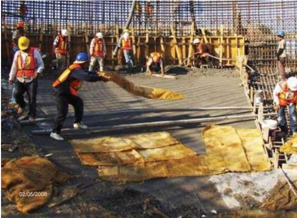
FOTOGRAFÍA No. 71. Colocación de costales de yute para el curado del concreto.
