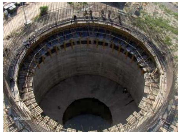
FOTOGRAFÍA No. 30. Andamio interior con barandales.
