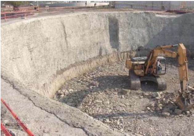
FOTOGRAFÍA No. 61. Trabajos de colocación y acomodo de pedraplen.
