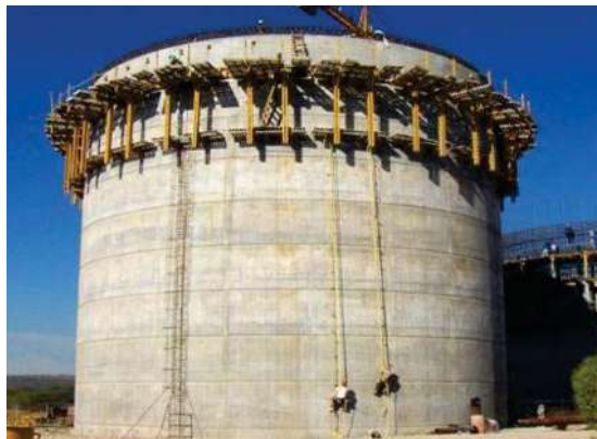
FOTOGRAFÍA No. 80. Muro terminado.
