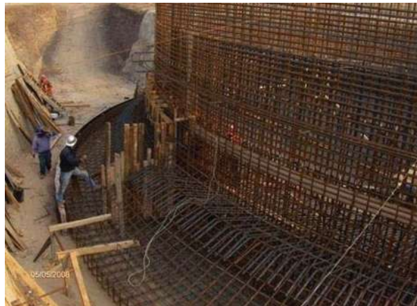
FOTOGRAFÍA No. 69. Colocación de cimbra en fuste de cimentación.
