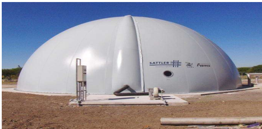
FOTOGRAFÍA No. 22. Tanque de almacenamiento de biogás que será utilizado en la cogeneración.
