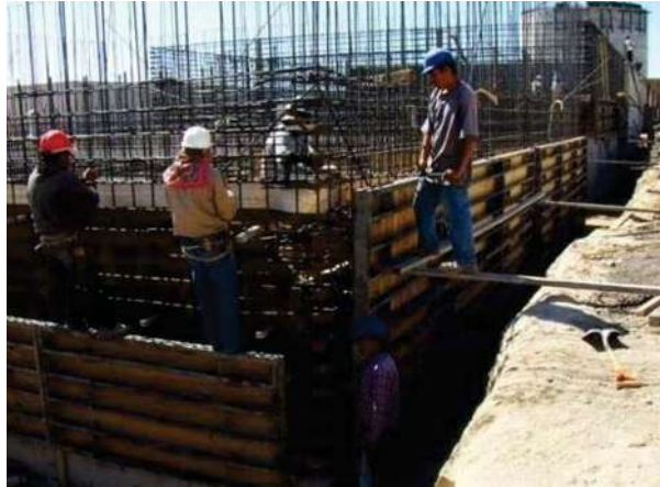
FOTOGRAFÍA No. 78. Colocación de banda P.V.C.
