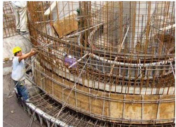
FOTOGRAFÍA No. 54. Colocación y revisión de la cimbra antes de la colocación de concreto.
