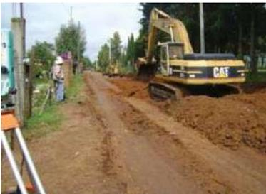
Excavación en caja para alojar estructura km 0+300
