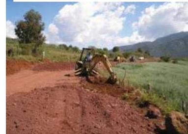
Excavación en caja para formación de escalón de liga km 2+700
