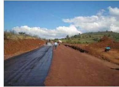
Riego de impregnación con emulsión de rompimiento medio para colocación del poreo a base de arena
