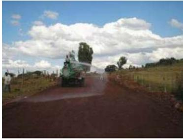
Riego para mantener la humedad de la base hidráulica previo a la colocación del riego de impregnación
