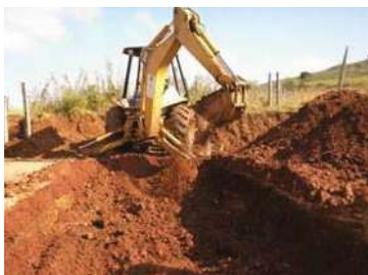
Excavación para alojar obras de drenaje a base de tubo de polietileno de 1.20 de diámetro
