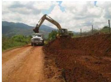
Excavación en caja fuera de camino existente km 2+800
