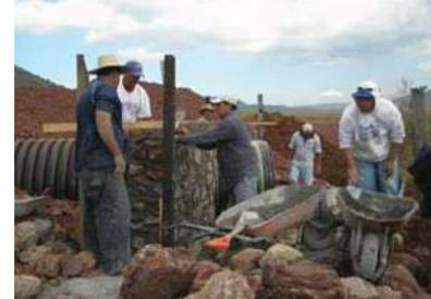
Construcción de cabezotes en obras de drenaje a base de tubo de polietileno
