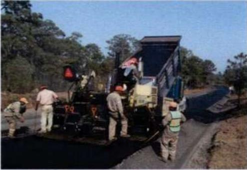
Concepto: Carpeta asfáltica con mezcla en caliente
