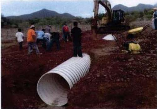
Concepto: Tubería de polietileno de 122 cm
