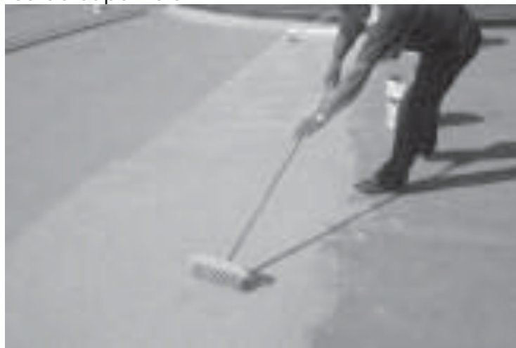
Figura 2.16. Uso de la Cal como Pintura
