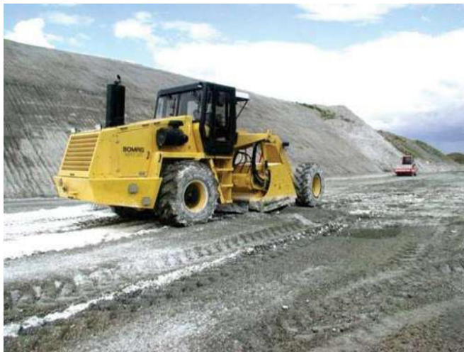
Figura 2.19. Estabilización de Suelos
