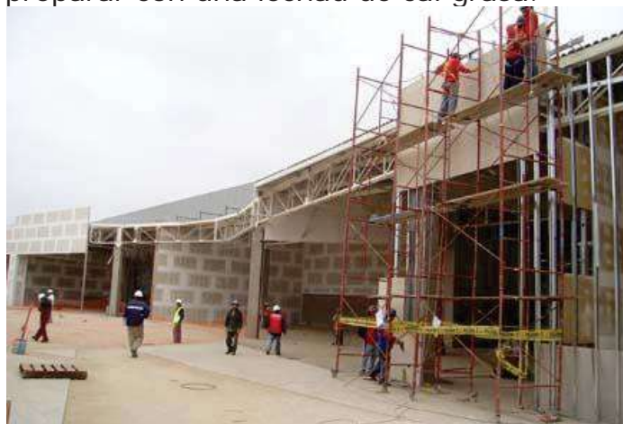
Figura 2.14. Pegado de Piezas en superficies verticales
