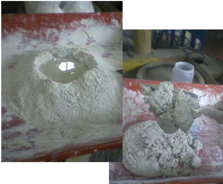
Figura 5.2. Elaboración de la Mezcla para Mamposterías
