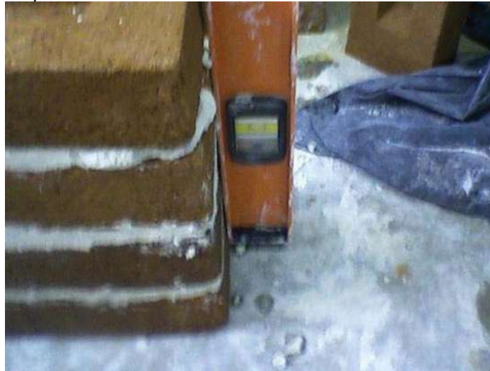
Figura 5.4. Nivelación de Pilas
