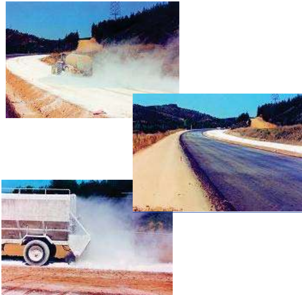
Figura 2.20. Estabilización de Terracerías
