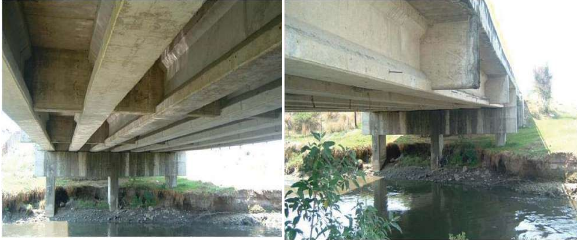
Fotografías 3 y 4. Puente ubicado en el kilometro 24 sobre el río Lerma, tramo Atlacomulco-Toluca. Características del puente:
