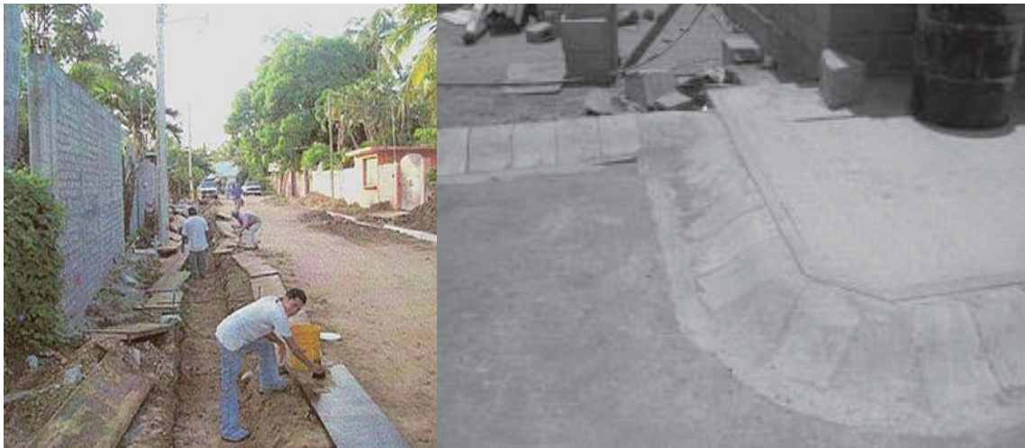
Imagen VI.20 Guarniciones tipo pecho de paloma
