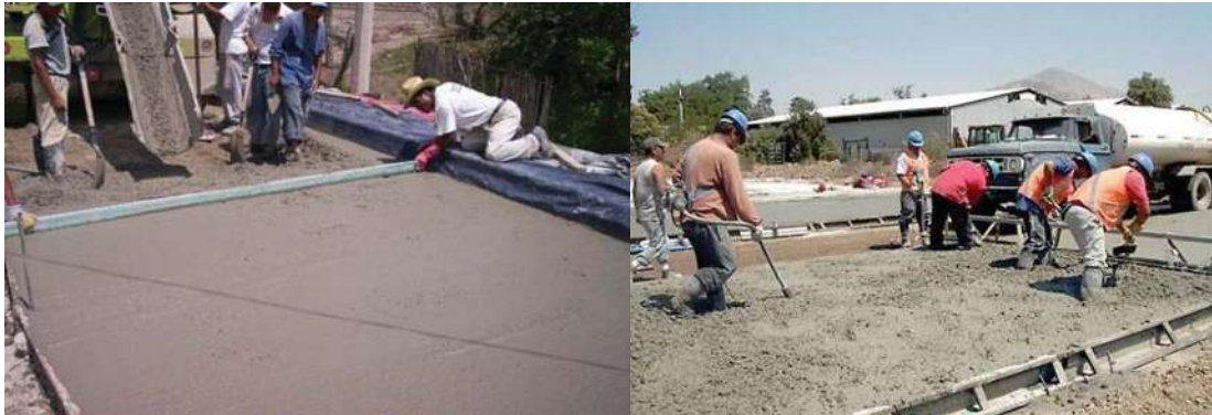
Imagen VI.21 Colado del concreto
