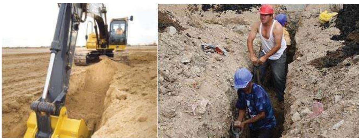
Figura IV.3 Excavación de zanjas
