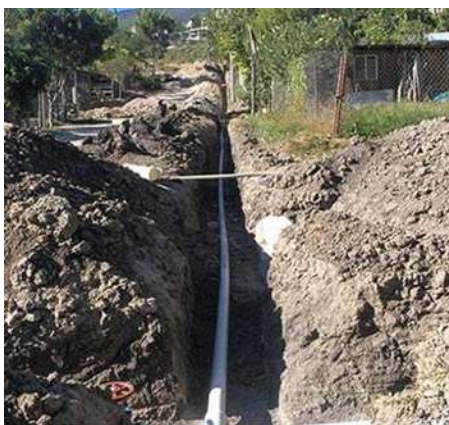
Imagen VI.15 Tubería colocada en la zanja
