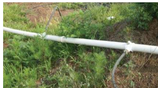
Imagen VI.16 Colocación de la toma domiciliaria
