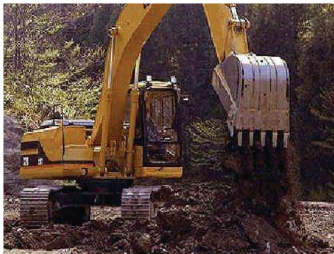
Imagen VI.13 Relleno de la zanja
