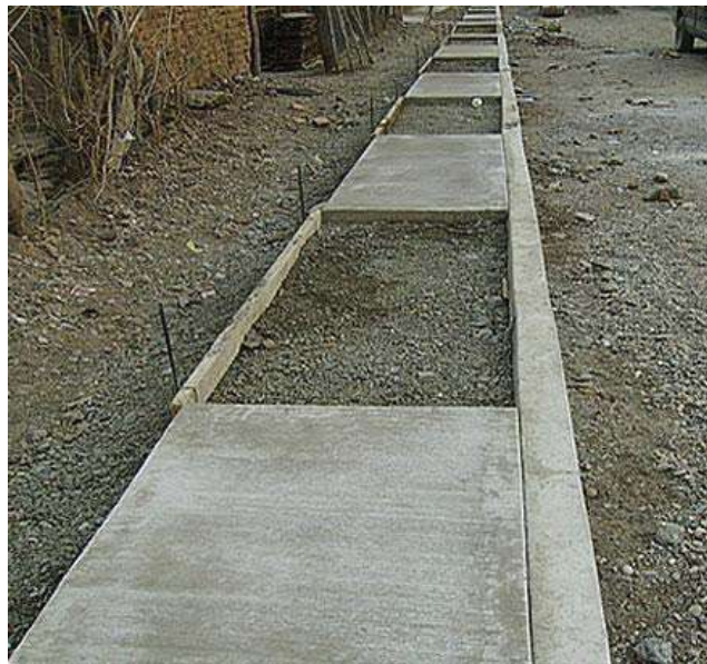
Imagen VI.22 Construcción de banquetas
