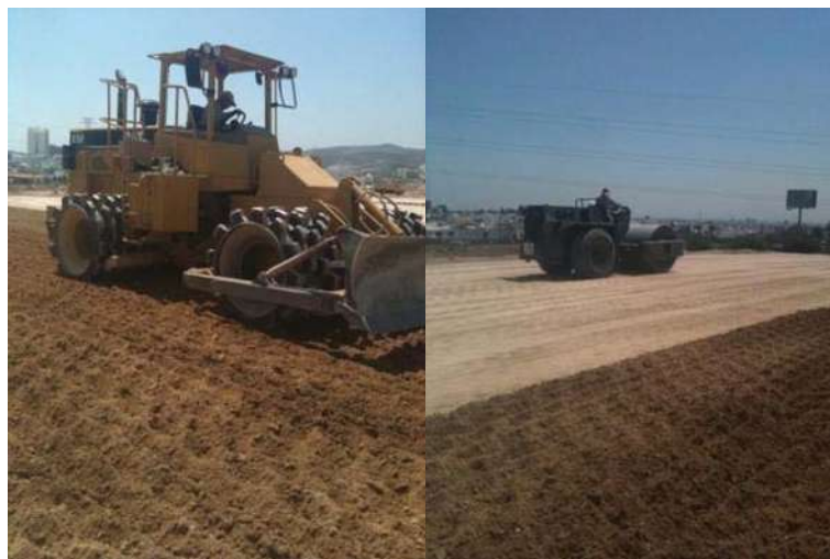
Imagen VI.17 Conformado y compactado de la subrasante
