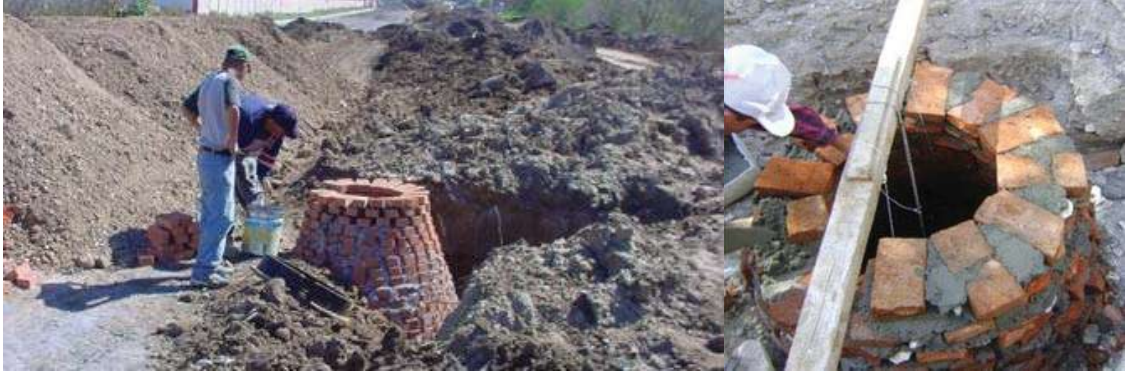
Imagen VI.12 Construcción de pozos de visita
