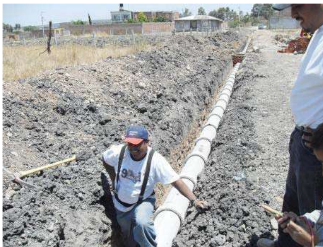
Imagen VI.11 Tendido de la tubería
