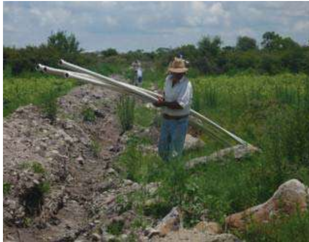
Imagen VI.14 Distribución de la tubería a lo largo de la zanja
