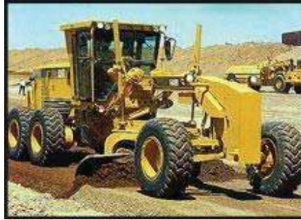
Imagen VI.19 Tendido de la subbase
