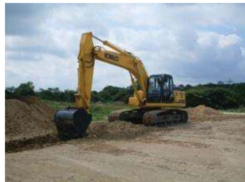
Imagen VI.10 Excavación de la zanja
