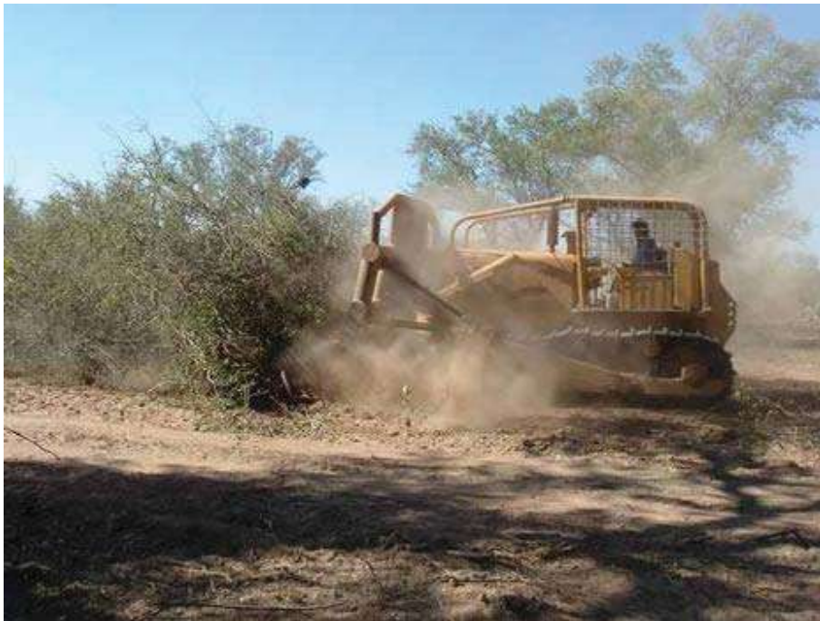
Imagen VI.3 Desmote con tractor
