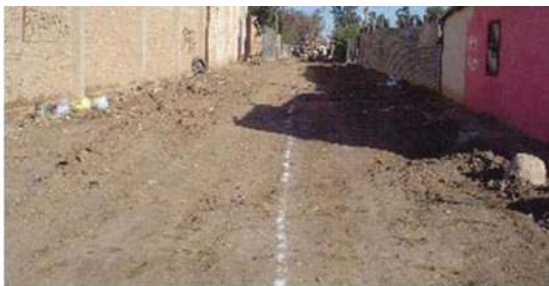
Imagen VI.9 Trazo de la línea del alcantarillado
