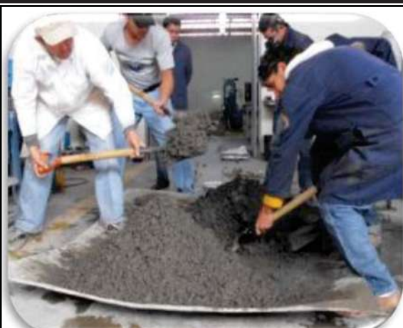
Fig. 4.3.2.3. Se agrega el agua y se revuelve toda la mezcla.
