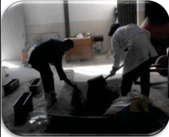
Fig. 4.3.2.1. Se revuelve el agregado pétreo con el cemento.
