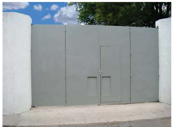
FACHADA POSTERIOR - REVILLAGIGEDO S/N
