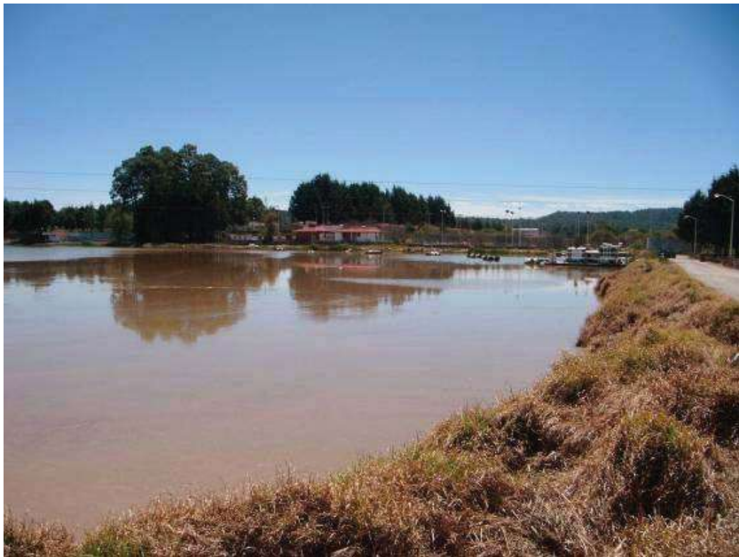
FOTOGRAFIA 6. Represa de lodos de la planta potabilizadora Los Berros (JNHA)
