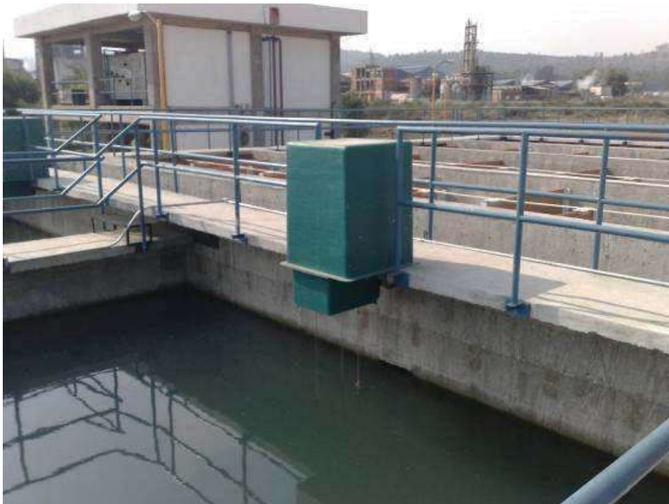
FOTOGRAFIA 30. Sedimentadores de la planta potabilizadora de la Minzita, Morelia Mich. (SEYCO).
