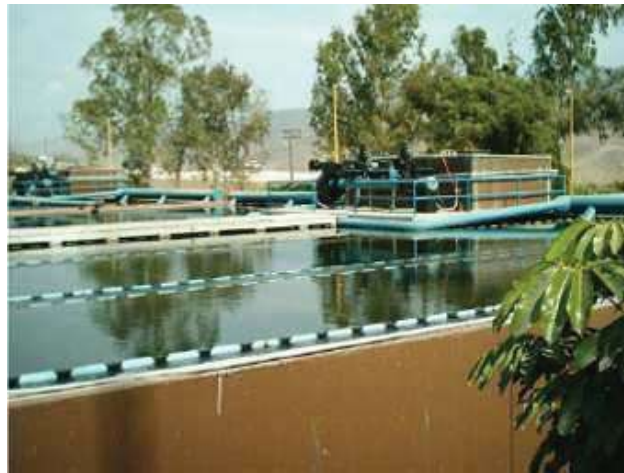
FOTOGRAFIA 13. Pulsador del módulo 1, potabilizadora el Florido Tijuana, BCN. (SEYCO "Fotografía proporcionada por La empresa Servicios y Consultores S.C.")
