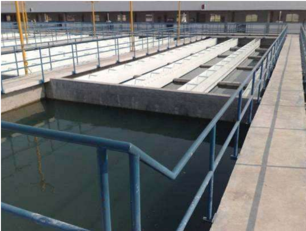
FOTOGRAFIA 30. Sedimentadores de la planta potabilizadora de la Minzita, Morelia Mich. (SEYCO).
