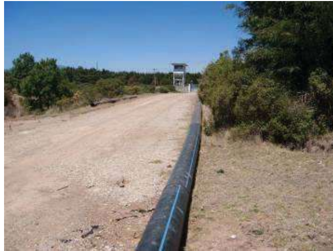
FOTOGRAFIA 7. Tubería de conducción de lodos del dragado a las tarquinas en la potabilizadora Los Berros (JNHA).
