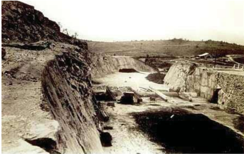
FOTOGRAFIA 19. Trabajos realizados en la Presa de Cointzio 1936 (Tomado del libro La agricultura de riego en Michoacán. Martin Sánchez.).
