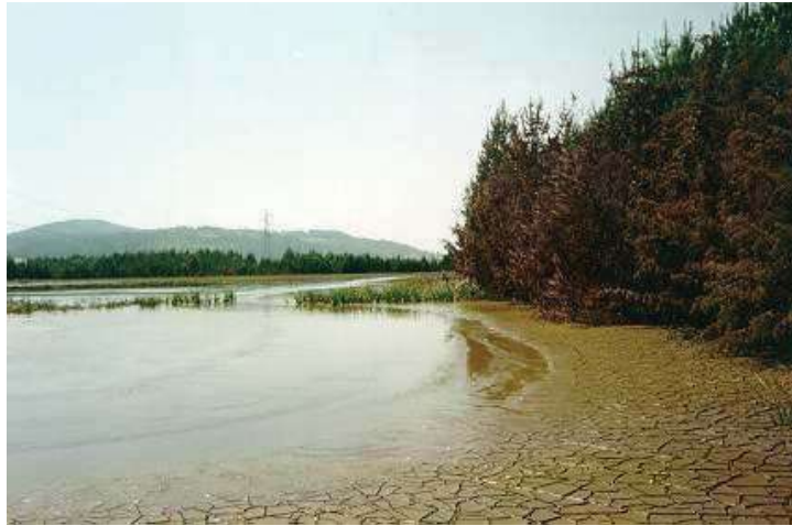
FOTOGRAFIA 5. Disposición de lodos en la represa de lodos de la potabilizadora Los berros del Sistema Cutzamala (CNA)
