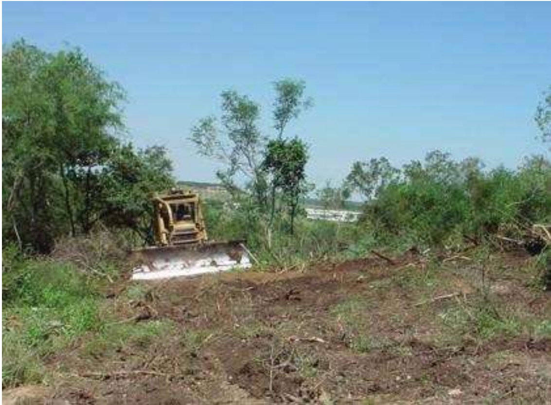
FOTOGRAFÍA 46. Desmonte de un terreno
