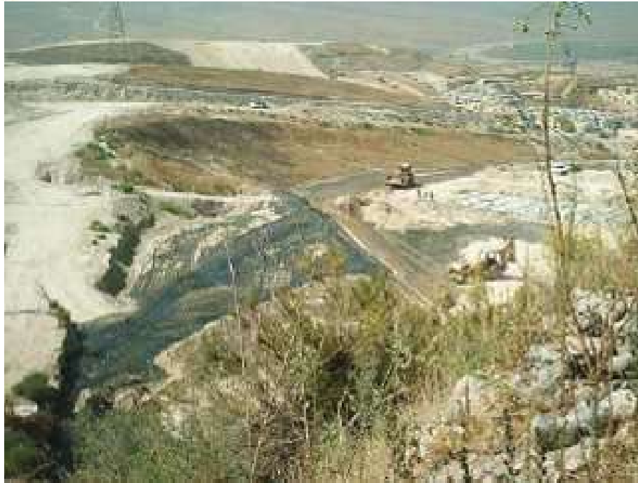
FOTOGRAFIA 17. Zona a la que se vertían los lodos de la potabilizadora el Florido. Tijuana, BCN (SEYCO).
