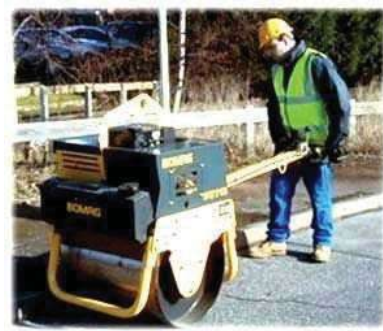
FOTOGRAFÍA 49. Compactador de mono cilindro vibratorio manual.
