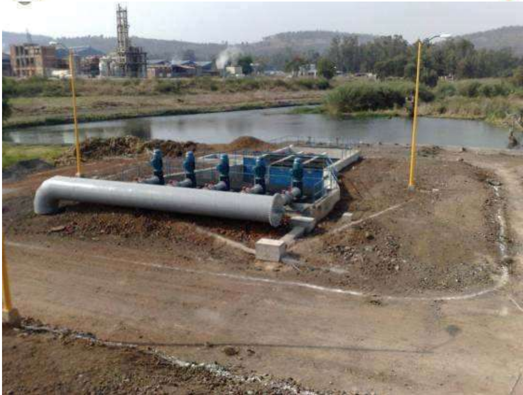
FOTOGRAFIA 28. Obra de toma de la potabilizadora de la Minzita. Morelia Mich. (SEYCO).
