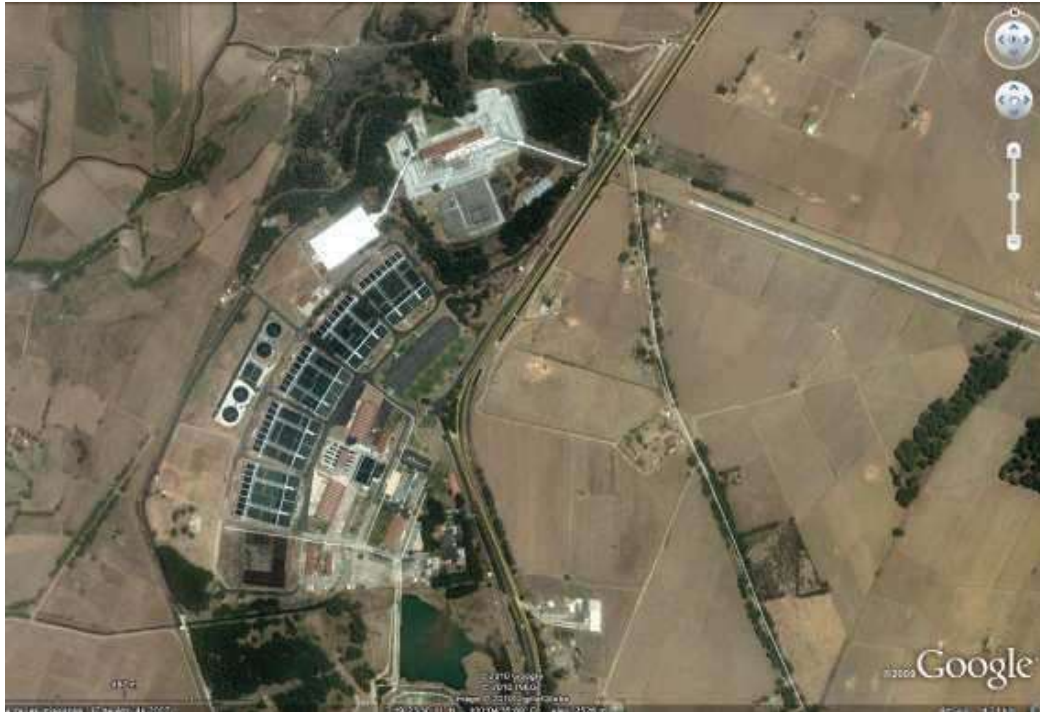
IMAGEN 2. Vista satelital de la Planta Potabilizadora Los Berros.(Google Earth)
