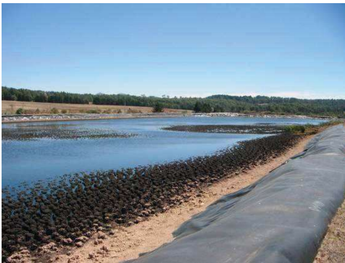
FOTOGRAFIA 35. Una de las tarquinas de lodos de la potabilizadora de Los Berros (JNHA).
