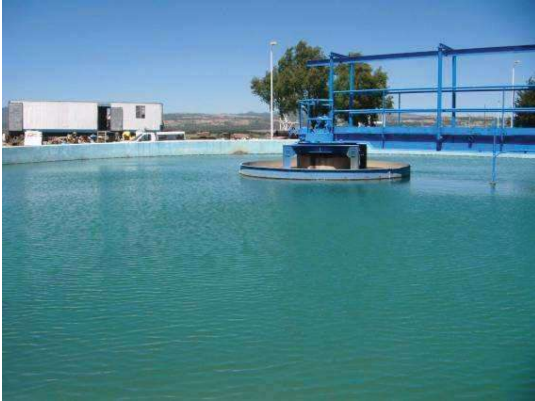
FOTOGRAFIA 4. Tanque espesador de la planta potabilizadora Los Berros del Sistema Cutzamala (JNHA).
