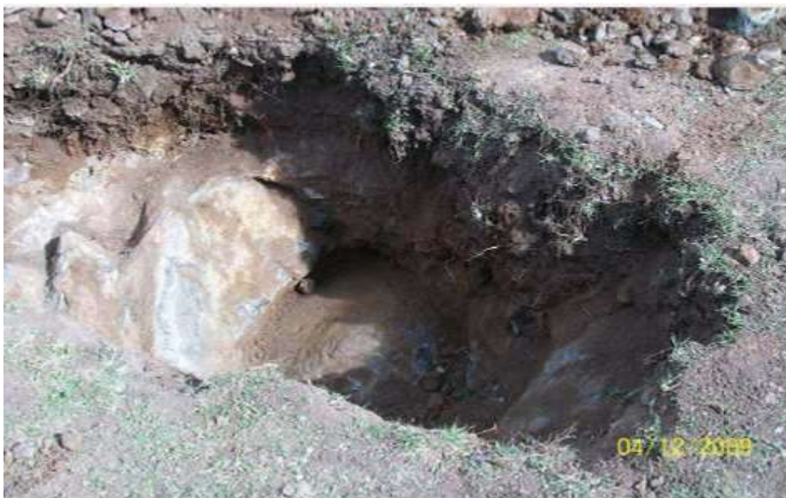
FOTOGRAFIA 42. Vista del PCA 01 (HERNA).
