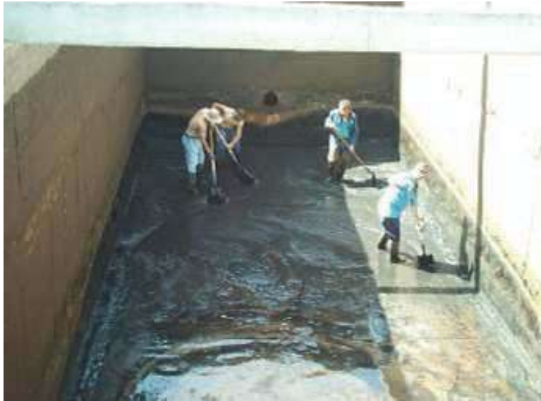
FOTOGRAFIA 15. Limpieza manual del cárcamo de recuperación de agua de lavado de filtros, potabilizadora el Florido. Tijuana, BCN. (SEYCO)
