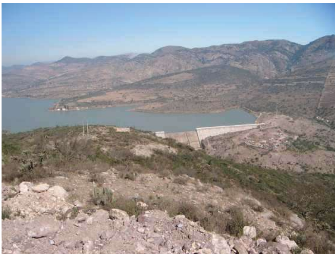
FOTOGRAFIA 1. Presa Paso de Vaqueros. (JNHA Fotografía “tomada por Joaquín Norberto Haro Alejandre”)
