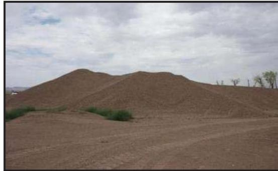
Fotografía 1.- Banco de materiales denominado como Javier Sáenz ubicado en el km 172+000 de la carretera Cd. Juárez-Janos con 6,000 metros desviación derecha en terracería y referenciado al eje de trazo con desviación derecha a 85,000 metros del Km 0+000, propuesto para ser empelado como: base hidráulica, base asfáltica, carpeta asfáltica y riego de sello.
