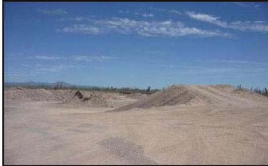
Fotografía 1.- Banco de materiales denominado como San Francisco de la Sierra ubicado en el km 1+000 de la carretera San Francisco de la Sierra-Guerrero Negro con 10,000 metros desviación izquierda en terracería y referenciado al eje de trazo con desviación derecha a 50,000 metros del Km 17+000, propuesto para ser empelado como: base hidráulica, base asfáltica, carpeta asfáltica y riego de sello.
