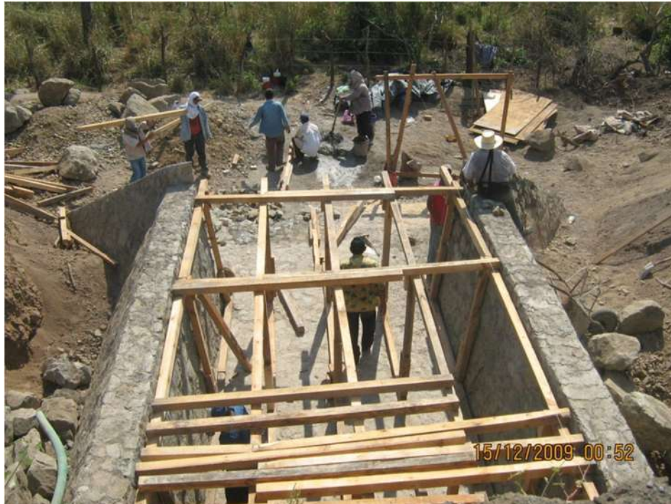
Ampliación de losa, cimbrado
