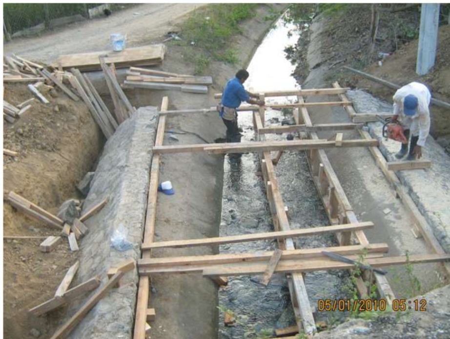
Cimbra en el canal de riego para la ampliación de losa
