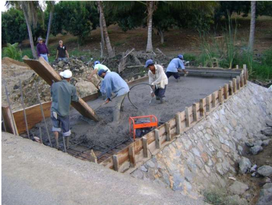
Cimbra en el canal de riego para la ampliación de losa
