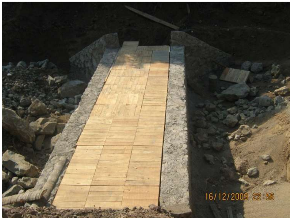
Ampliación de losa, cimbrado
