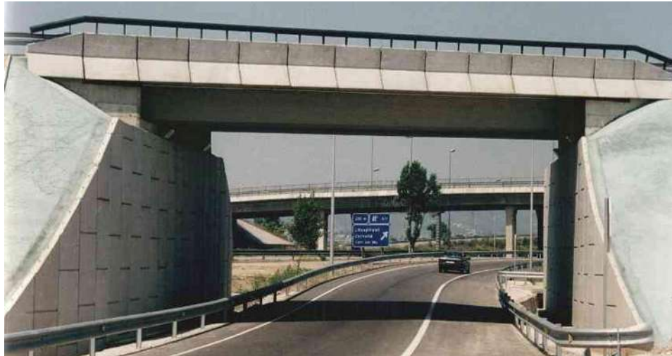
Figura 2.10 Estribos en puentes.
