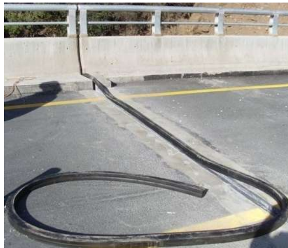
Figura 4.25 Junta de dilatación de un puente ( www.registrocdt.cl/.../IMAGENES/SL380207.JPG )
