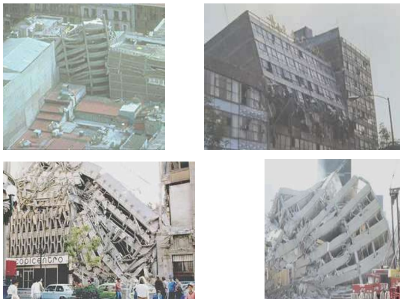
Figura 1.1 Ejemplos de edificios colapsados a causa del sismo del 19 de septiembre de 1985 que afectó la ciudad de México.
