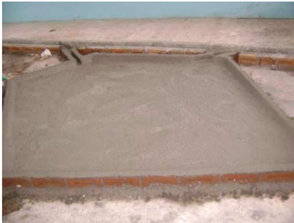
Figura 5.10: Lagunas de regulación terminada.
