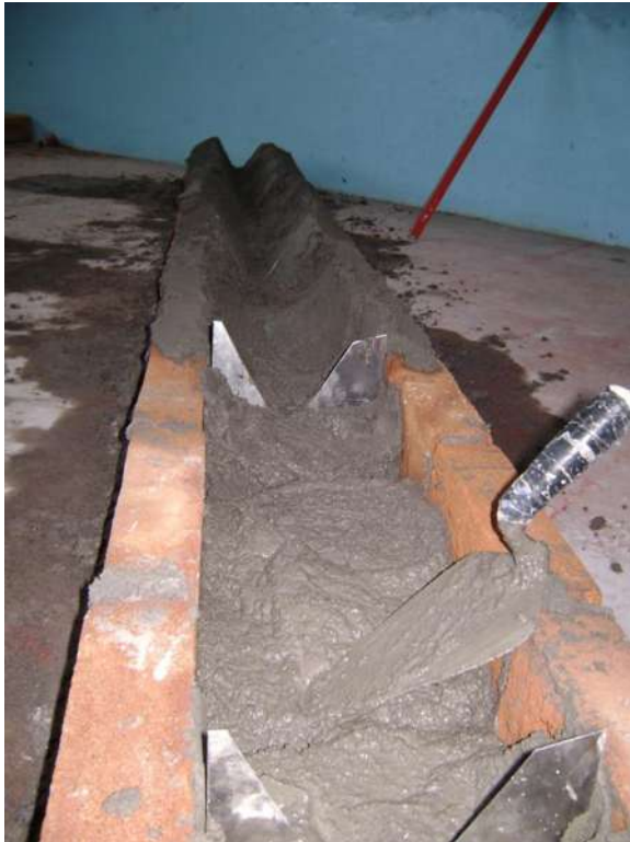
Figura 5.6: Colocación del los moldes de lamina.
