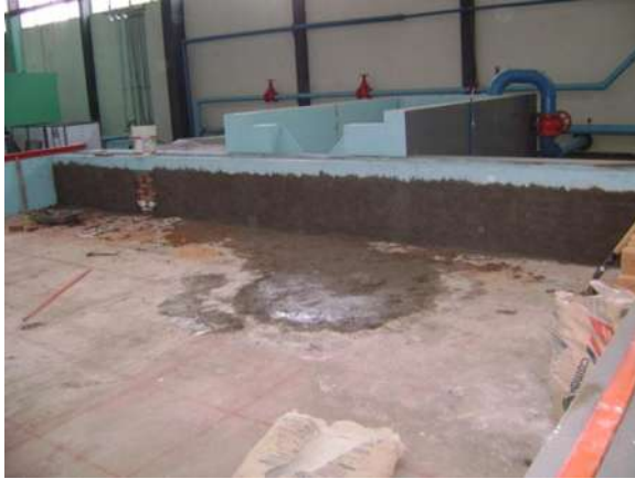
Figura 5.3: Trazo y sellado de muro.
