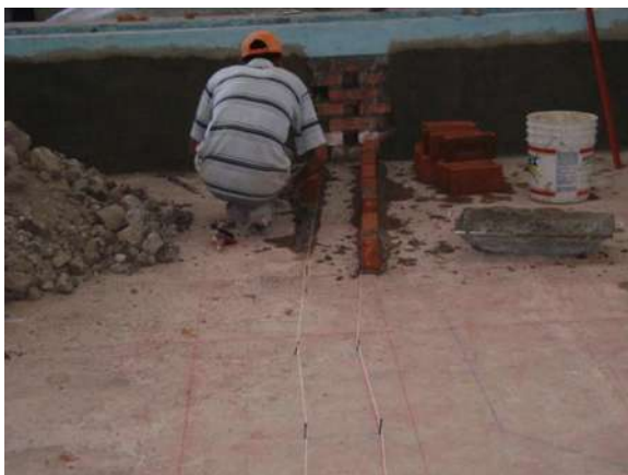
Figura 5.4: Colocacion perimetral de ladrillo.
