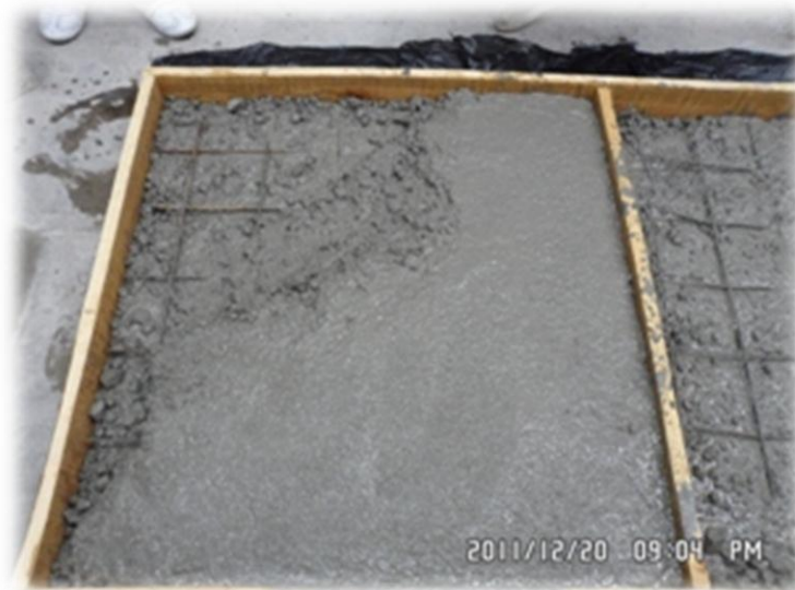
Figura 8.9.- Elaboración de la losa con malla electro soldada.
