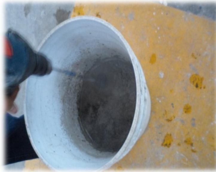
Figura 8.6.- Mezclado de los elemento para lograr un mortero.
