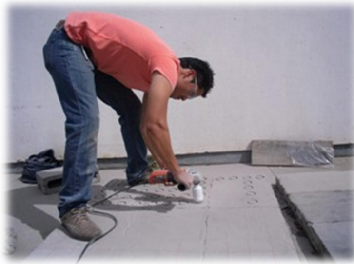
10.4.- Perforación de losas para pruebas de revestimiento.
