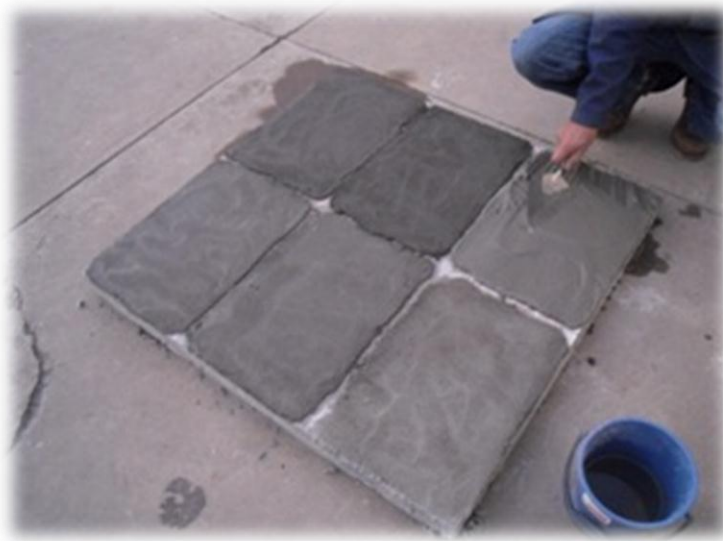
Figura 8.19.- Revestimiento de las losas.
