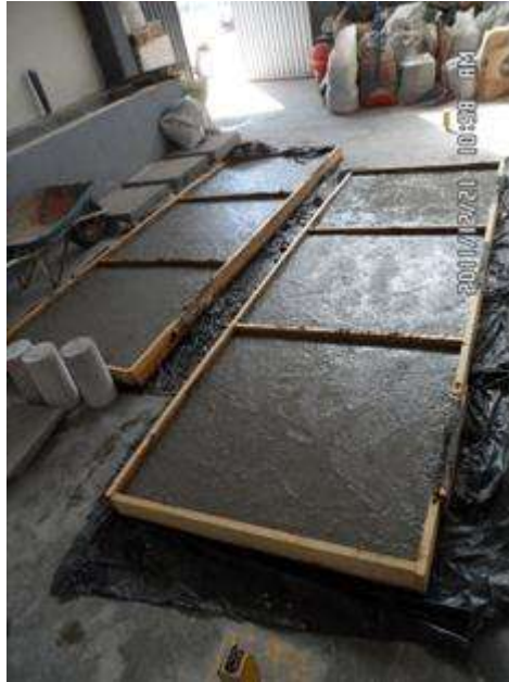
Figura 8.10. Losas para pruebas de adherencia terminadas.
