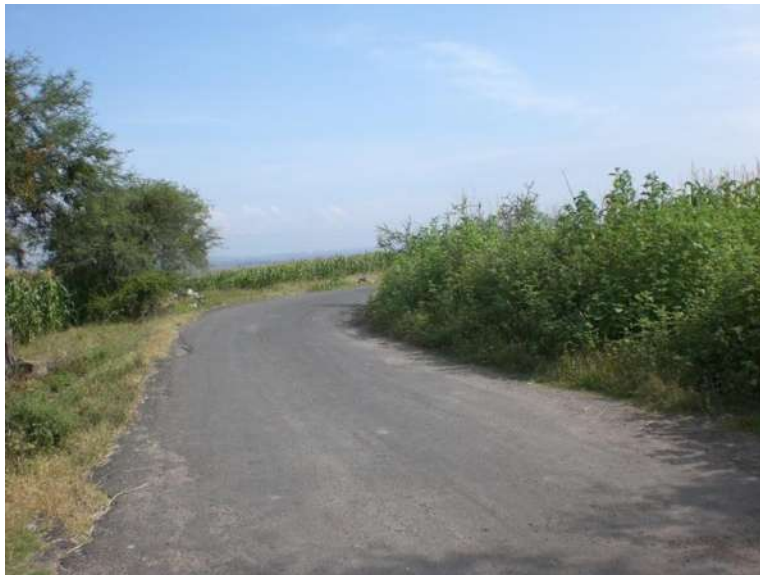
Fig. 46. Curva del km 0 + 758 al km 0 + 759.
