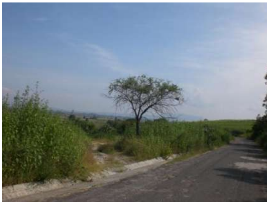
SALIDA A BRECHA. TRAMO CARRETERO INDAPARAPEO-LAS BOMBAS. KM 0+000 AL 6+480. MUNICIPIO INDAPARAPEO,
