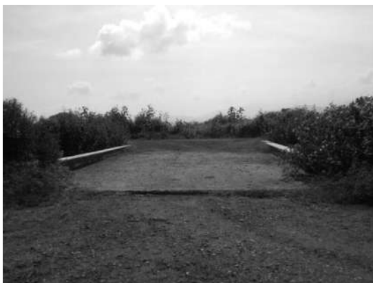
2° PUENTE. TRAMO CARRETERO INDAPARAPEO-LAS BOMBAS. KM 0+000 AL 6+480. MUNICIPIO INDAPARAPEO, MICH.
