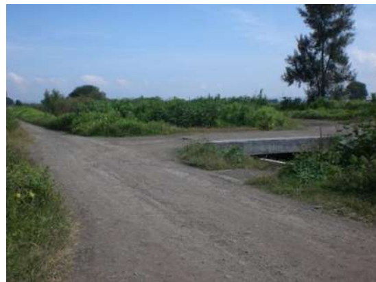
1° PUENTE. TRAMO CARRETERO INDAPARAPEO-LAS BOMBAS. KM 0+000 AL 6+480. MUNICIPIO INDAPARAPEO, MICH.
