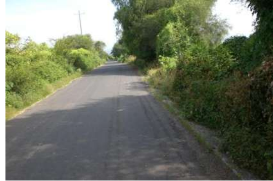
TRAMO CARRETERO INDAPARAPEO-LAS BOMBAS. KM 0+000 AL 6+480. MUNICIPIO INDAPARAPEO, MICH.
