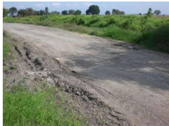
PRINCIPIA TRAMO DE TERRACERÍA. TRAMO CARRETERO INDAPARAPEO-LAS BOMBAS. KM 0+000 AL 6+480. MUNICIPIO INDAPARAPEO, MICH.
