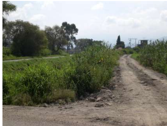
TERMINA CAMINO. TRAMO CARRETERO INDAPARAPEO-LAS BOMBAS. KM 0+000 AL 6+480. MUNICIPIO INDAPARAPEO,
