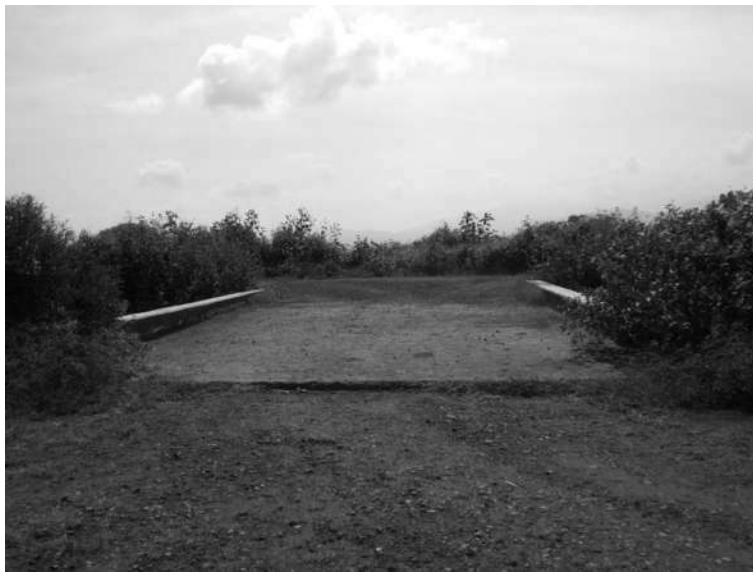
Fig. 53. Camino en el km 4 + 500.
