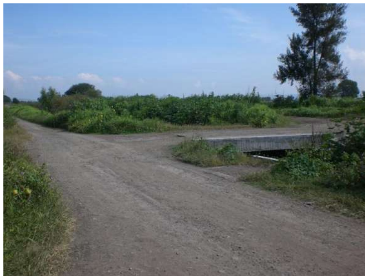
Fig. 52. Camino en el km 4 + 500.
