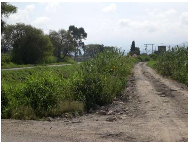
Fig. 58. Camino en el km 6 + 400 al km 6 + 480.
