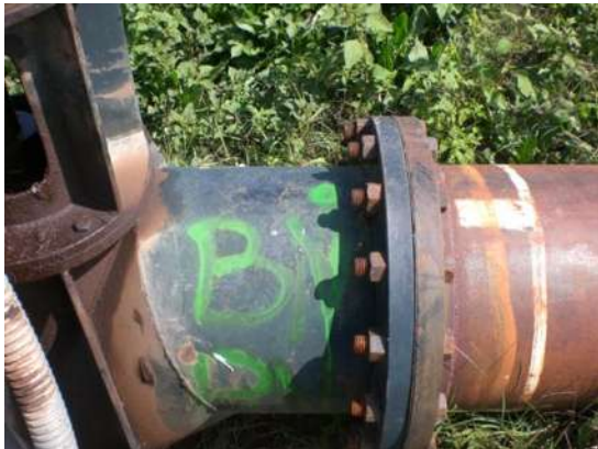
BANCO DE NIVEL. TRAMO CARRETERO INDAPARAPEO-LAS BOMBAS. KM 0+000 AL 6+480. MUNICIPIO INDAPARAPEO, MICH.
