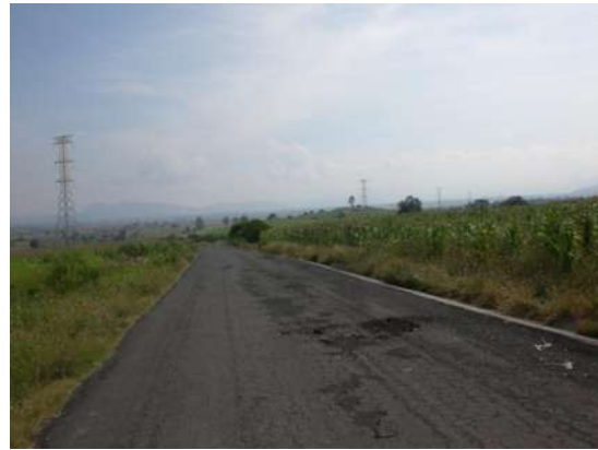
TRAMO CARRETERO INDAPARAPEO-LAS BOMBAS. KM 0+000 AL 6+480. MUNICIPIO INDAPARAPEO, MICH.
