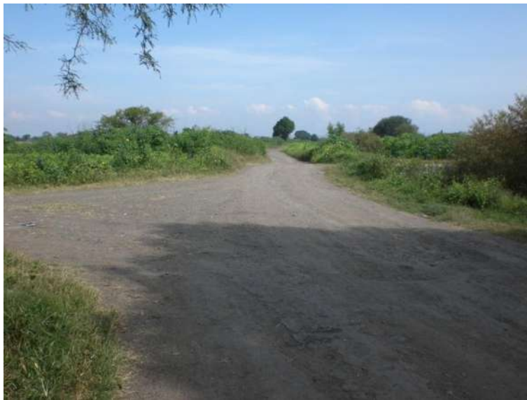
Fig. 49. Camino en el km 2 + 600.
