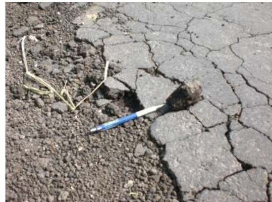
CAPA ASFÁLTICA. CAMINO INDAPARAPEO-LAS BOMBAS. KM 0+000 AL 6+480. MUNICIPIO INDAPARAPEO,
