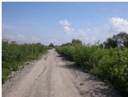
CAMBIA TIPO DE TERRACERÍA. TRAMO CARRETERO INDAPARAPEO-LAS BOMBAS. KM 0+000 AL 6+480.
