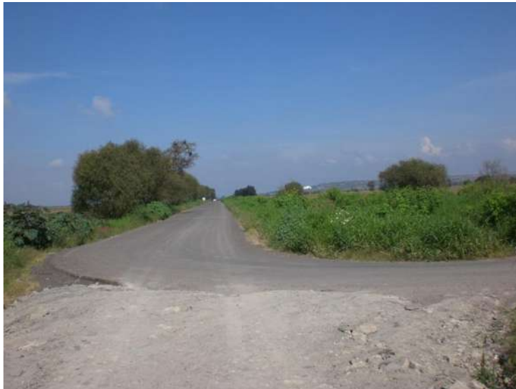
Fig. 57. Camino en el km 6 + 400 al km 6 + 480.
