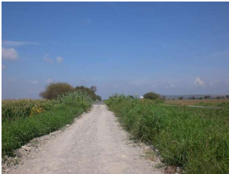
Fig. 56. Camino en el km 6 + 400 al km 6 + 480.
