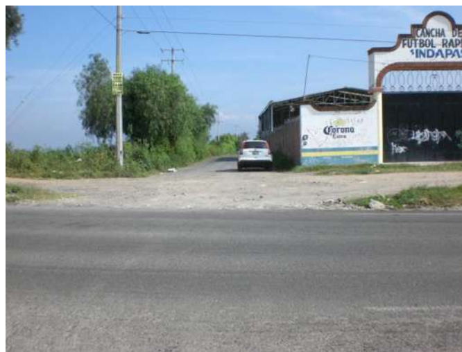
Fig. 40. Inicio del camino Indaparapeco- Las Bombas km 0 +000.
