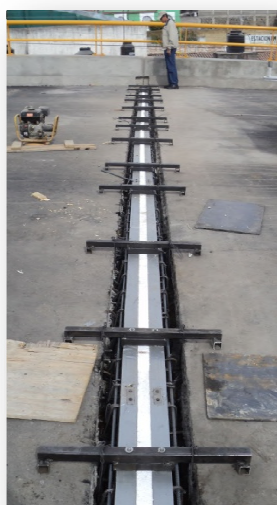
JUNTA DE CALZADA TIPO "WOSD 50"
