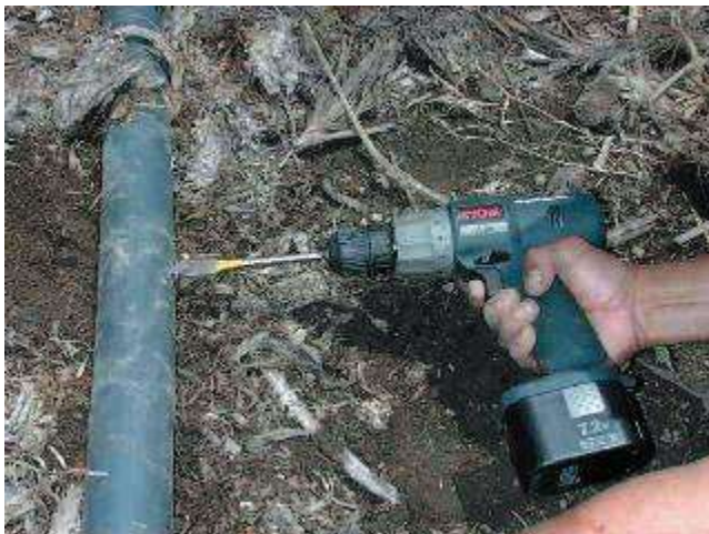
Figura 5.52. Perforación de manguera principal de polietileno. (Medina, 2002).
