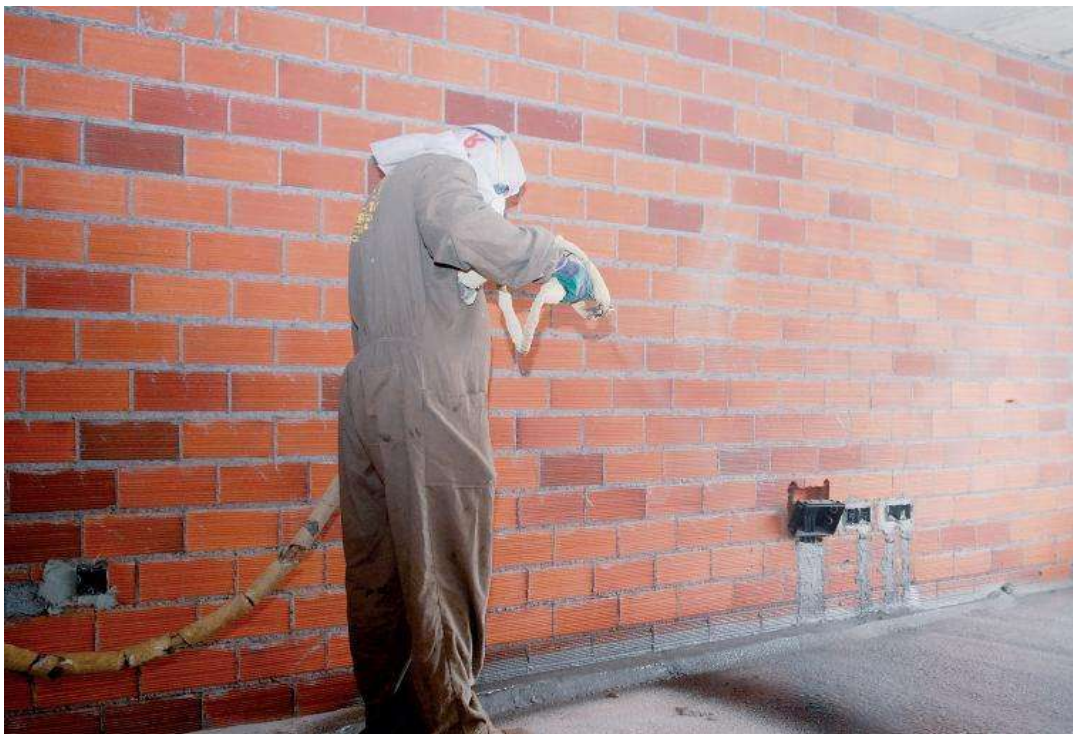
Figura 5.27. Aplicación de poliuretano lanzado en azotea (Santa Cruz, 2011).
