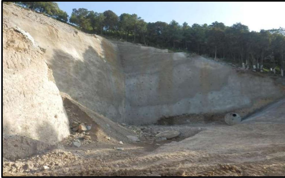
Figura 1.5 Vista del Portal de Entrada en obra.
