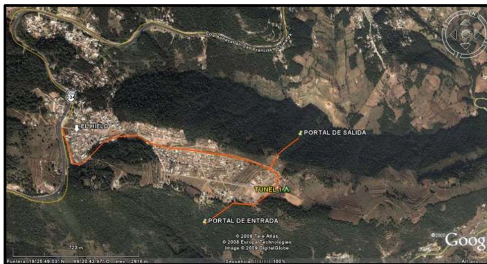
Figura 1.4 Vista de Accesos a la Zona de los Portales.
