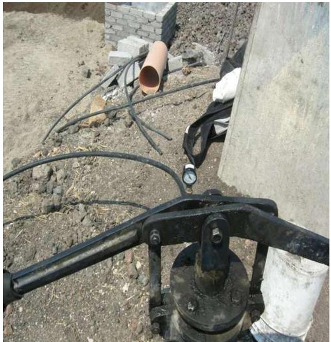
7.-En estas fotos se aprecia parte de la colocación de la tubería así como el atraque para la prueba de tubería también nos presenta la construcción de una caja de válvulas así como el manómetro de una prueba de tubería a 6 kg.
