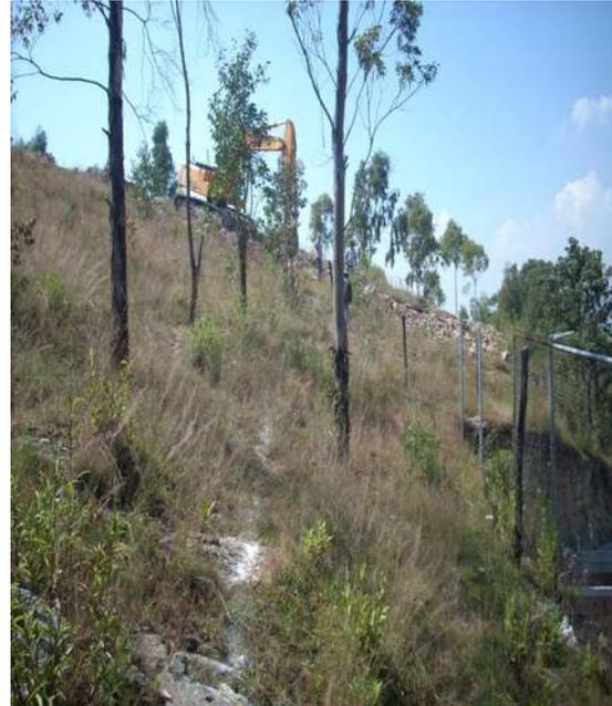
2.- se traza la línea por dónde va a pasar la línea de conducción y enseguida se hace un levantamiento de nivelación para ver el perfil del terreno y poder calcular la volumetría requerida y para trazar por dónde la maquinaria escavara.
