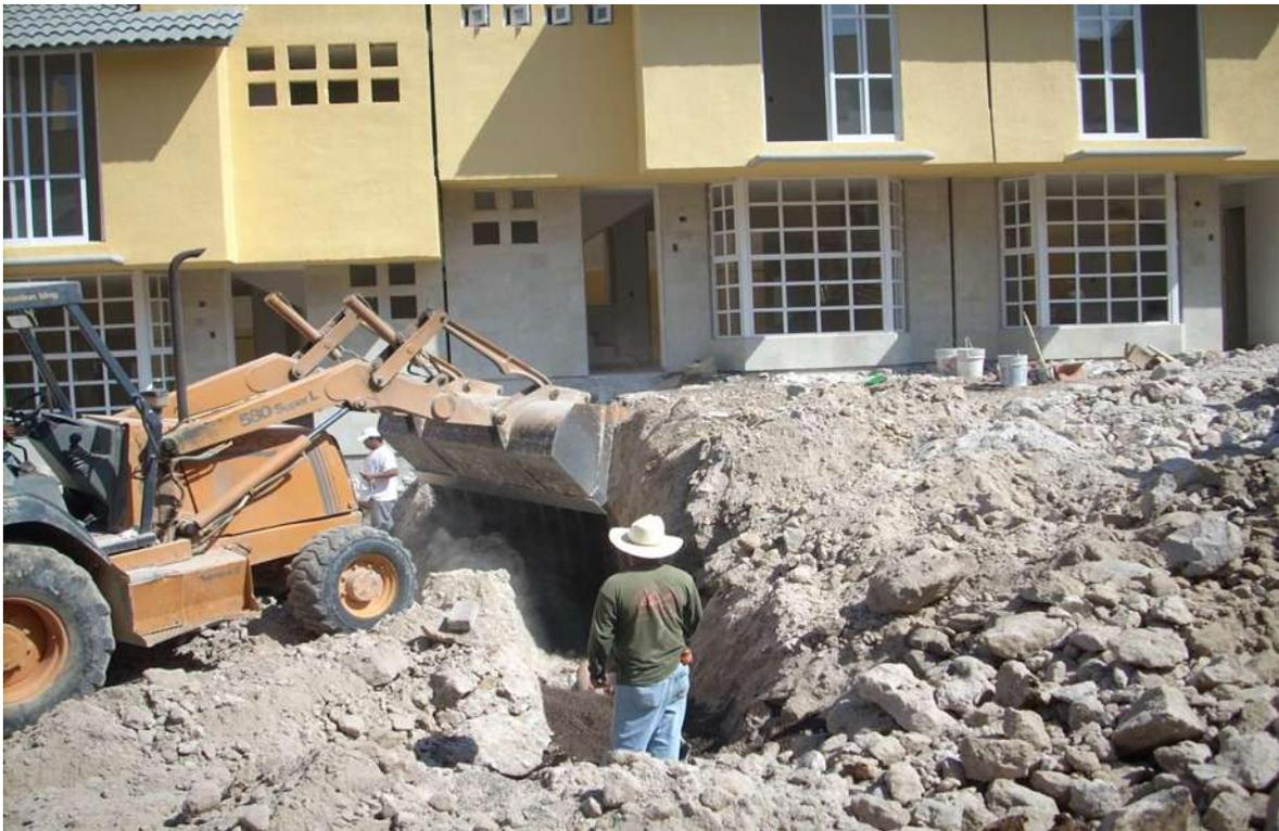
5.- se coloca una cama de arena para sentar el tubo después se acostilla la tubería con arena y al final se coloca un colchón de arena para que al taparlo con material de excavación no le caiga alguna piedra y lo pueda fracturar y para que cuando se realice alguna excavación la gente al encontrar la arena sea una señal de que se encuentra cerca el tubo y no lo dañen.
