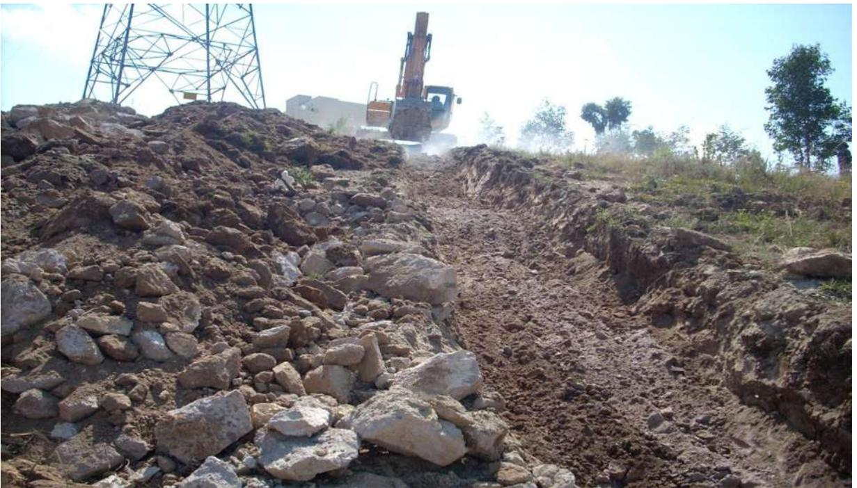
3.- se realiza la excavación por donde se trazó la línea cuidando que la profundidad sea la adecuada si es posible se escava un poco más si el terreno es duro ya que con gente sería más tardado y más costoso y para poder meter nuevamente la maquinaria tendríamos que volver a rellenar la sepa para poder volver a excavar.
