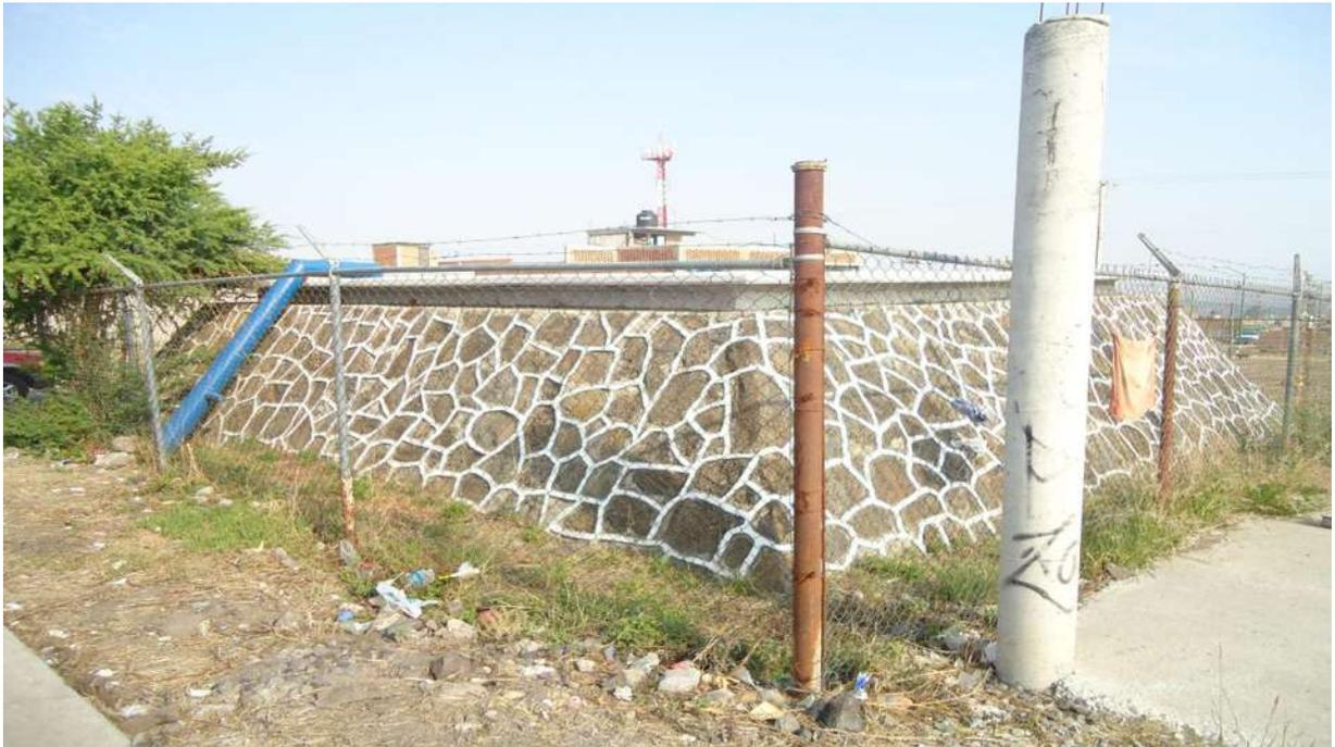
10. Tanque de regularización para abastecer la zona baja del fraccionamiento C.I.M.A. y de ahí bombear a las otras dos zonas.
