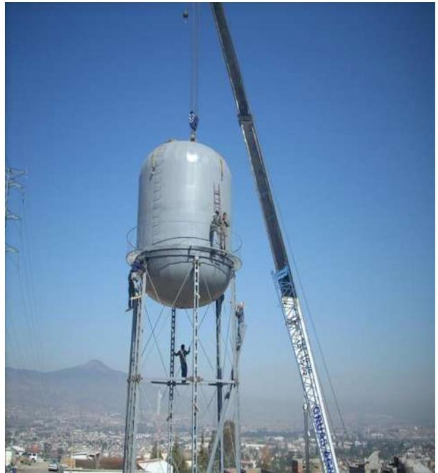
6.-En estas fotografías se ve la cimentación para un tanque elevado así como la estructura de acero y la colocación del tanque.
