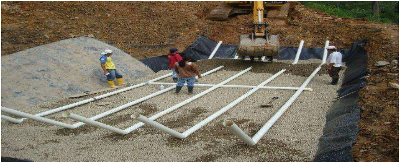
Figura 3.20 Instalación del dren de lixiviados en franja.
