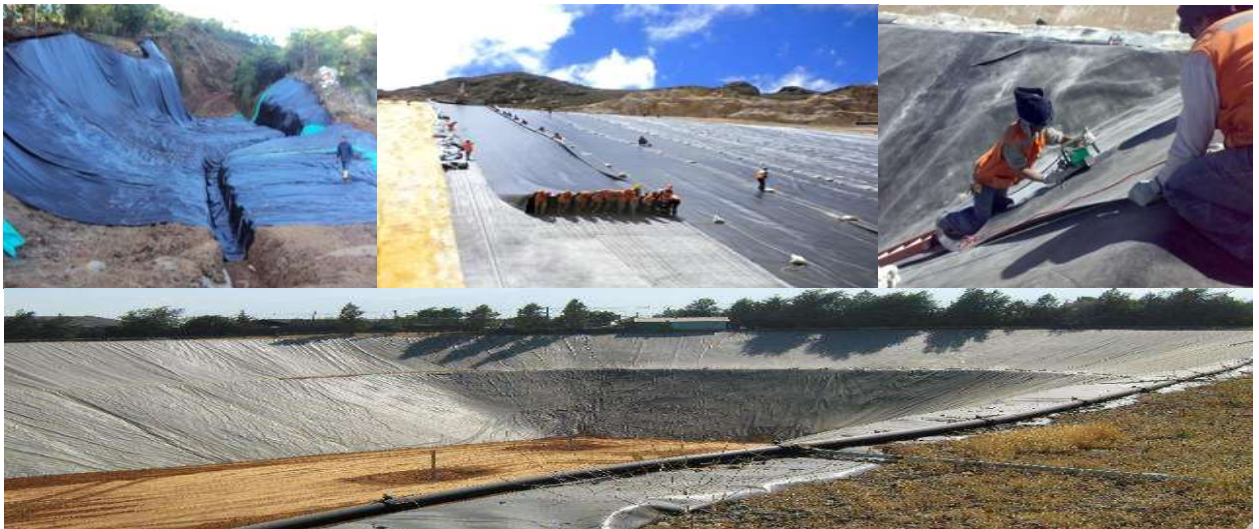
Figura 3.18 Instalación adecuada de geomembrana.
