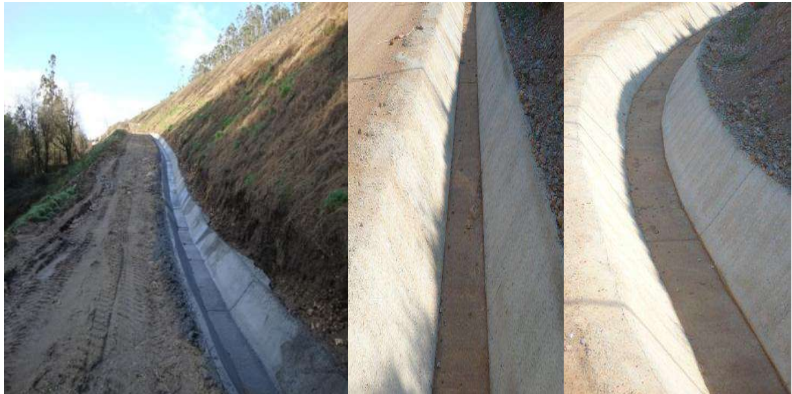
Figura 3.17 Berma y cunetas perimetrales al predio del relleno.
