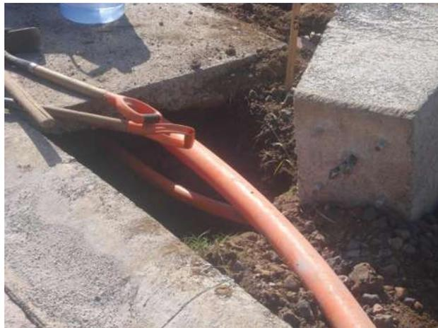
Sobre el ducto se colocará una capa de concreto (solo a entrada y salida del registro 1.5m.de distancia), misma que cumplirá con las especificaciones de CFE.
