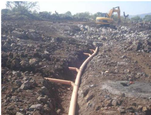
Una vez realizada la excavación se verificara con el apoyo del topógrafo los niveles de plantillas, de cepas, de pozos de visita y nivel de arrastre de tubos según pendientes de proyectos, para posteriormente proceder a la colocación de la tubería y el forjado de pozos de visita,
