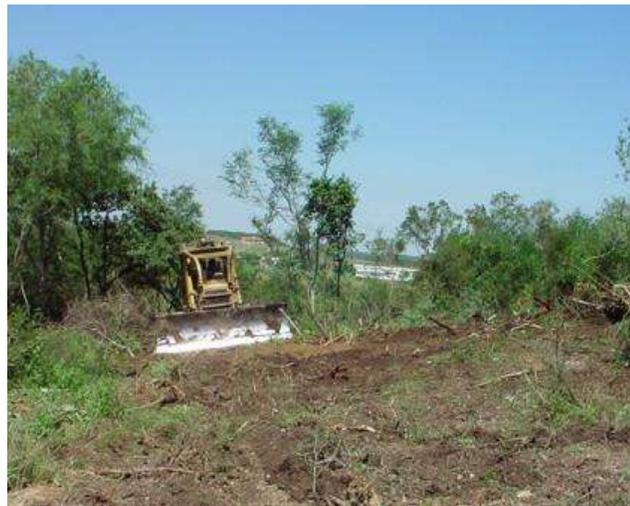
✚ El Topógrafo marco en las estacas previamente colocadas, la profundidad de corte y alturas de terraplenes especificados en el proyecto respectivo (vialidades, banquetas, plataformas de manzanas, cepas y pozos).
