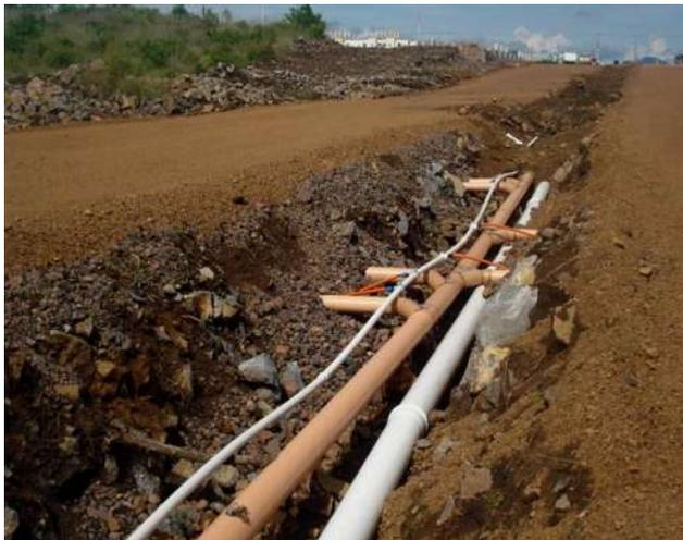
Construidas las redes de drenaje y agua potable se procedió a verificar el adecuado funcionamiento de estas, debiéndose realizar las pruebas de carga especificadas en las normas oficiales del oopas
