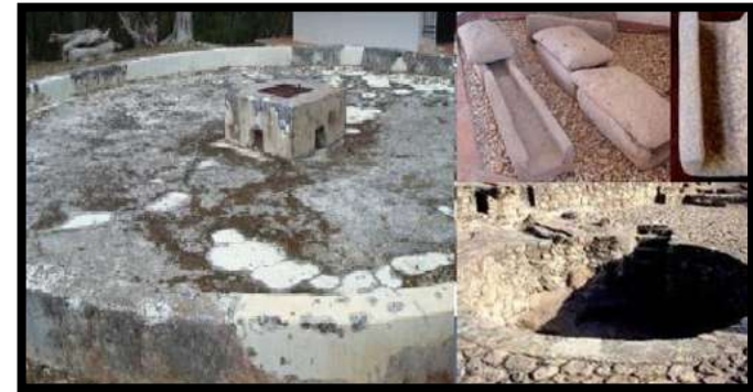
IMAGEN 2.4 ELEMENTOS DEL CHULTUN: ÁREA DE CAPTACIÓN, CANALETAS Y DEPÓSITO.
