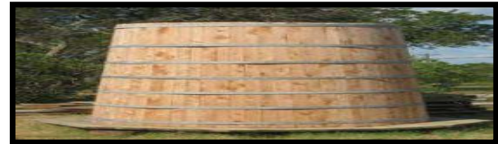
IMAGEN 3.13. CISTERNA DE MADERA DE PINO CON TENSORES, PARA ALMACENAR 5 M 3
