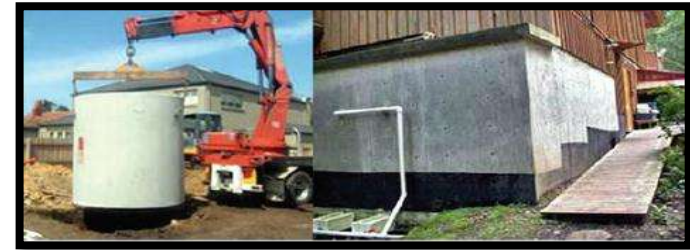
IMAGEN 3.8. TANQUE DE CONCRETO.
