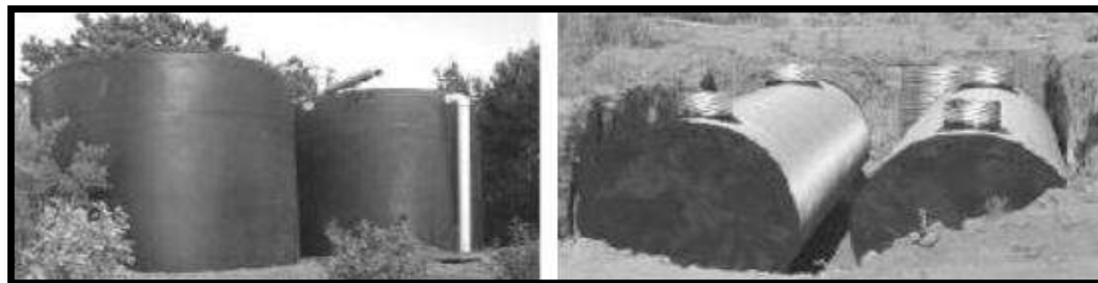
IMAGEN 3.6. TANQUES SUPERFICIALES DE PVC Y TANQUES ENTERRADOS DE LÁMINA GALVANIZADA.
