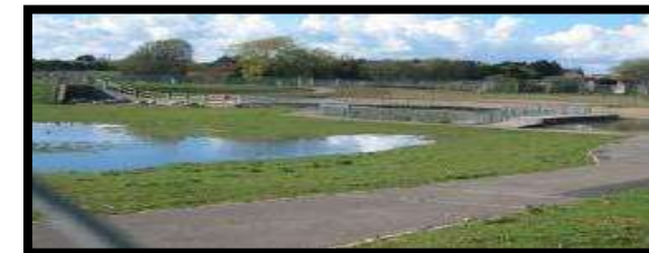
IMAGEN 2.22. DEPÓSITOS DE INFILTRACIÓN.
