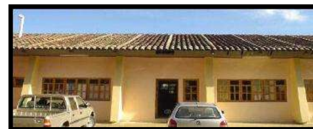
IMAGEN 3.1. ÁREA DE CAPTACIÓN DE AZULEJOS DE CERÁMICA DE ARCILLA.
