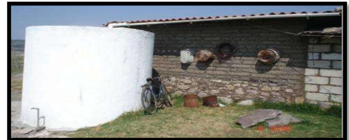
IMAGEN 3.7. TANQUE DE FERROCEMENTO.
