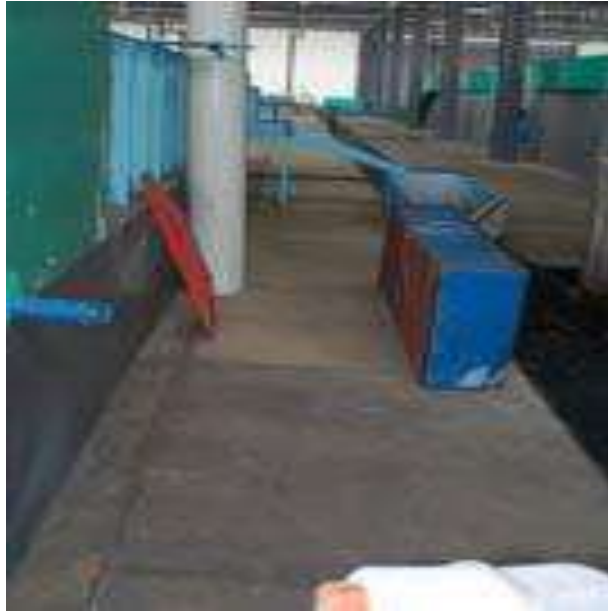
Figura 5.2. Lugar donde se tendió la tubería.
