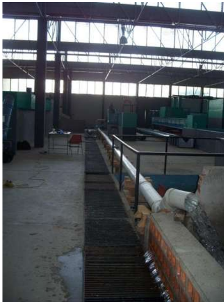
Figura 6.9. Vista panorámica de la tubería de 8".
