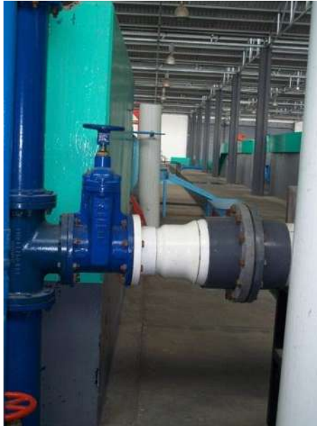
Figura 3.8 Válvula con la que se regulo el gasto.
