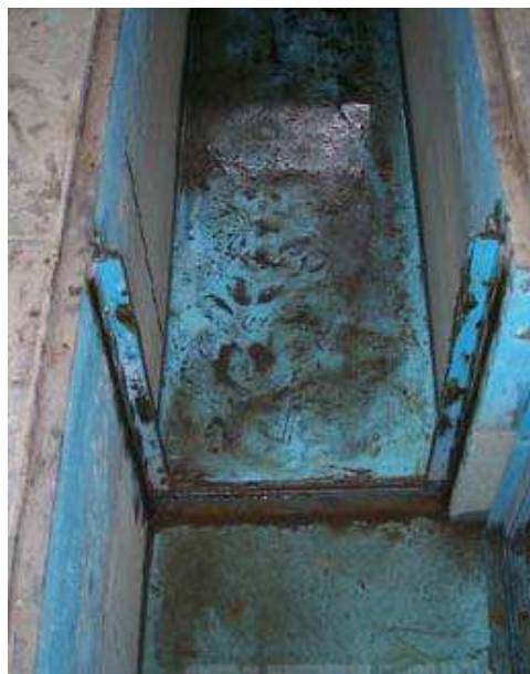
Figura 3.7 Lugar de la obturación del canal.
