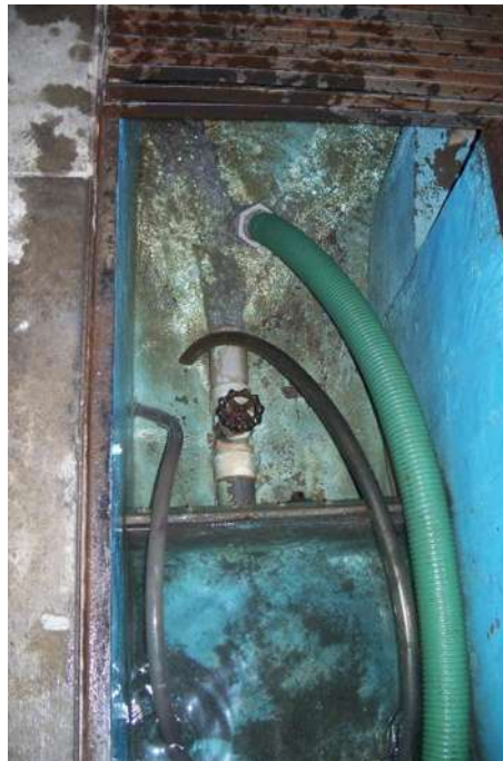
Figura 3.11 Válvula para desfogue del canal.
