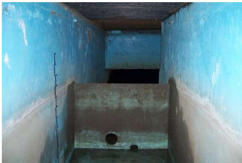
Figura 3.5 Vertedor rectangular y escala.
